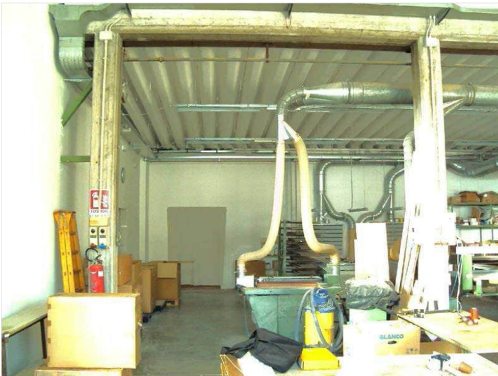
Foto n. 36: interno blocco (B1)
