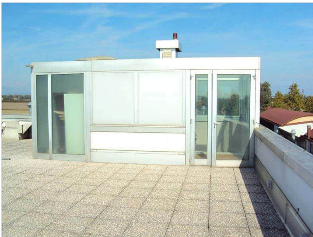
Foto n. 68: copertura blocco (F) volume vano scala
