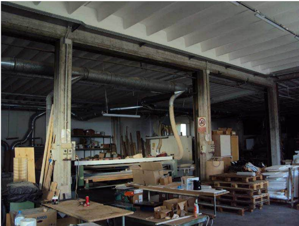
Foto n. 35: interno blocco (B1)
