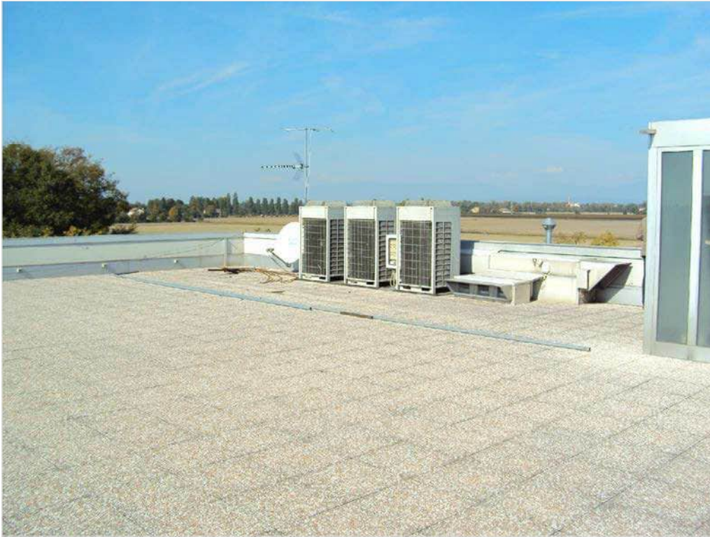
Foto n. 69: copertura blocco (F)
