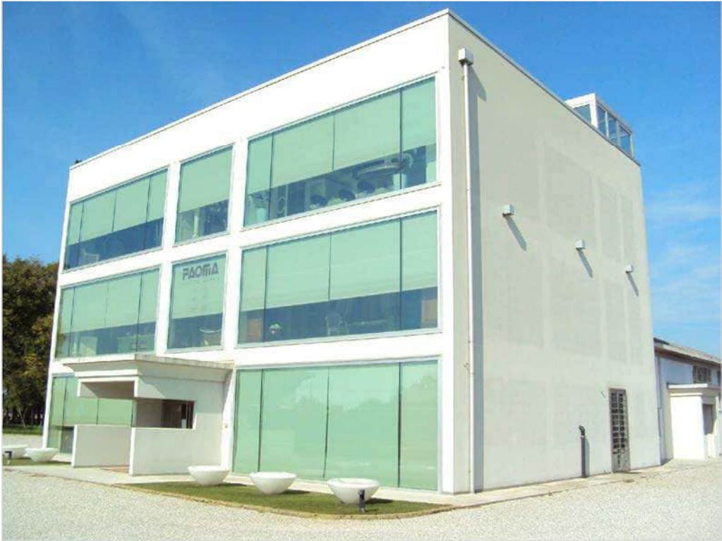
Foto n. 1: prospetto sud verso Via Callalta
