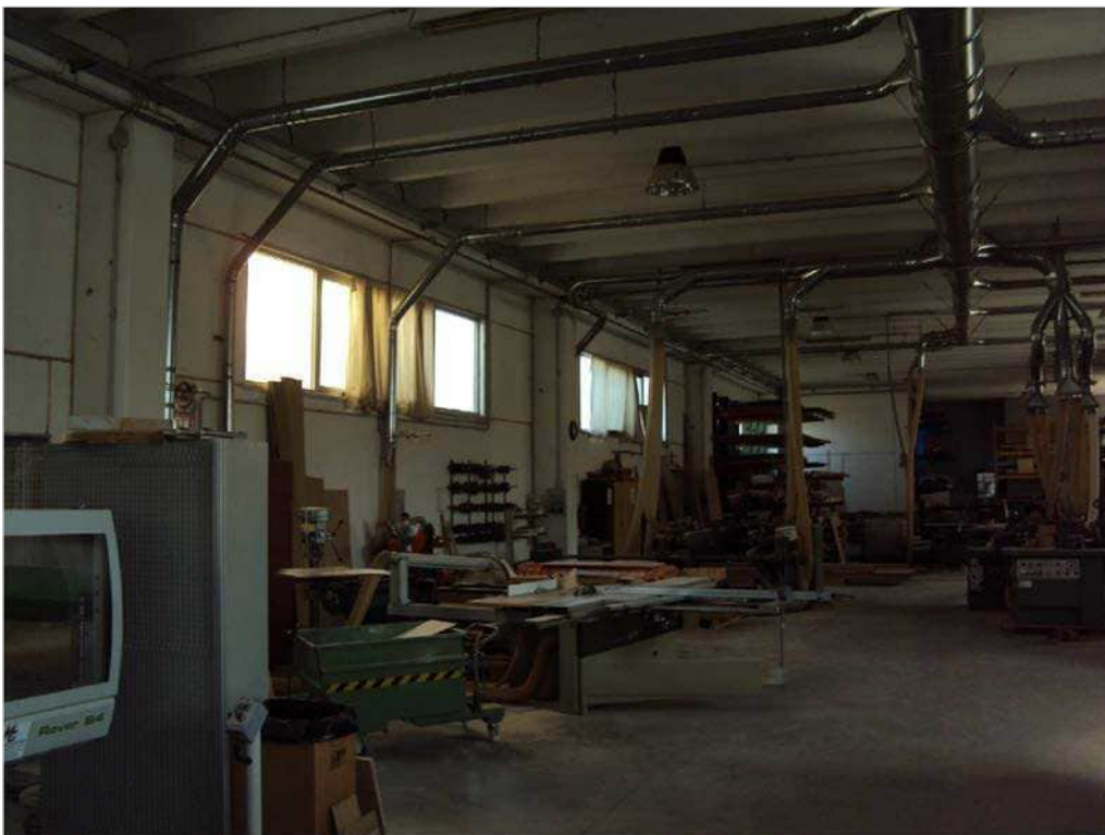
Foto n. 44: interno blocco (E)
