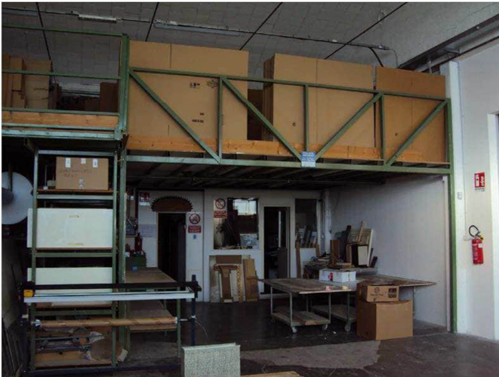
Foto n. 29: interno blocco (A) deposito zona soppalcata
