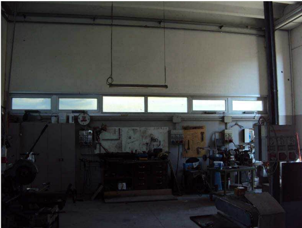
Foto n. 47: interno blocco (E) officina meccanica
