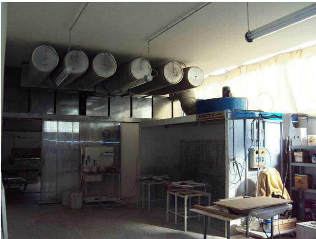
Foto n. 38: interno blocco (C) locale verniciatura
