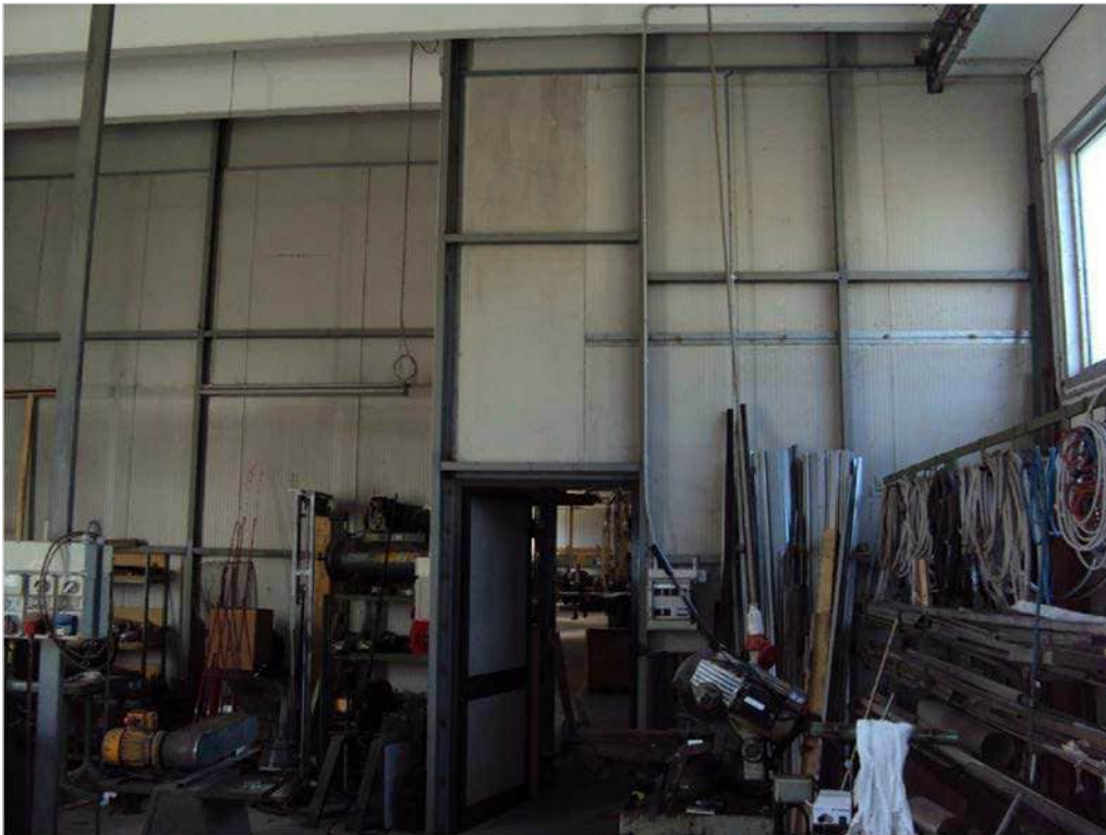
Foto n. 48: interno blocco (E) officina meccanica
