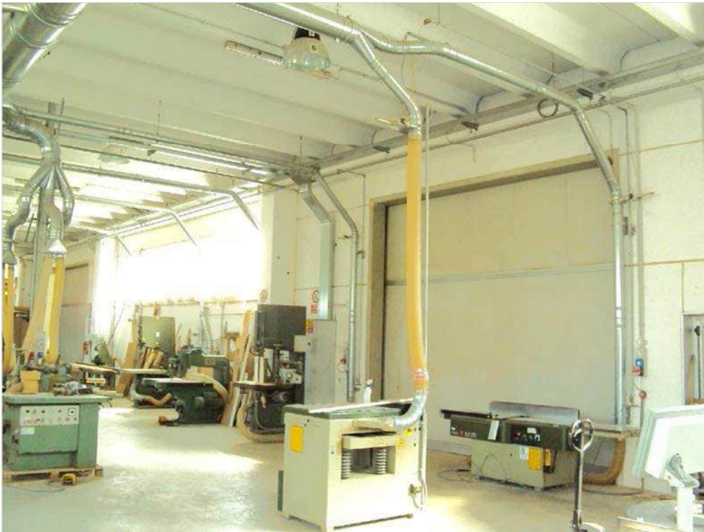
Foto n. 45: interno blocco (E)
