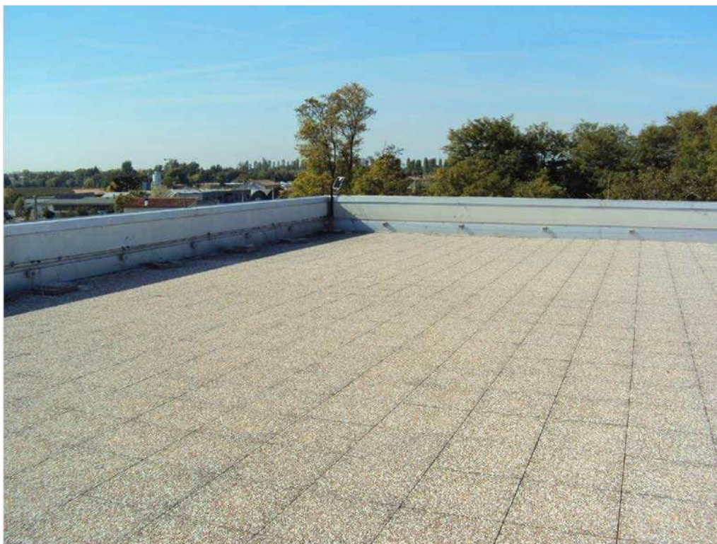
Foto n. 67: copertura blocco (F)
