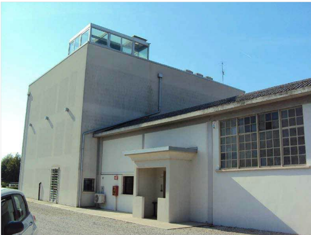
Foto n. 22: prospetto est, ingresso uffici
