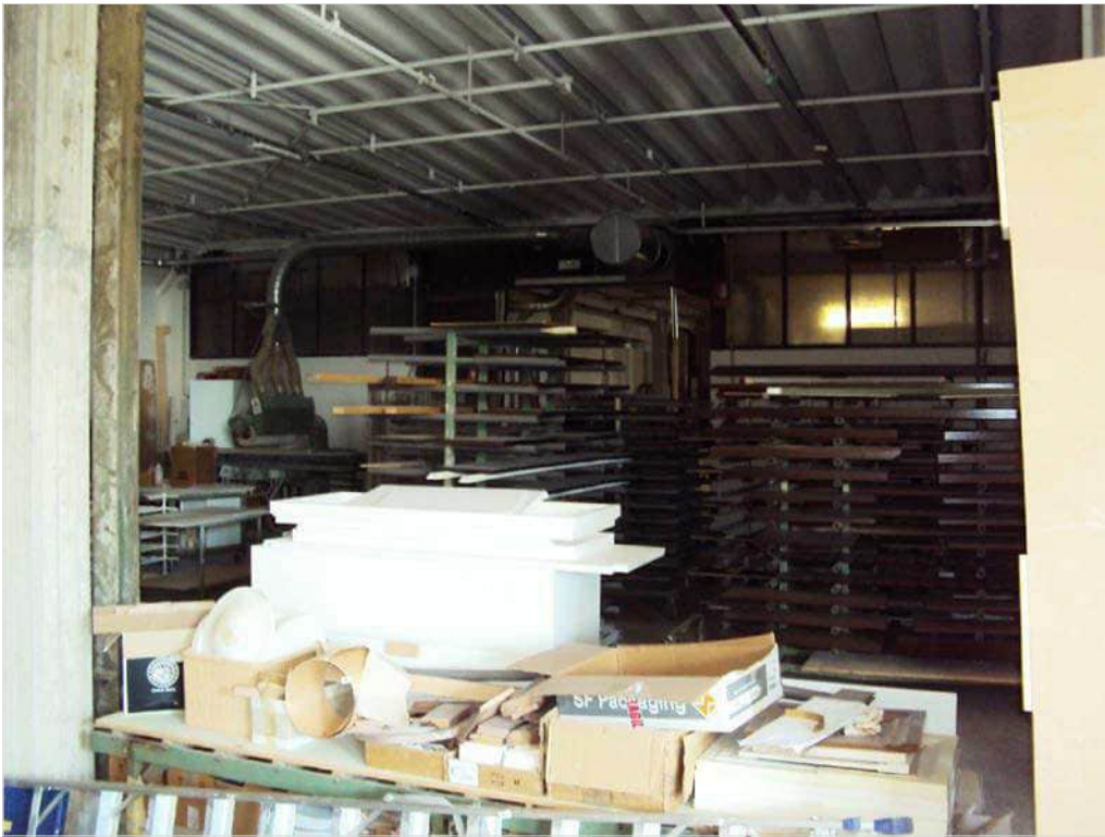
Foto n. 37: interno blocco (C)
