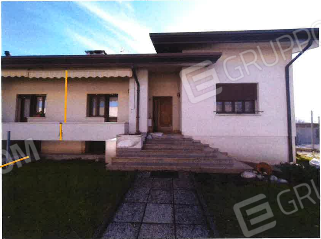
4.) ingresso piano primo
