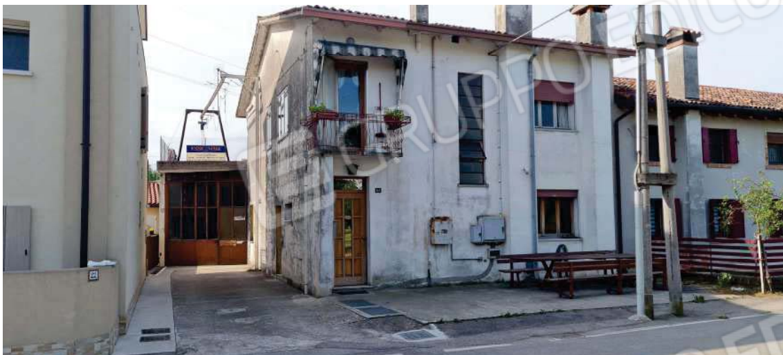
Lato nord - accesso pedonale e carraio principale da strada comunale e lastrico solare
