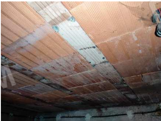
Particolare del soffitto della cantina
