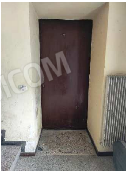
Vista portone ingresso appartamento
