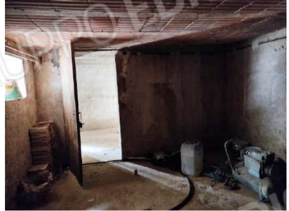
Vista della cantina verso la porta di ingresso
