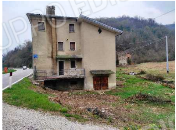
Vista lato nord
