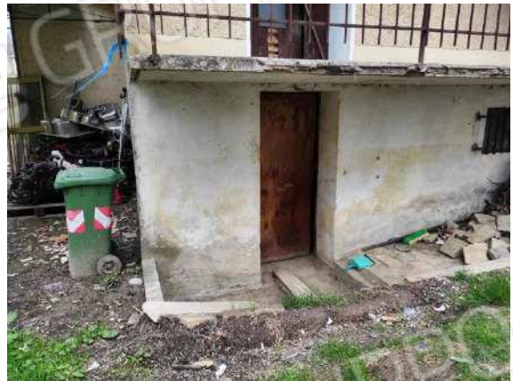
Particolare ingresso magazzini piano interrato
