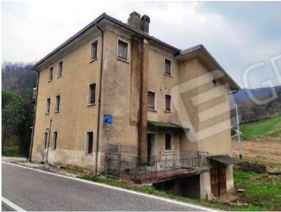
Vista lati nord ed est
