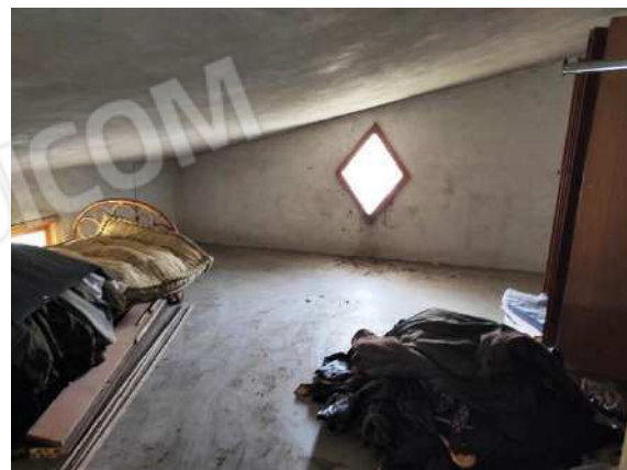
Particolare sottotetto mapp. 688 sub 4
