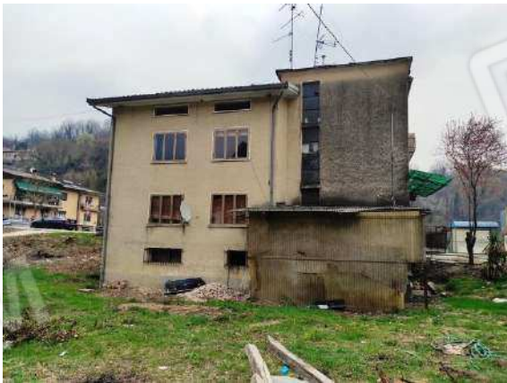
Vista lato ovest
