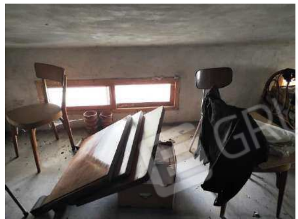
Particolare sottotetto mapp. 688 sub 4
