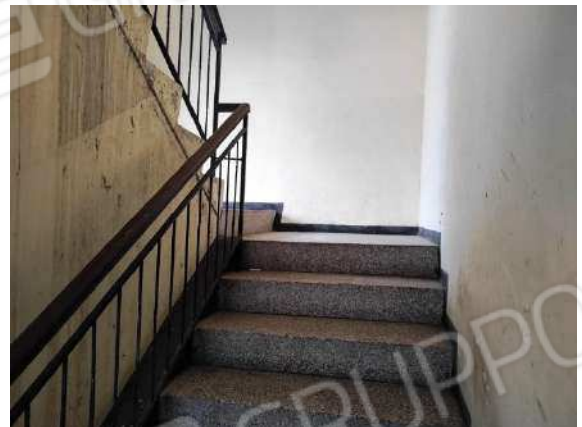
Particolare vano scala
