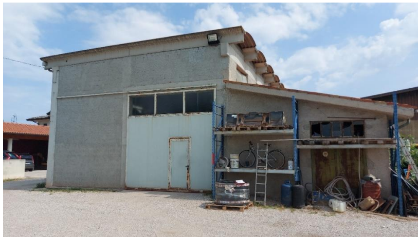
Fabbricato Principale mn. 404 sub. 2
