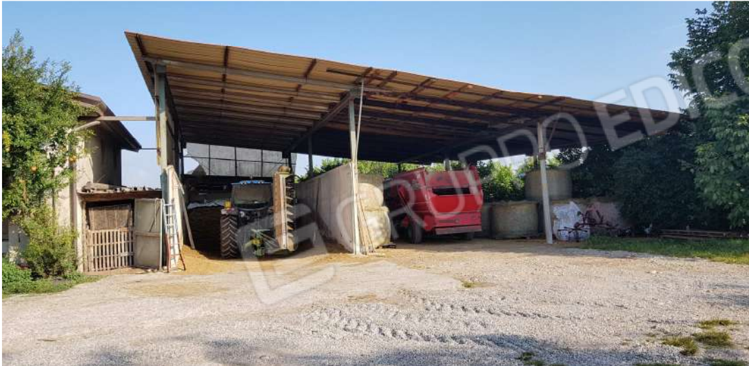
Fabbricato C - lato sud piano terra
