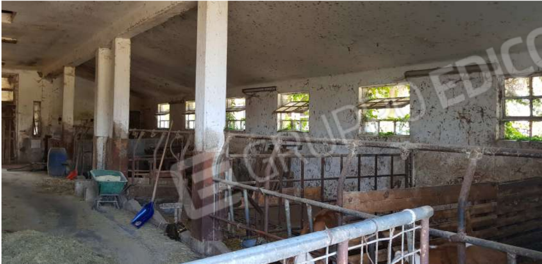
Fabbricato B - piano terra
