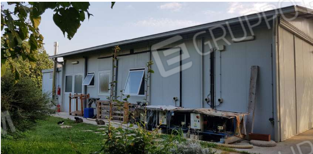
Fabbricato D - minicaseificio lato ovest
