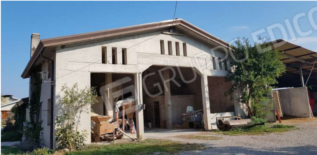
Fabbricato B - lato sud
