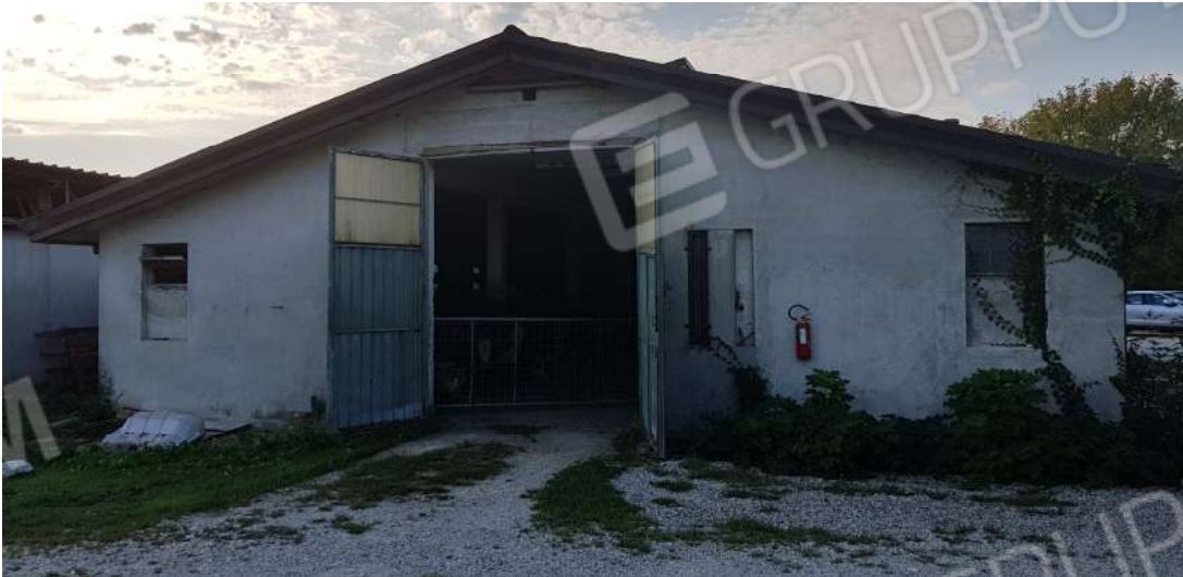
Fabbricato B - lato nord
