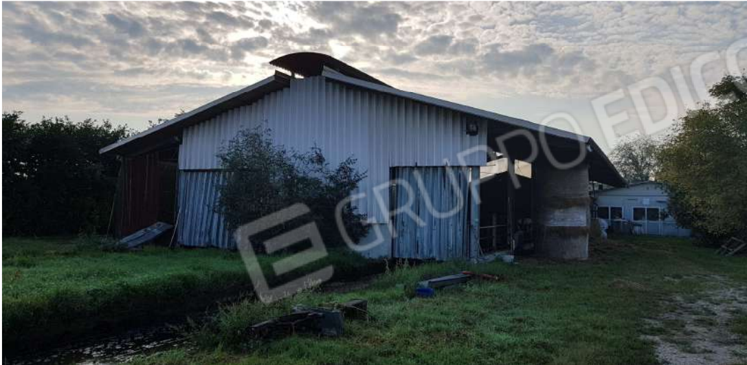
Fabbricato D - stalla lato nord
