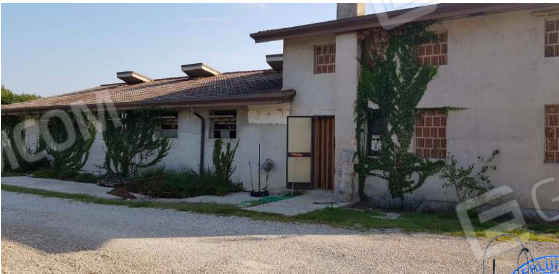
Fabbricato B - lato ovest
