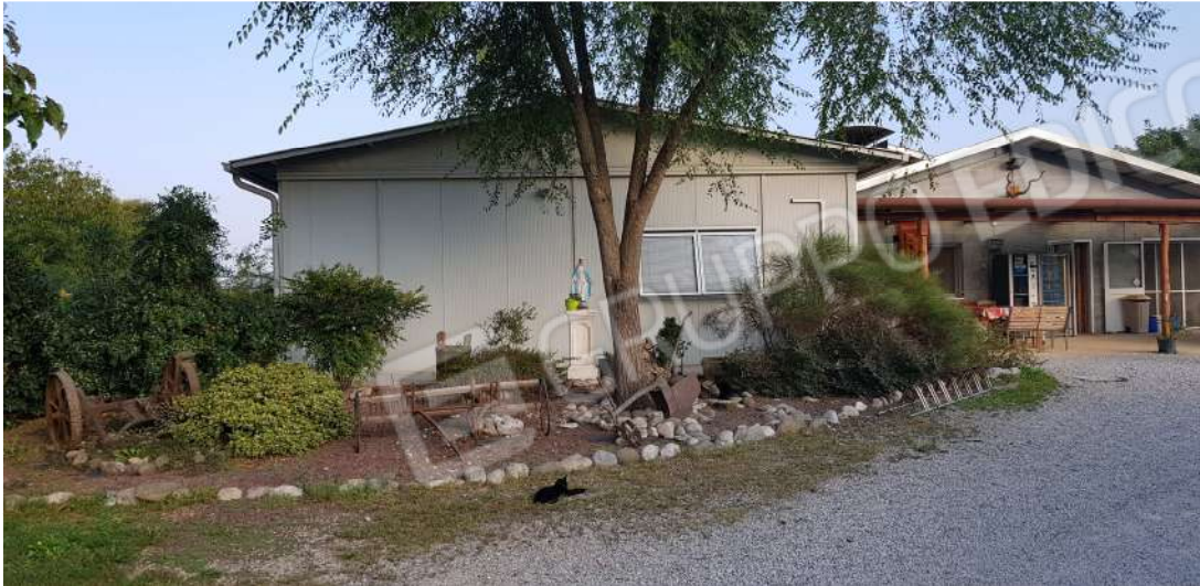
Fabbricato D - minicaseificio lato sud
