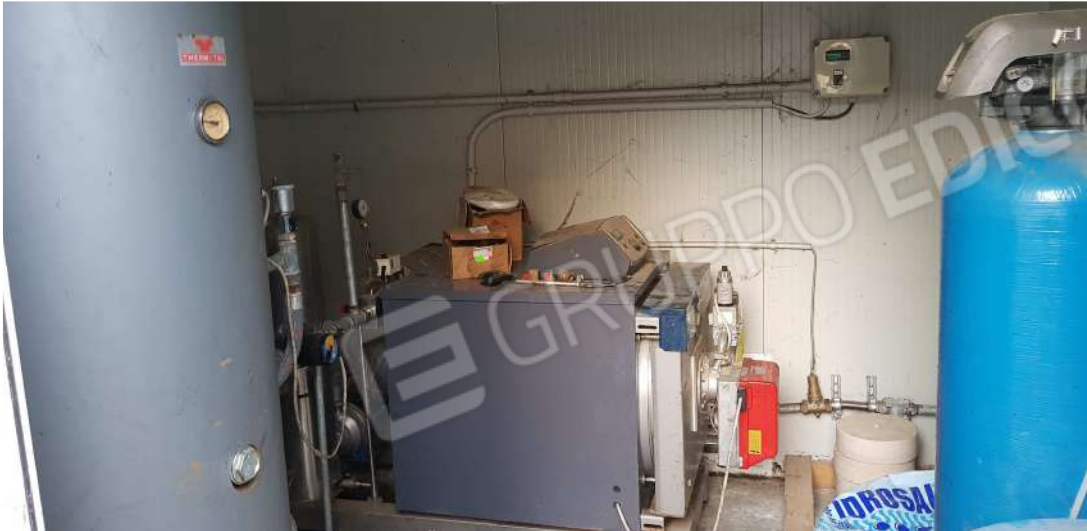
Fabbricato D - minicaseificio centrale termica
