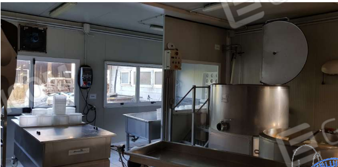
Fabbricato D - minicaseificio piano terra
