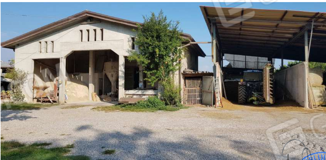
Fabbricato B e adiacente fabbricato C - piano terra lato sud
