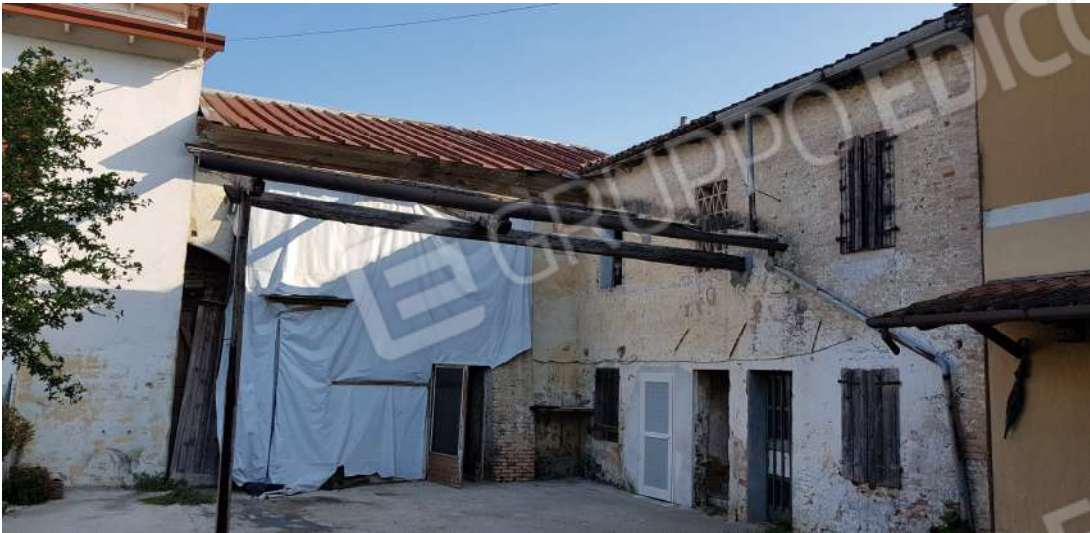
Fabbricato A - lato sud
