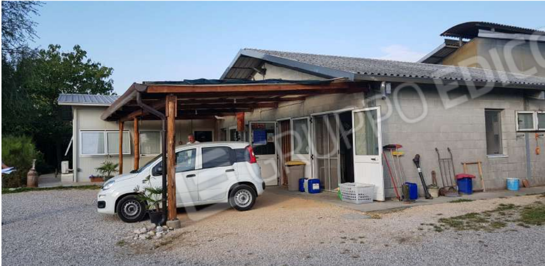
Fabbricato D - ingresso minicaseificio e locali accessori lato sud/est
