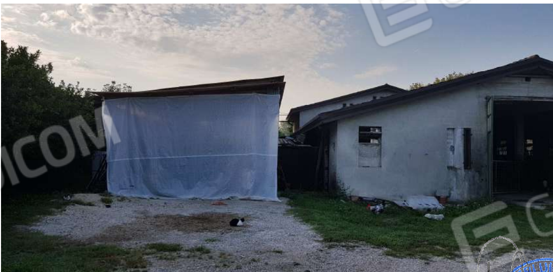
Fabbricato C - lato nord
