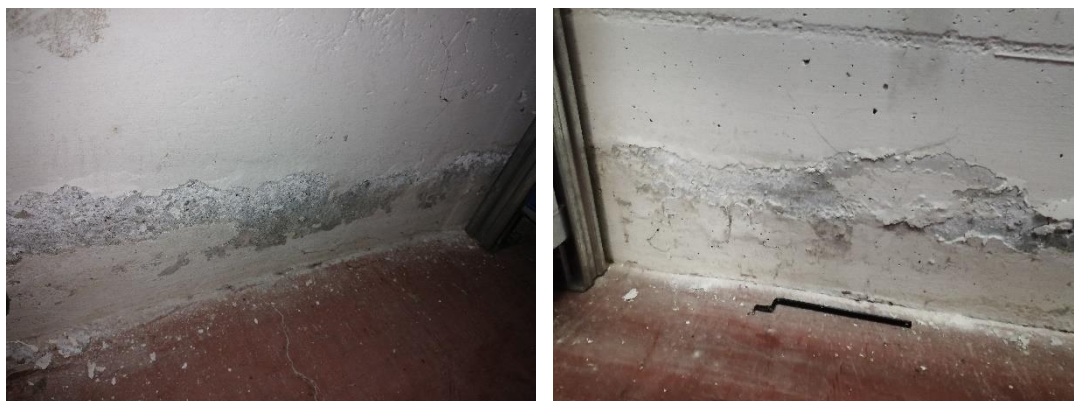
Particolare parete nord
