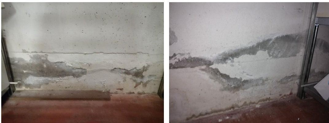
Particolare parete nord
