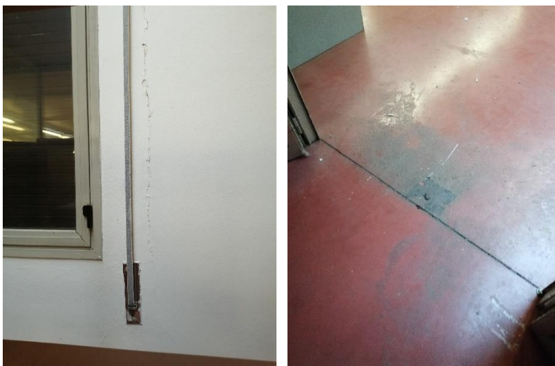
Parete perimetrale sud e particolare pavimento Negozio
