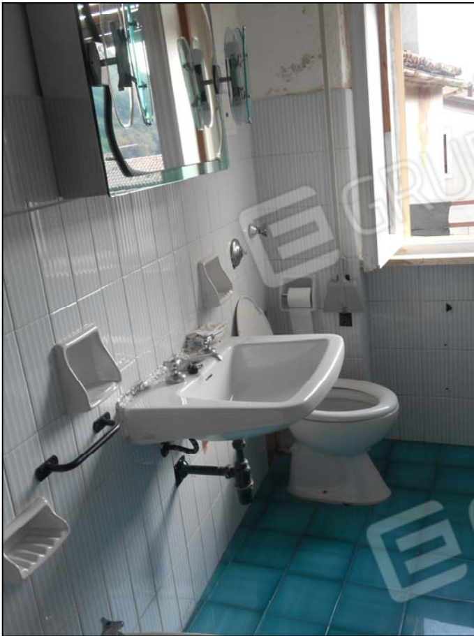
Stato di fatto del locale bagno
