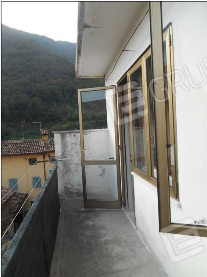
Terrazzo sud appartamento Ditta Esecutata con vista in direzione ovest
