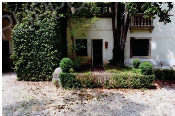
2. Ingresso caldaia a sud.
