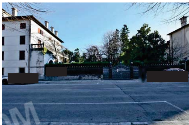
3. Prospetto giardino a sud ed ingresso carrabile.
