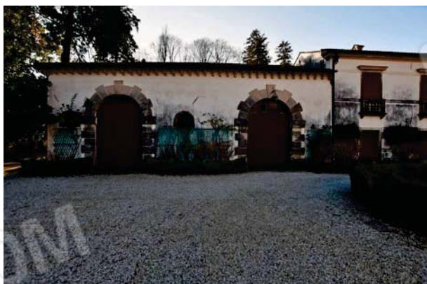
9. Prospetto interno barchessa sud scuderia e autorimessa (1 di 2).
