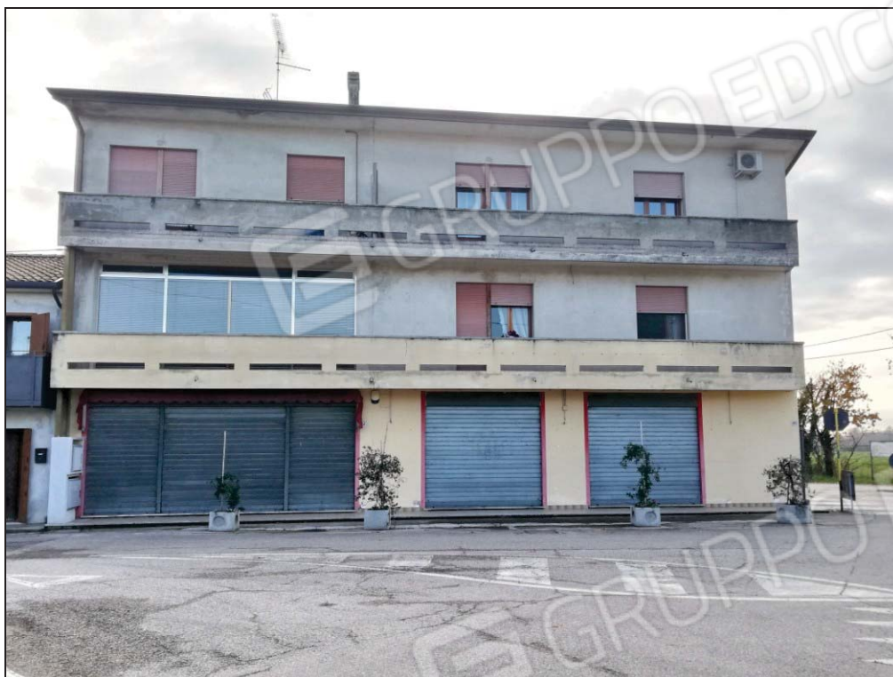
Foto 01 – Fronte nord da via Salvatoronda
