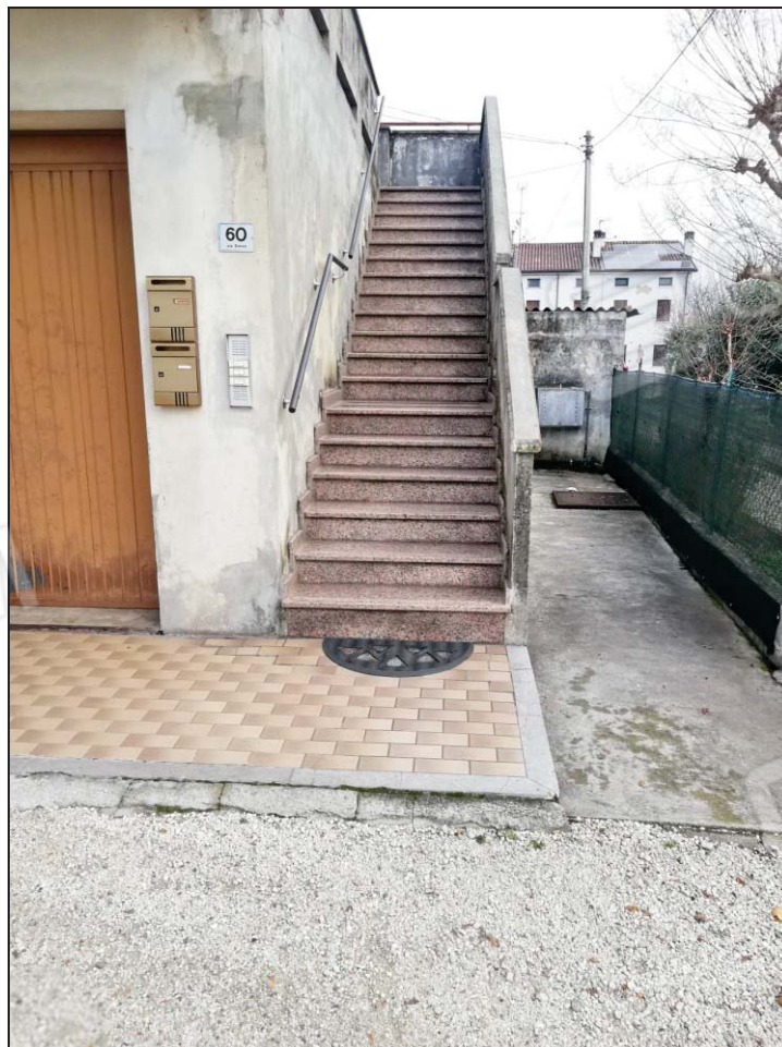
Foto 06 –Scala comune esterna di accesso al piano 1°
