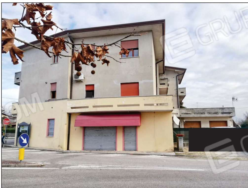
Foto 02 – Fronte ovest da via Zoncè
