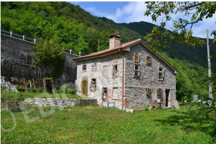
foto n. 5 – prospetti est e sud
