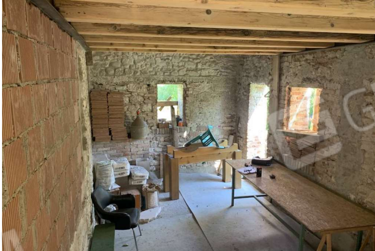
foto n. 7 – locale al PT da ingresso est
