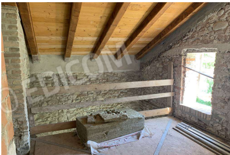
foto n. 11 – locale al piano primo
