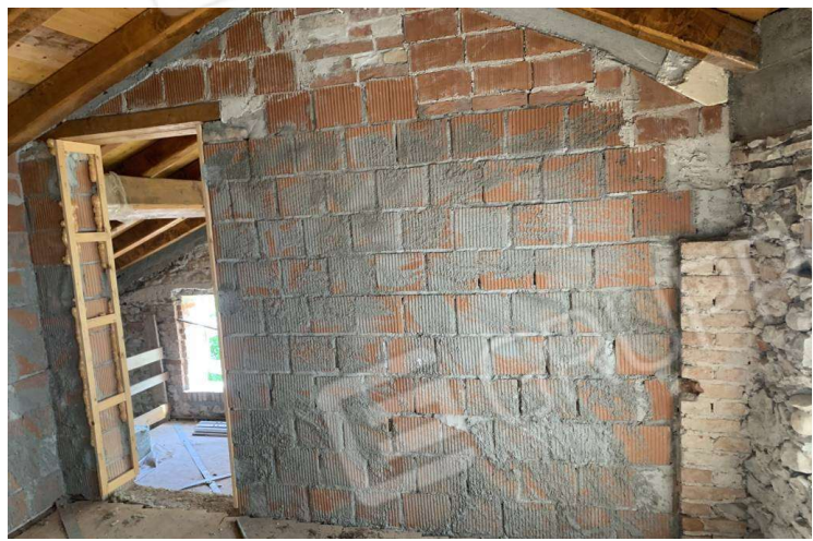
foto n. 12 – locale al piano primo
