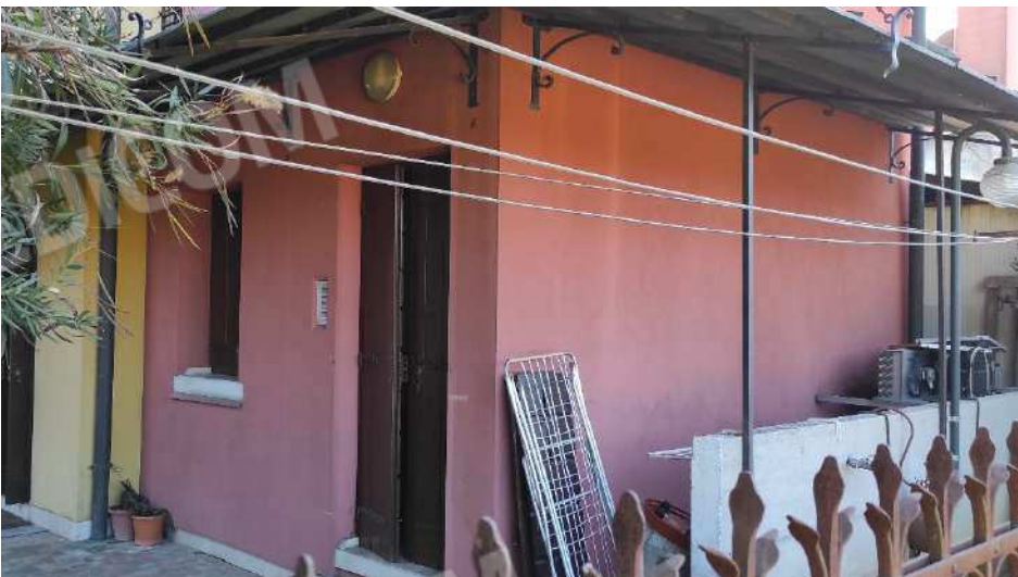
Ingresso su scoperto
