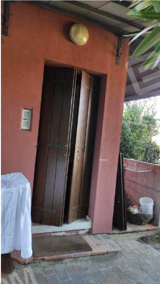
Vista ingresso lotto 2
