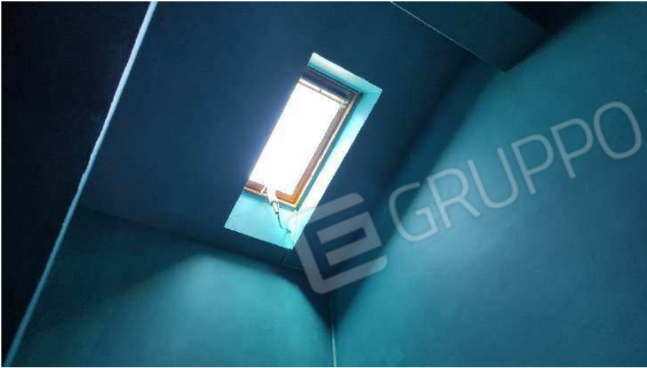
Vista velux del bagno
