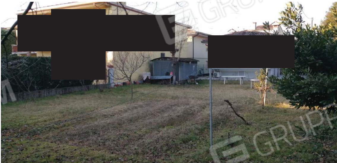
Terreno vista da sud/est - box in lamiera realizzato senza autorizzazione
