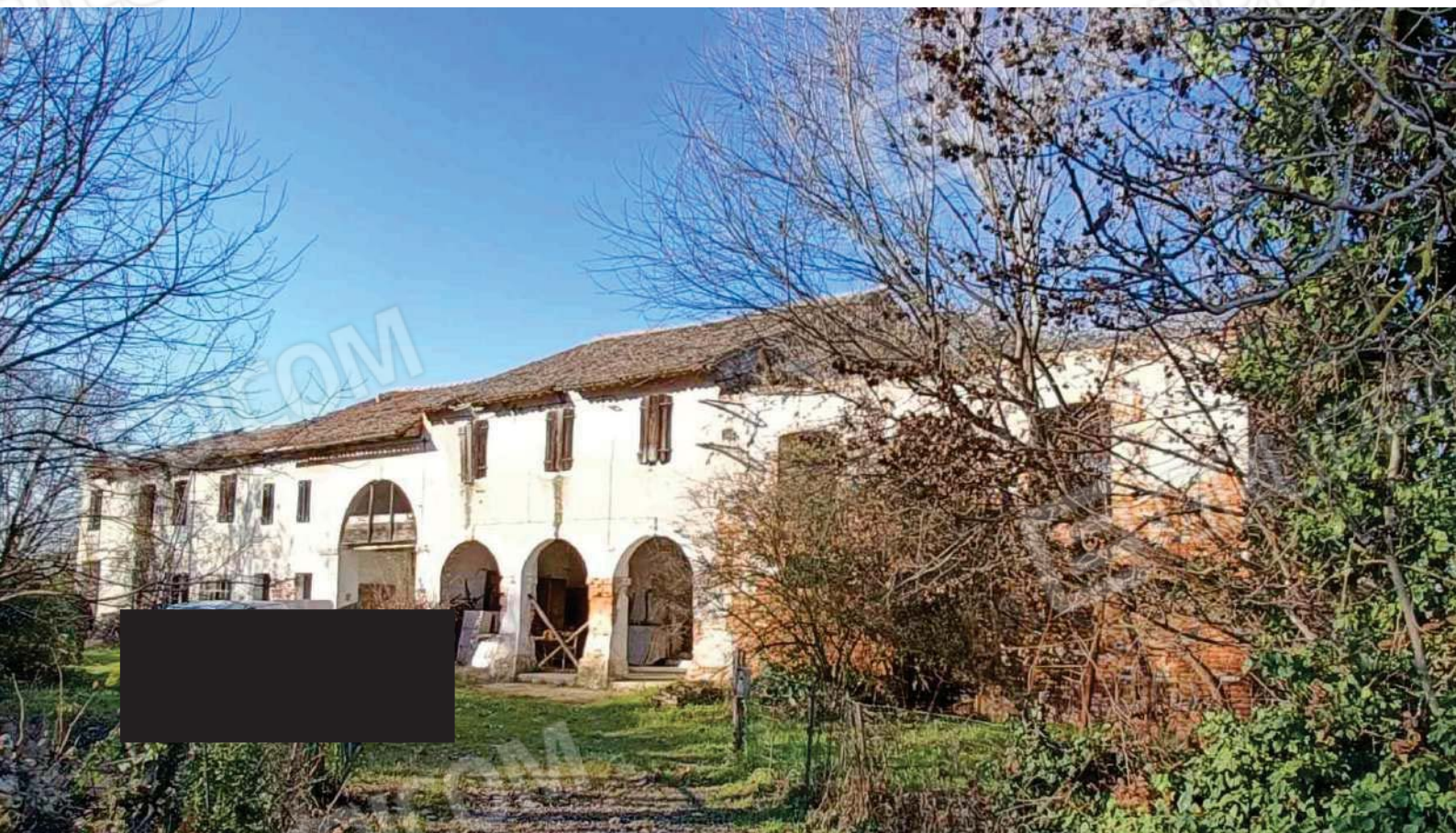
Foto 02 – prospetto sud fabbricato principale
