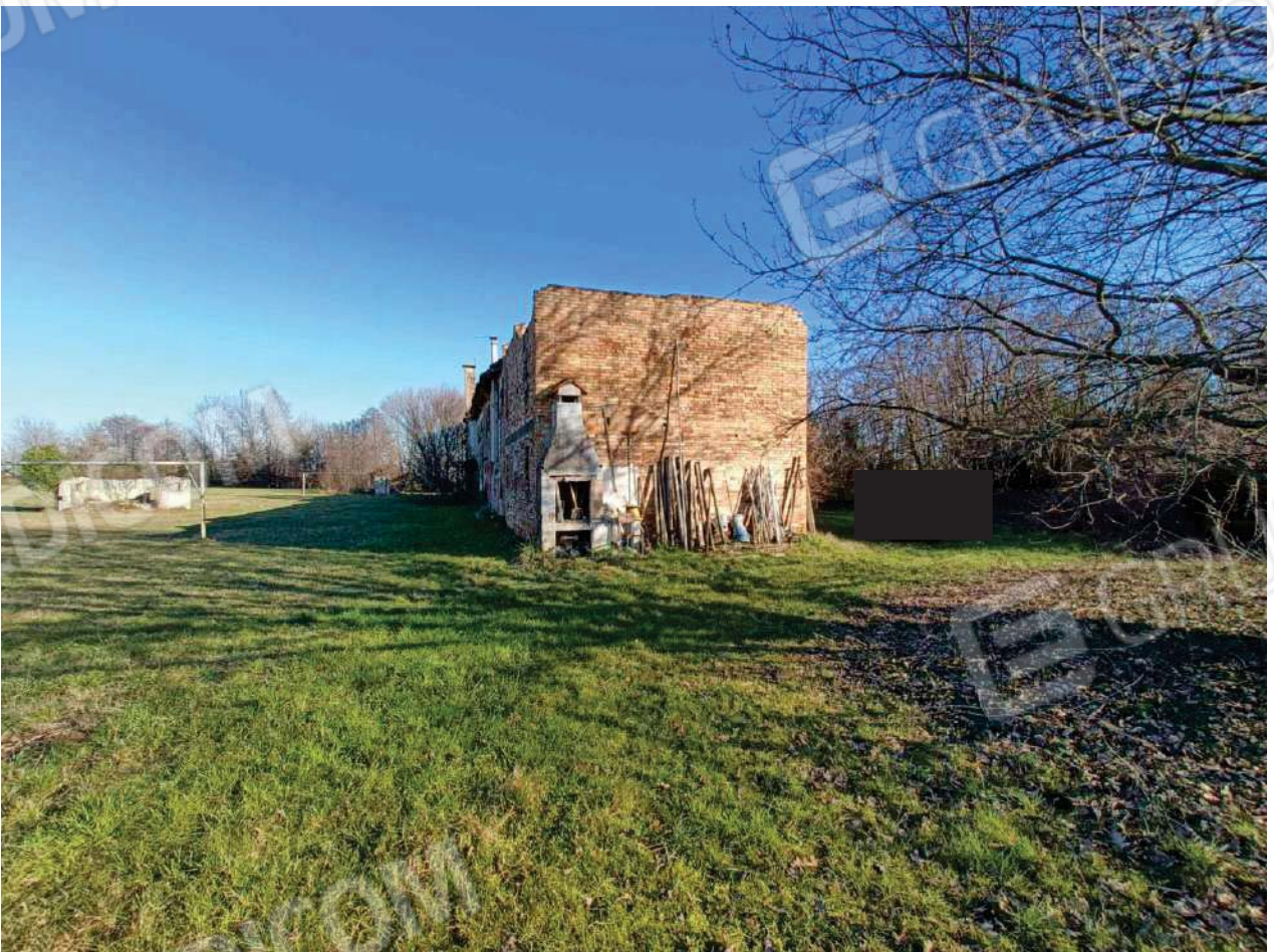
Foto 08 – parte del prospetto ovest
