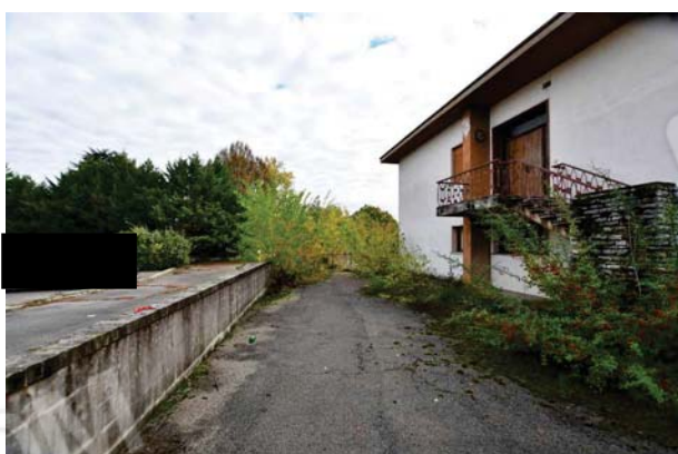
3. Parte A - area scoperta di pertinenza del fabbricato, lato nord.
