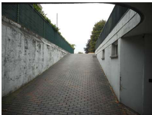
Foto 6 – rampa per i garage
