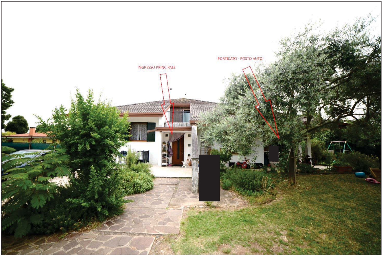
Foto 3 – Prospetto principale nord-ovest
