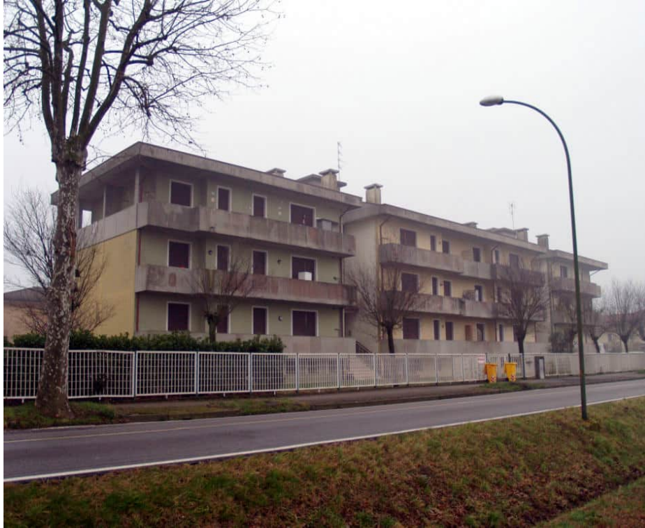
1. Immagine generale del complesso condominiale Condominio Lidia ove sono ubicati gli immobili
