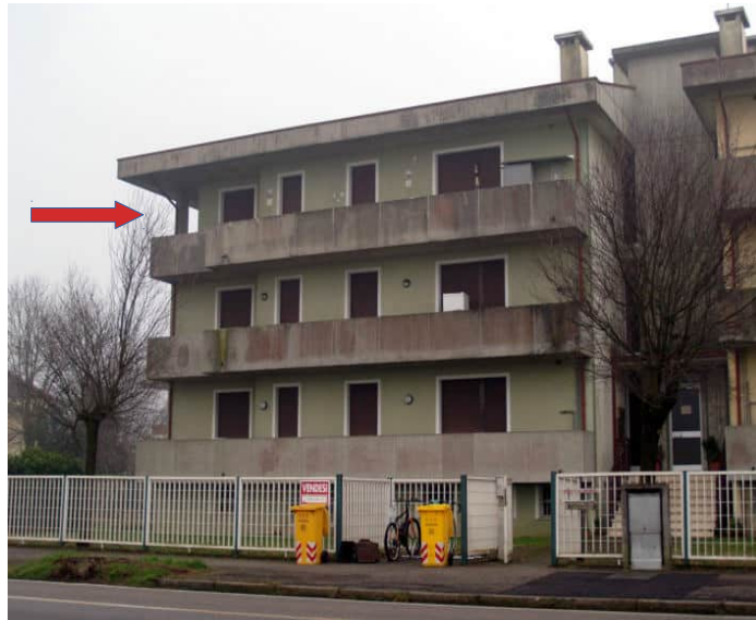
2. Il Corpo C dove è ubicata l'unità residenziale evidenziata con la freccia rossa
