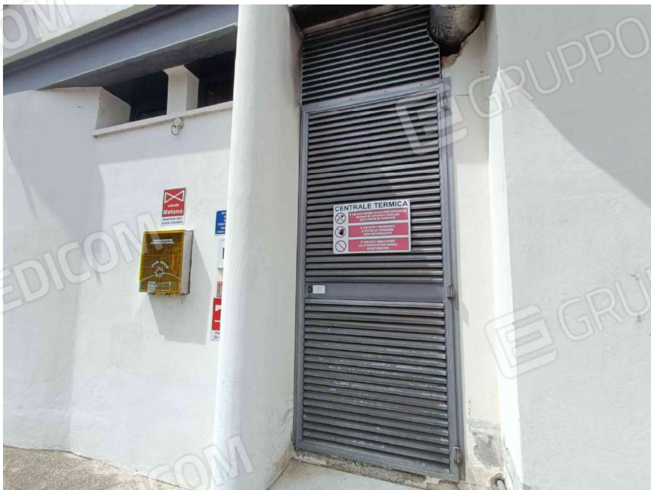
Foto 4 – Ingresso C.T. (prospetto Est)
