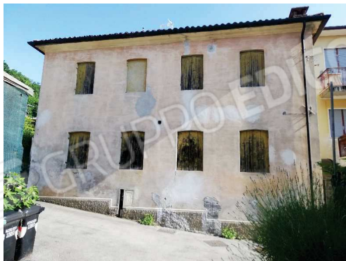
Foto 2. Vista Lato Sud
