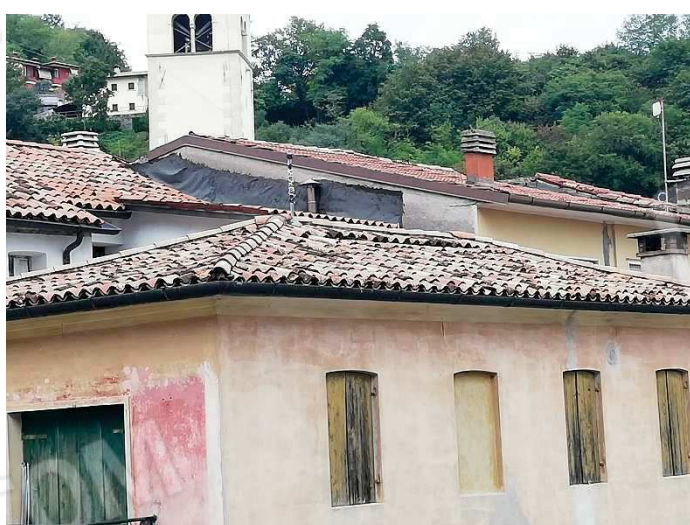
Foto 29. Vista copertura Sud - Ovest
