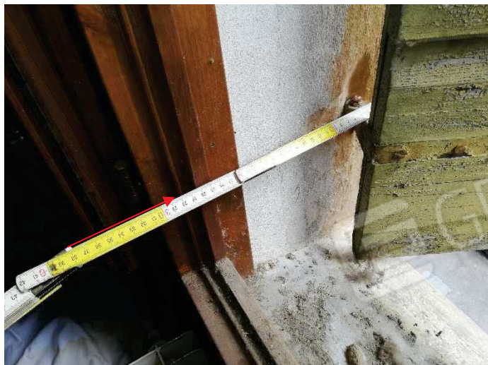
Foto 23. Particolare muri perimetrali
