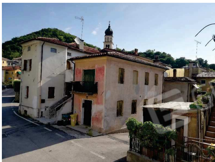
Foto 27. Vista Sud - Ovest
