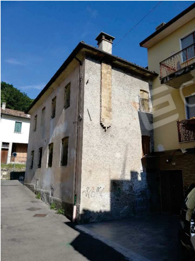
Foto 3. Vista Facciata Est
