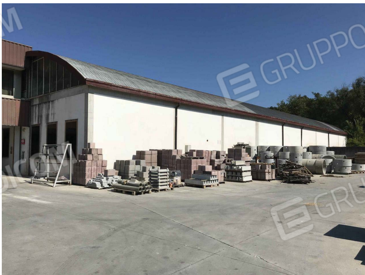
FOTO 5 - lato sud stabilimento
