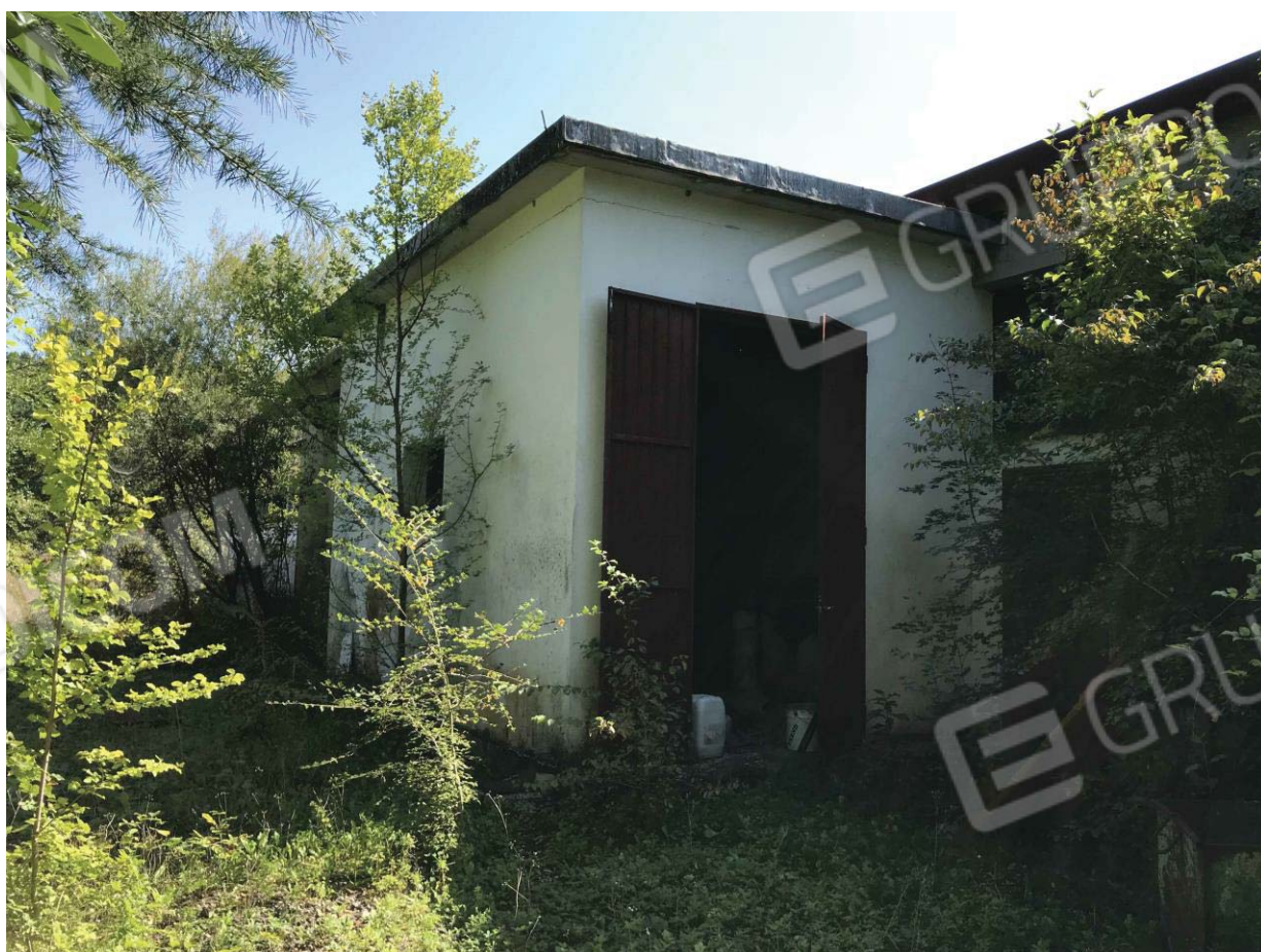
FOTO 11 – locali tecnici lato nord
