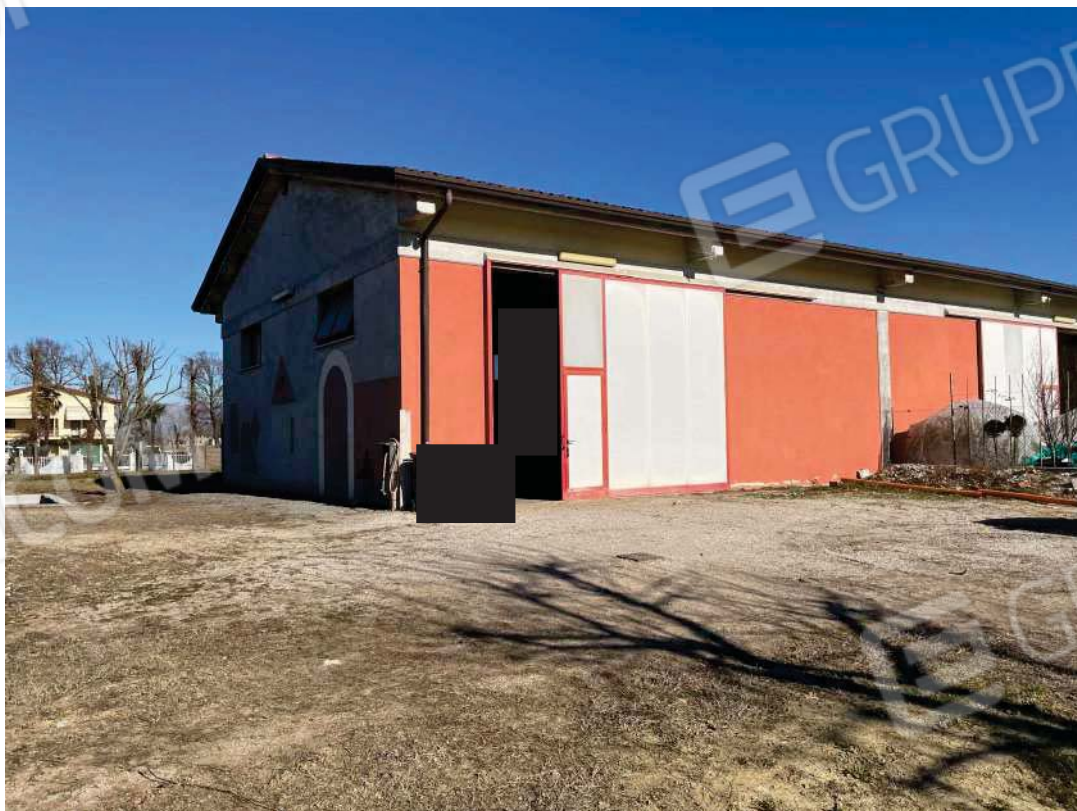
Particolare esterno magazzino deposito attrezzi
