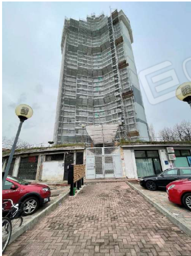
Particolare d'insieme con i lavori superbonus
