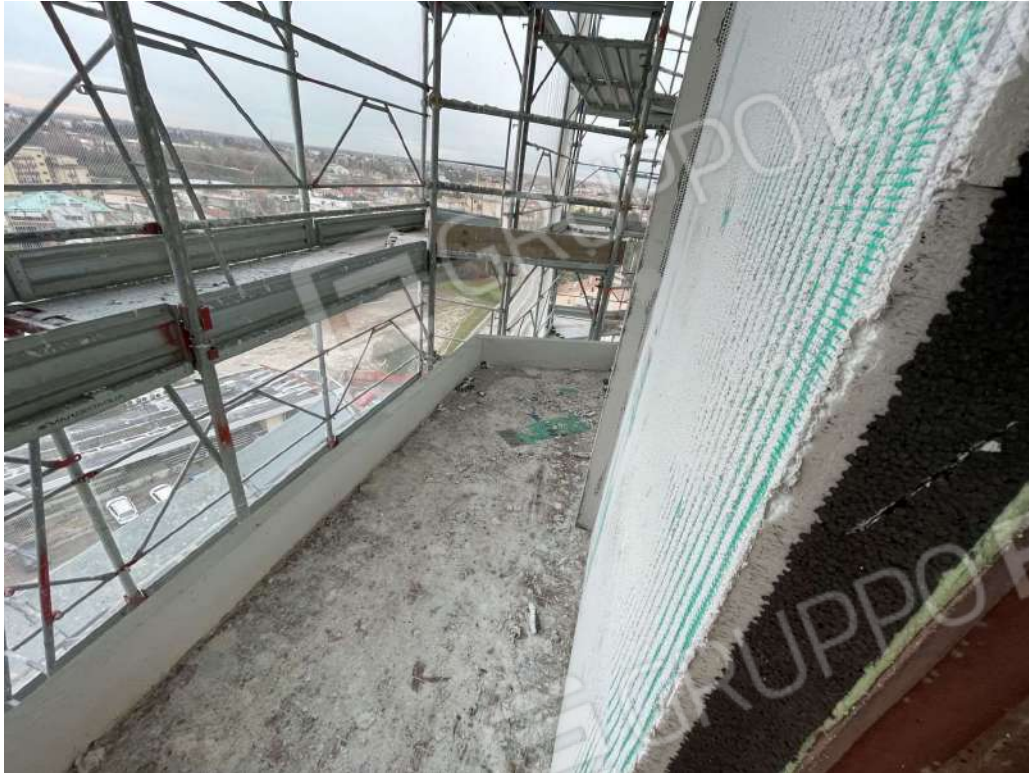
Particolare poggiolo ed opere di cappotto termico
