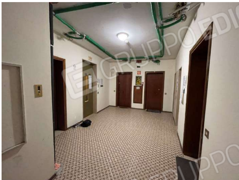
Particolare pianerottolo 11° piano con le predisposizioni riscaldamento
