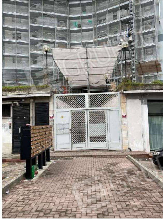
Particolare accesso da Via Pisa
