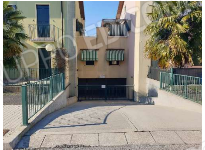
foto n. 2 - rampa accesso carraio
