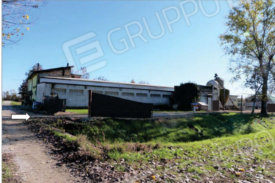
3 Vista da nord-ovest di parte dei fabbricati del complesso agricolo. In primo piano il capannone ad uso allevamento. La freccia indica l'accesso alla parte produttiva.
