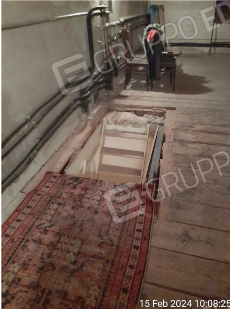
Apertura su solaio con scala di accesso alla soffitta da sanare
