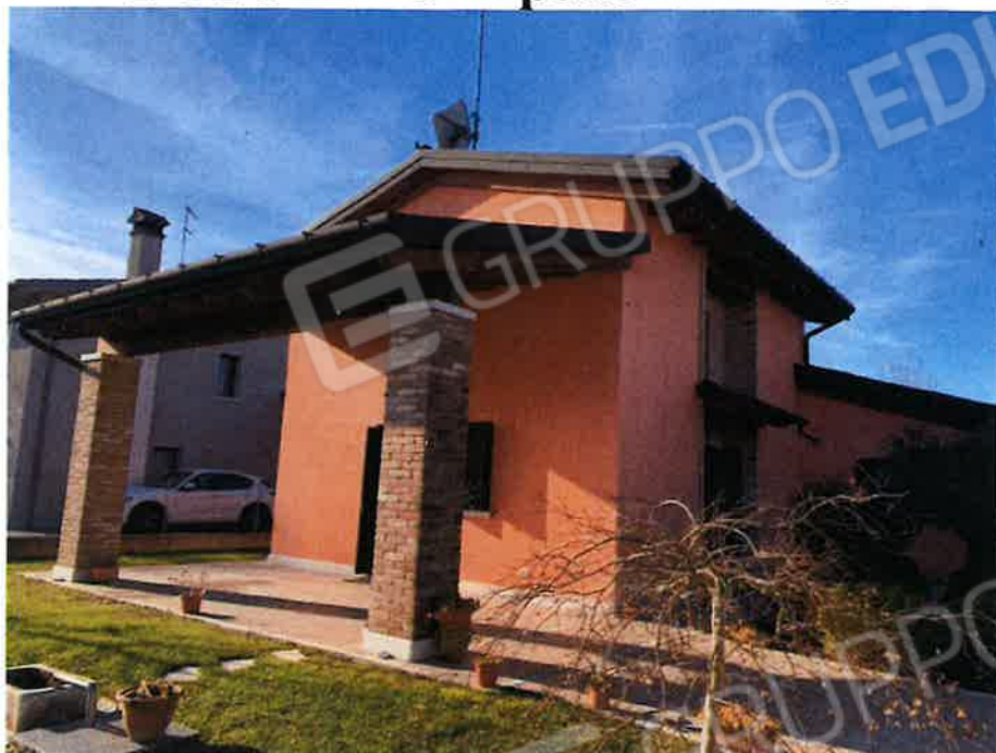
FOTO 06 – Prospetto est e nord
