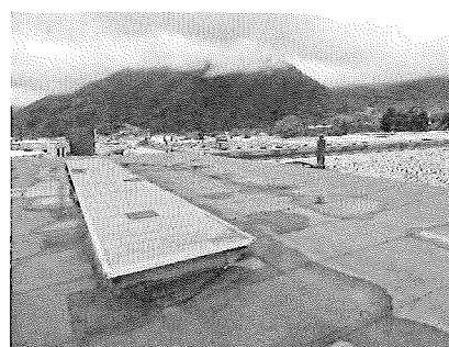
Elemento funzionale/manto di copertura: guaina impermeabile su copertura piana
