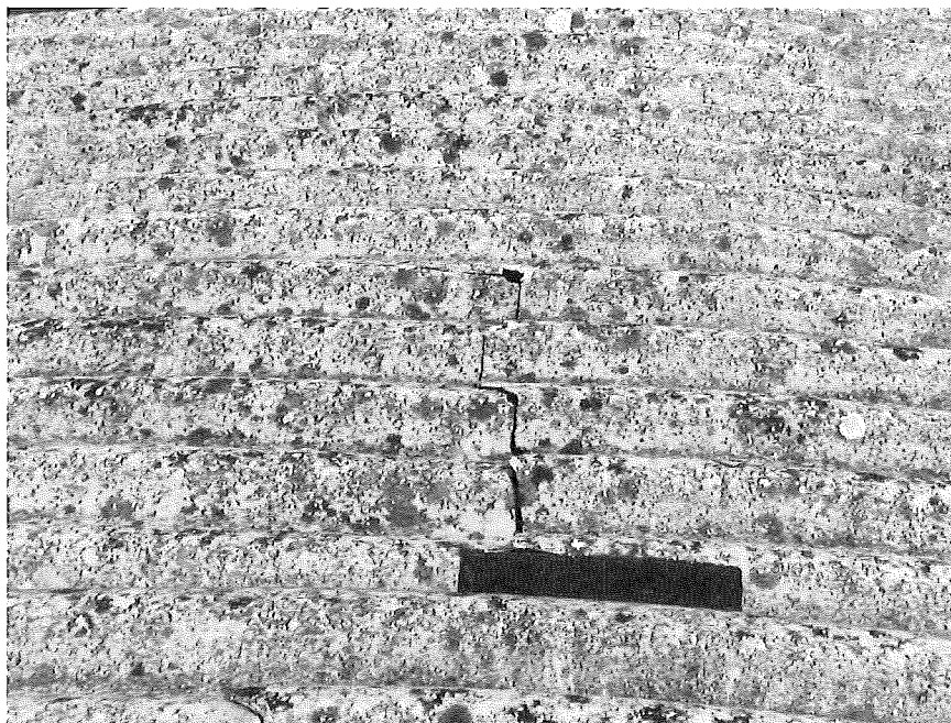
Figure 4_parte di copertura esterna
