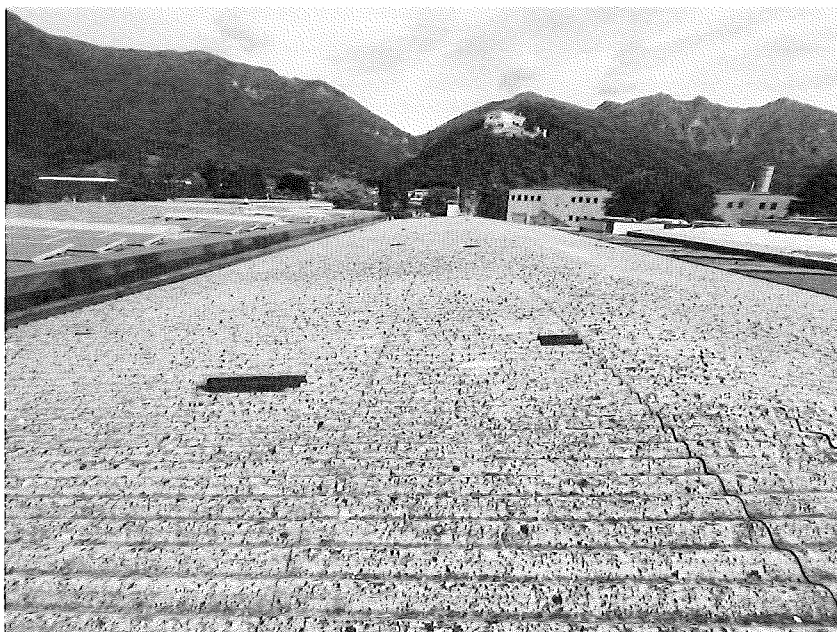
Figure 2_ copertura esterna dove è stato prelevato un campione per la verifica della presenza di amianto
