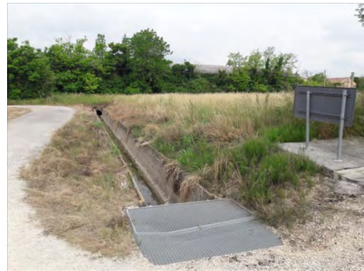
Confine sud-ovest della lottizzazione - part. 725 - strada di accesso ai campi e alle proprietà poste a sud
