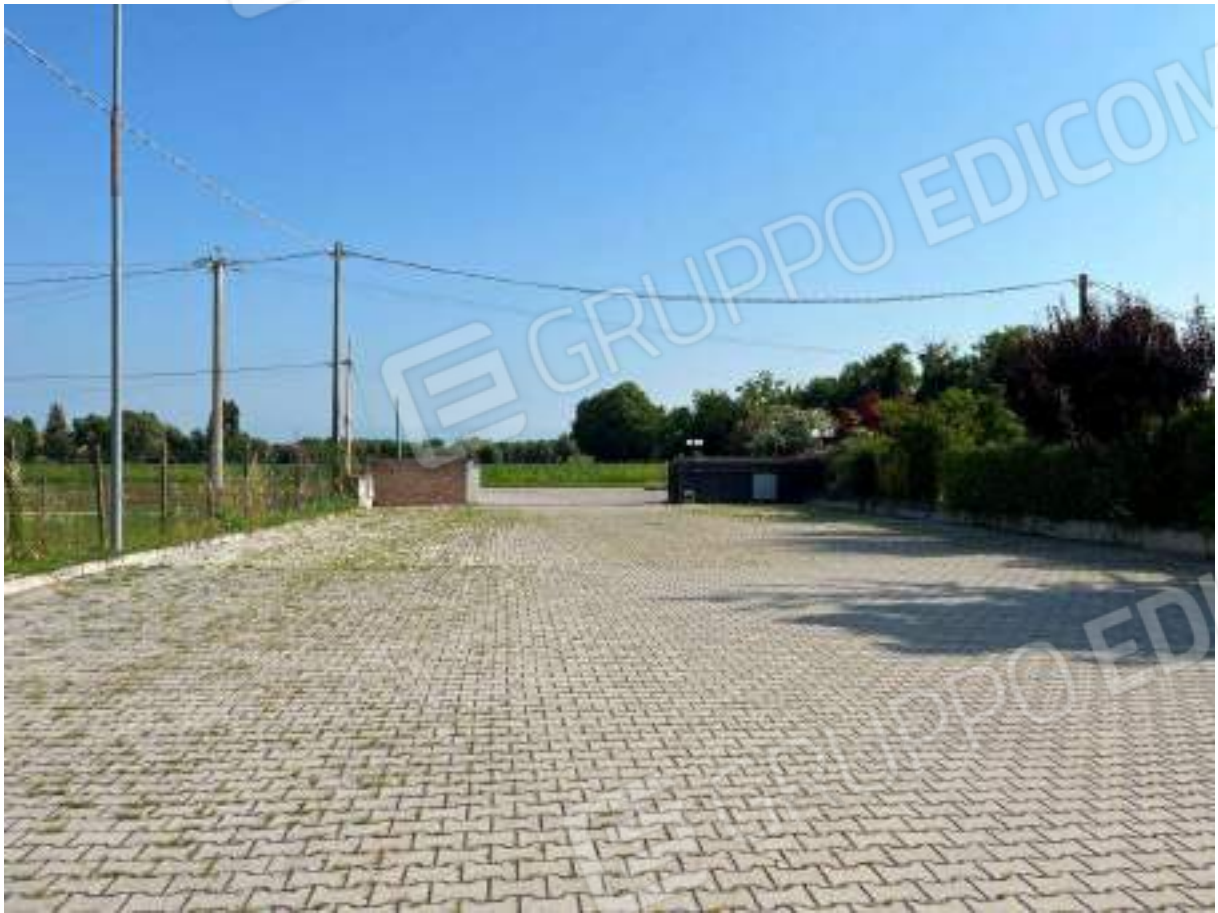
vista ingresso carrabile
