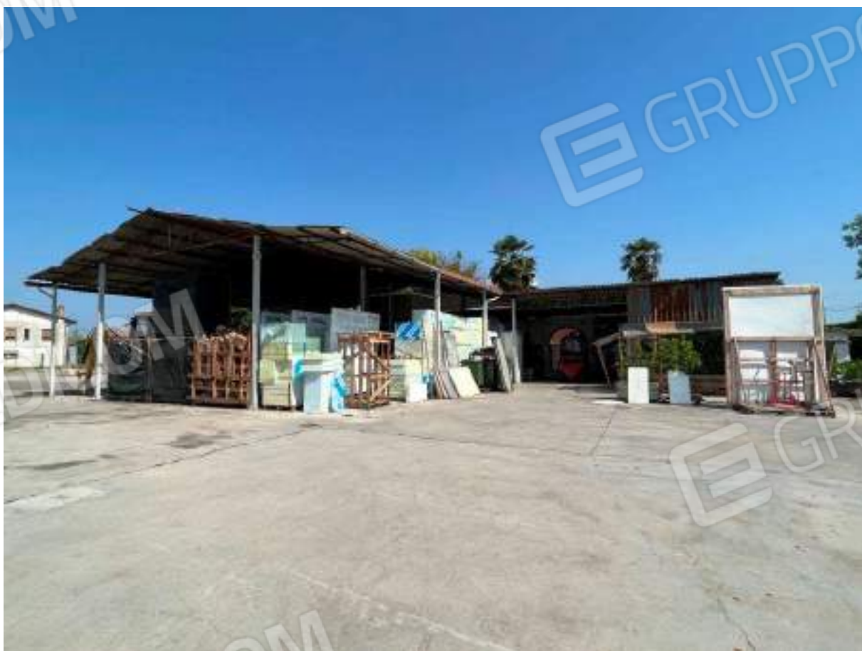
vista tettoia su piazzale
