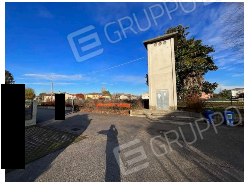
Foto 1 Accesso da via S. Allende, posto a sud del lotto
