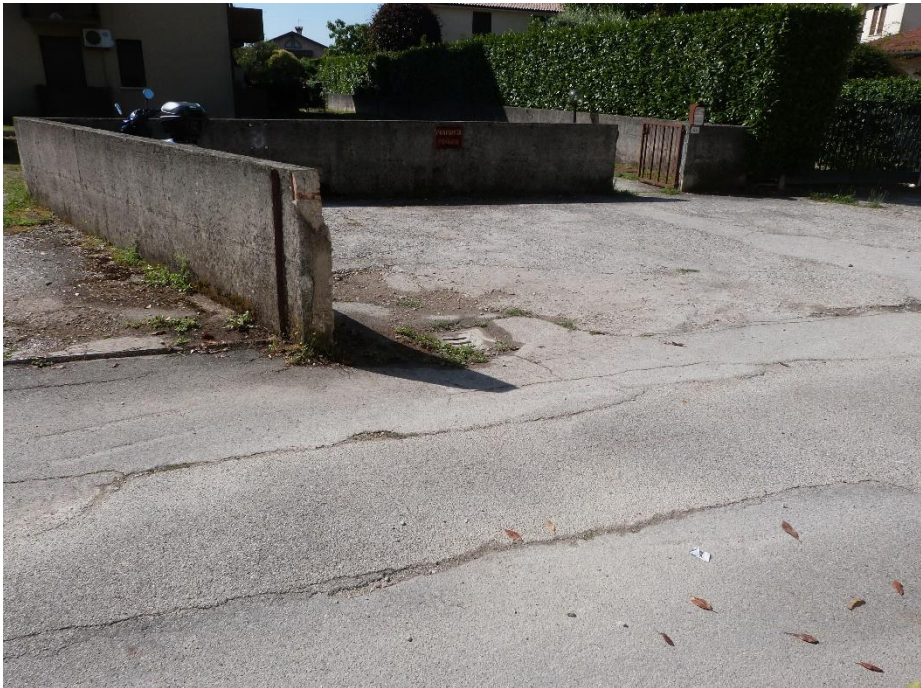
10 Ingresso pedonale e area parcheggio condominio.
