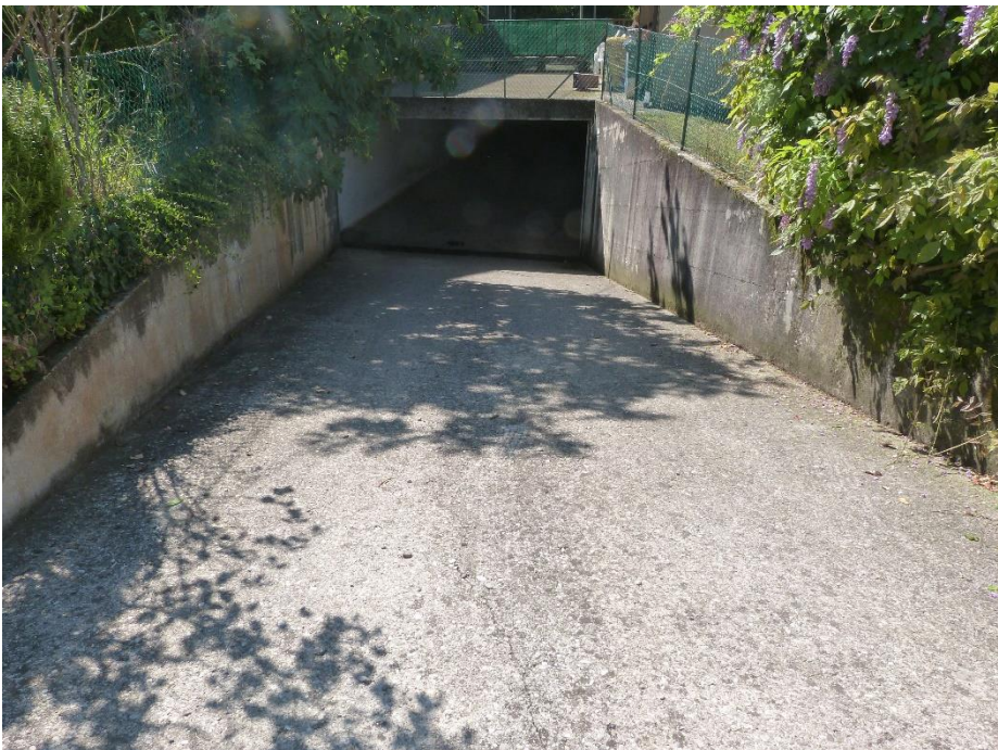
12 Rampa di accesso ai garage.
