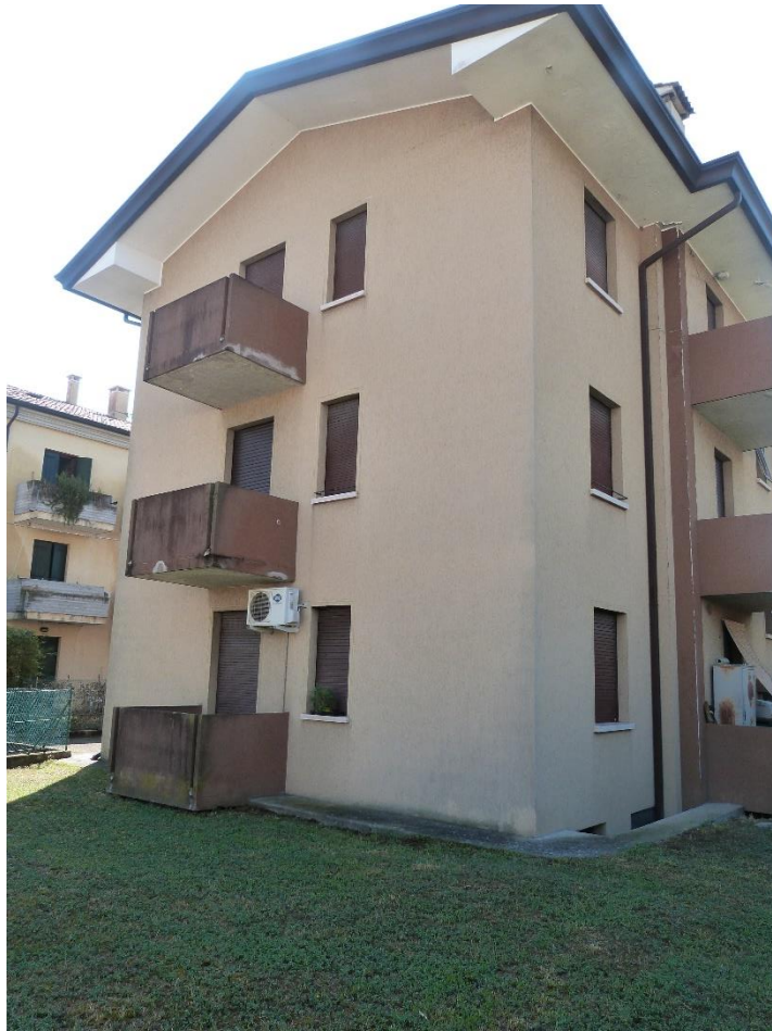
3 Fronte prospiciente la strada (nord-ovest).
