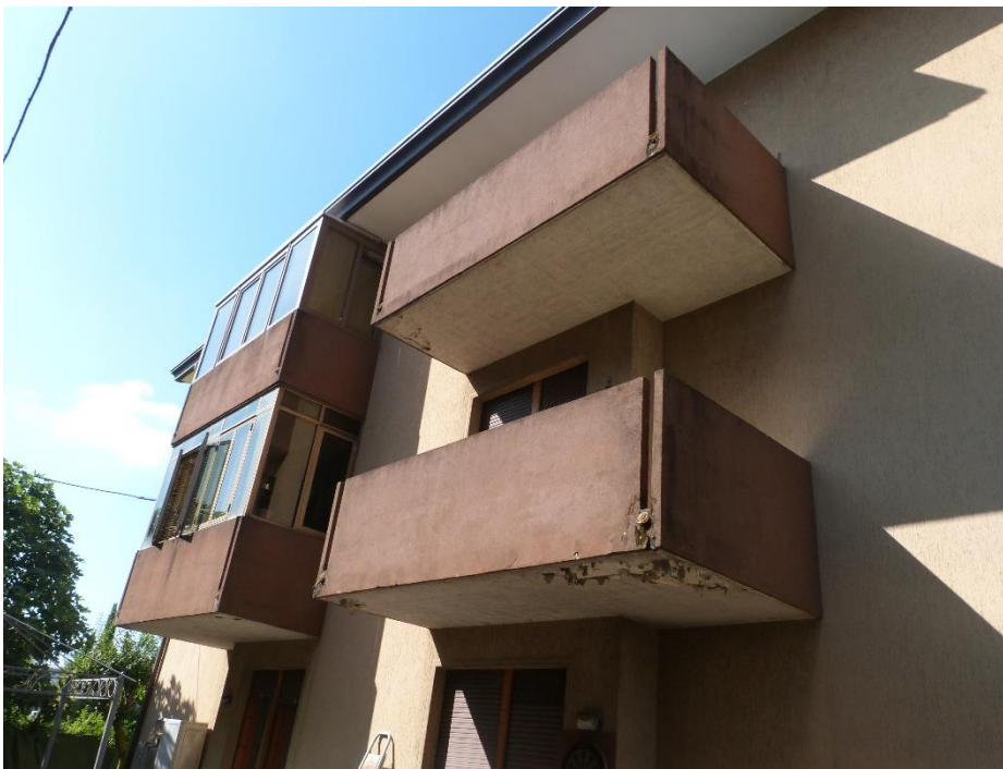
4 Particolare fronte nord-est: al piano secondo la terrazza dell'u.i.
