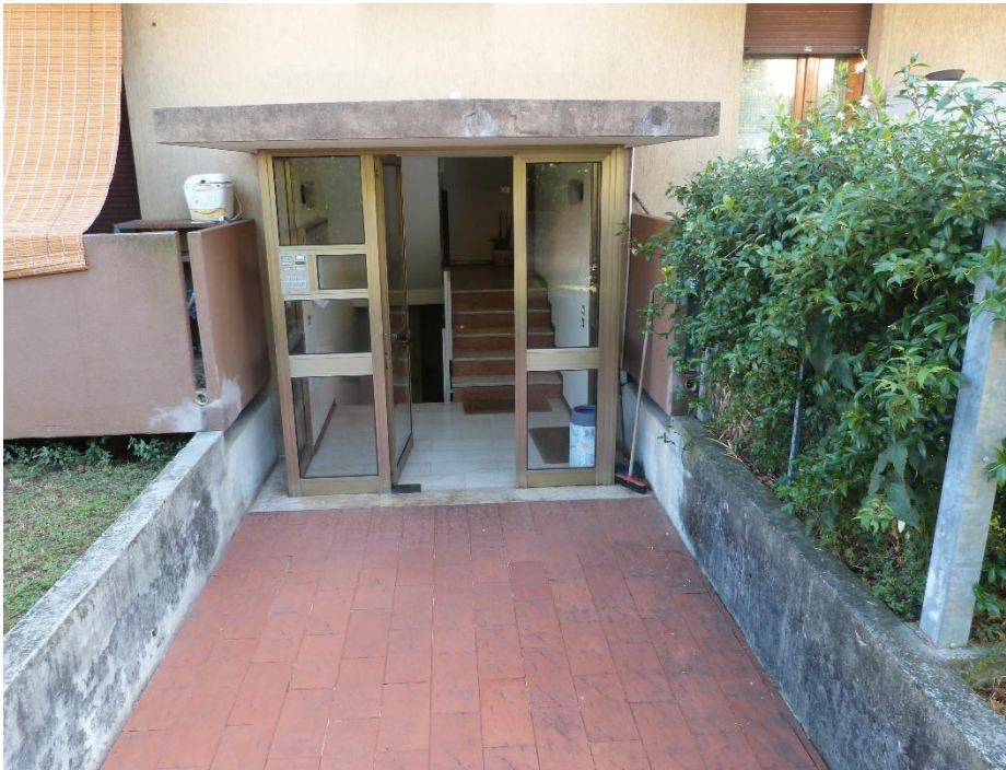
2 Ingresso al Condominio
