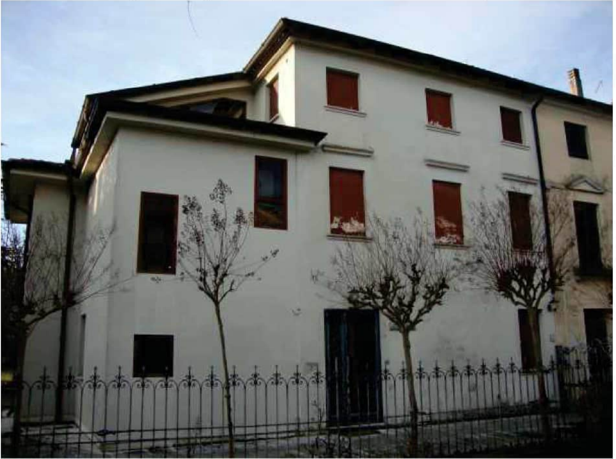
Viste generali degli esterni, dell'annesso urbano e dello scoperto
