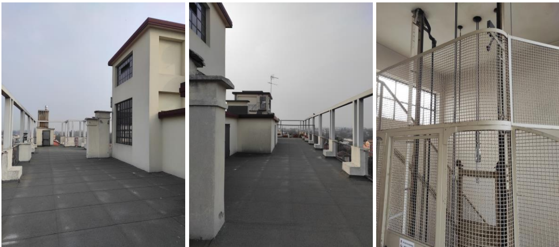
Copertura piana e vano ascensore
