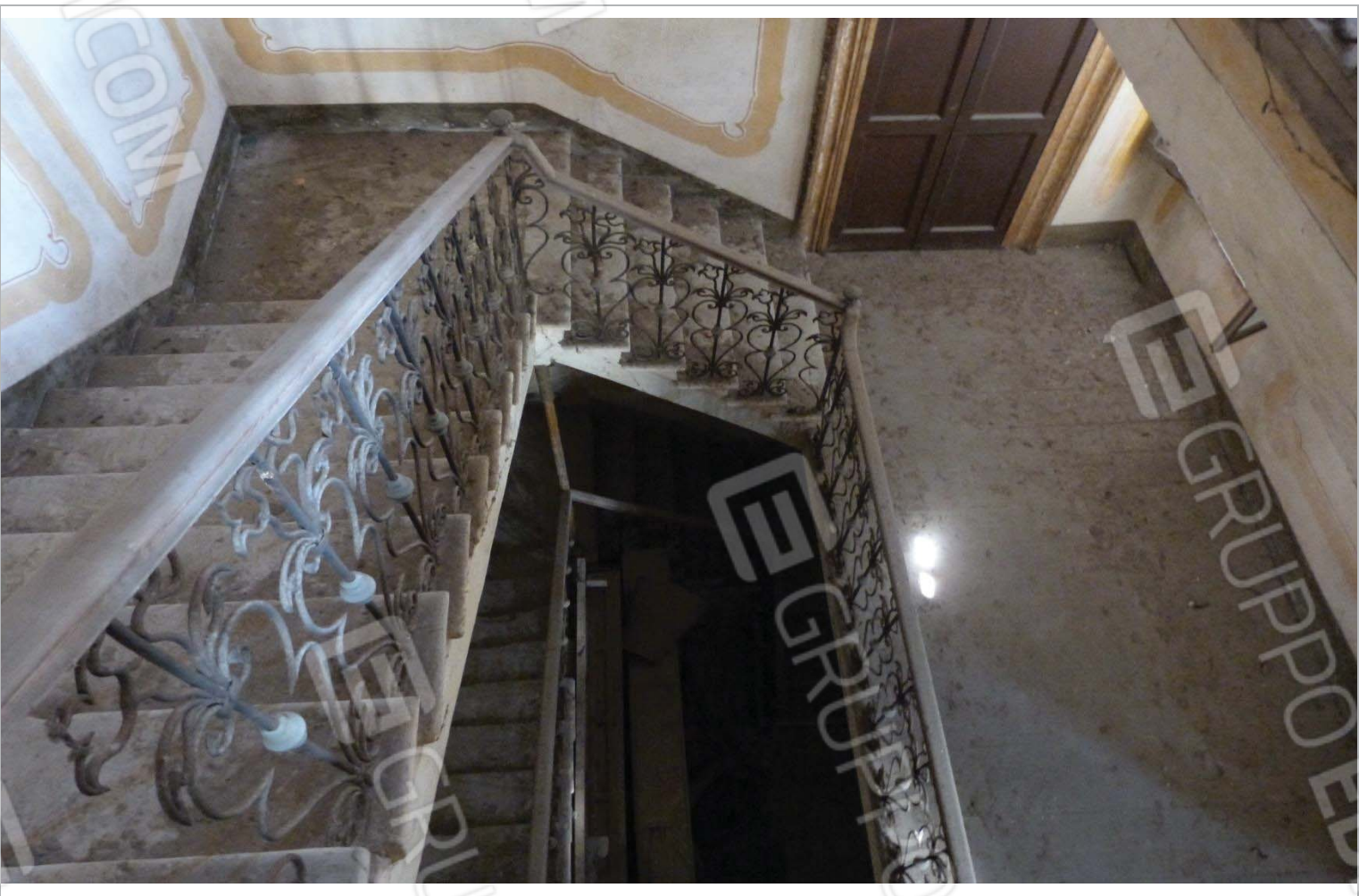
Vano scala attiguo al salone passante attraverso il quale accedere ai vari livelli del corpo centrale
