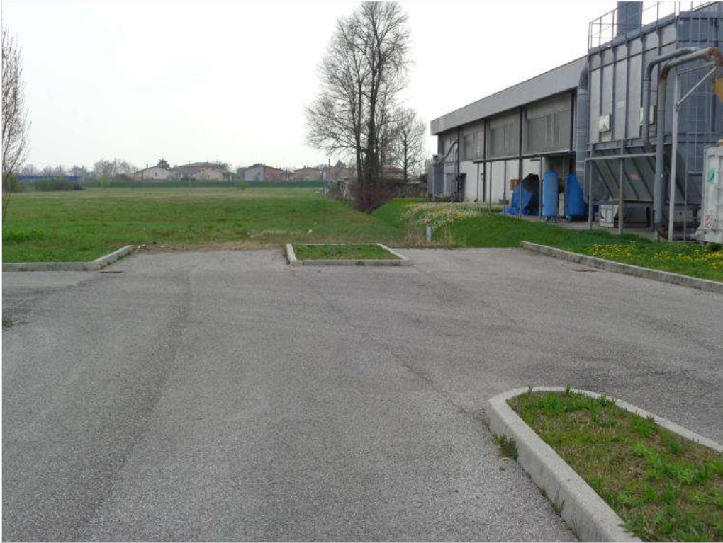
Foto n. 5: Accesso a due vie del "Lotto n. 3" in corrispondenza della rotatoria di Via Baite
