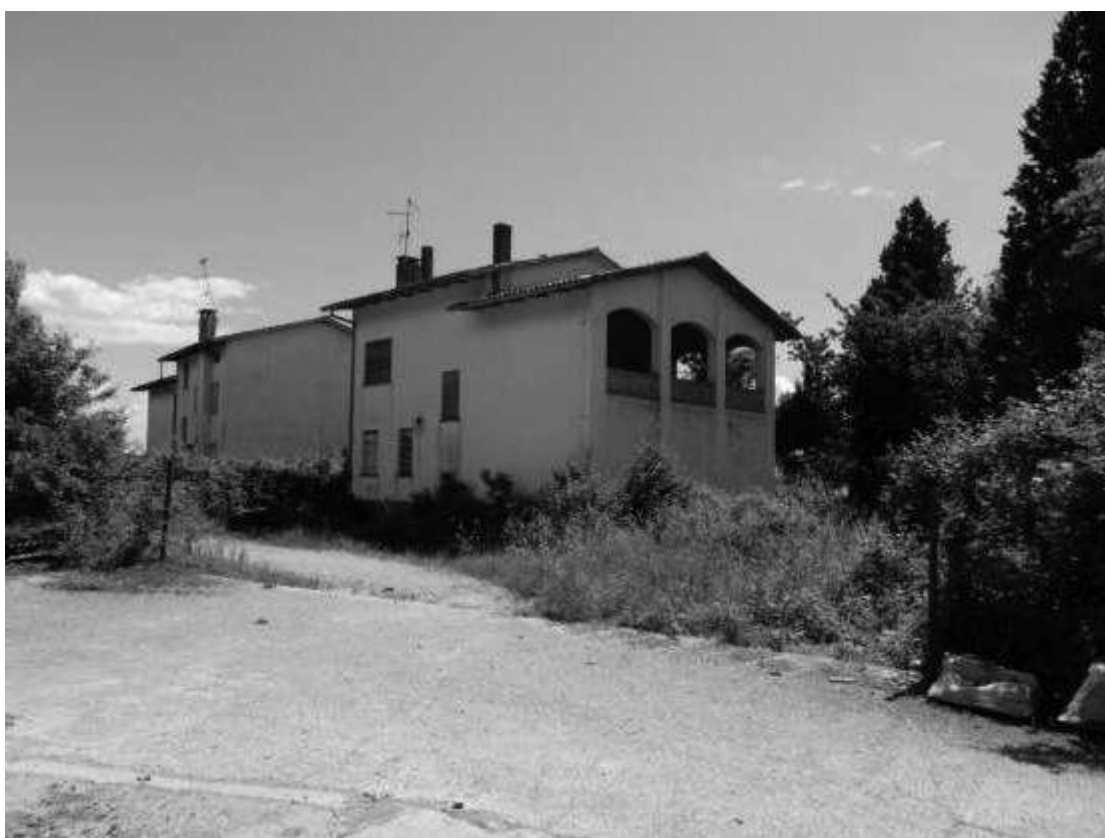
VISTA NORD DELLE ABITAZIONI
