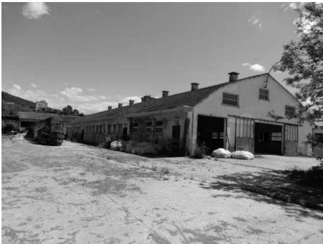
VISTA PARTE NORD OVEST DEL FABBRICATO B
