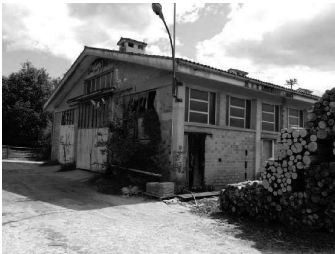
VISTA DA NORD DEL FABBRICATO D
