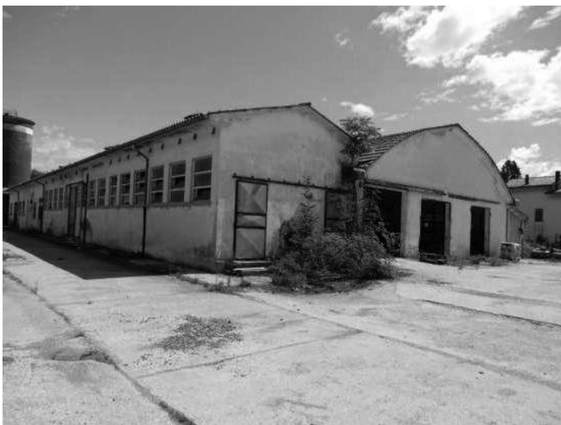
VISTA PARTE NORD DEL FABBRICATO C
