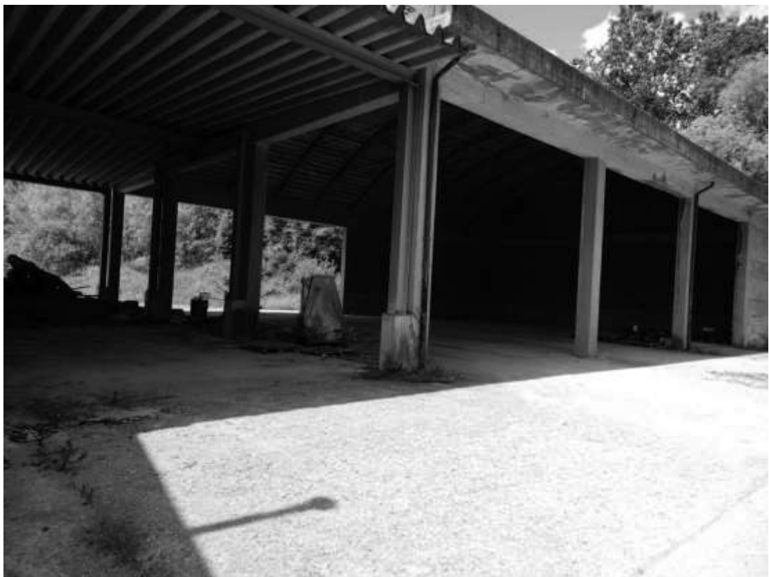
VISTA PARTE NORD-EST DEL FABBRICATO E
