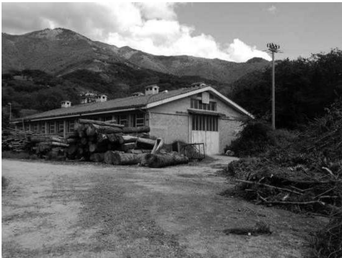
VISTA DA SUD DEL FABBRICATO D
