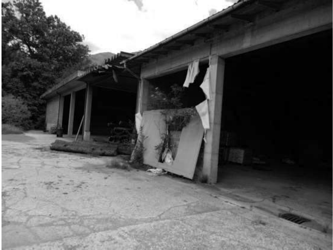
VISTA PARTE NORD-OVEST DEL FABBRICATO E
