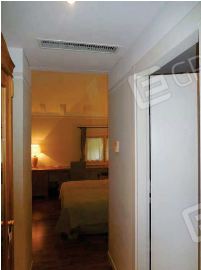
Foto 72 - piano primo – camera 103
