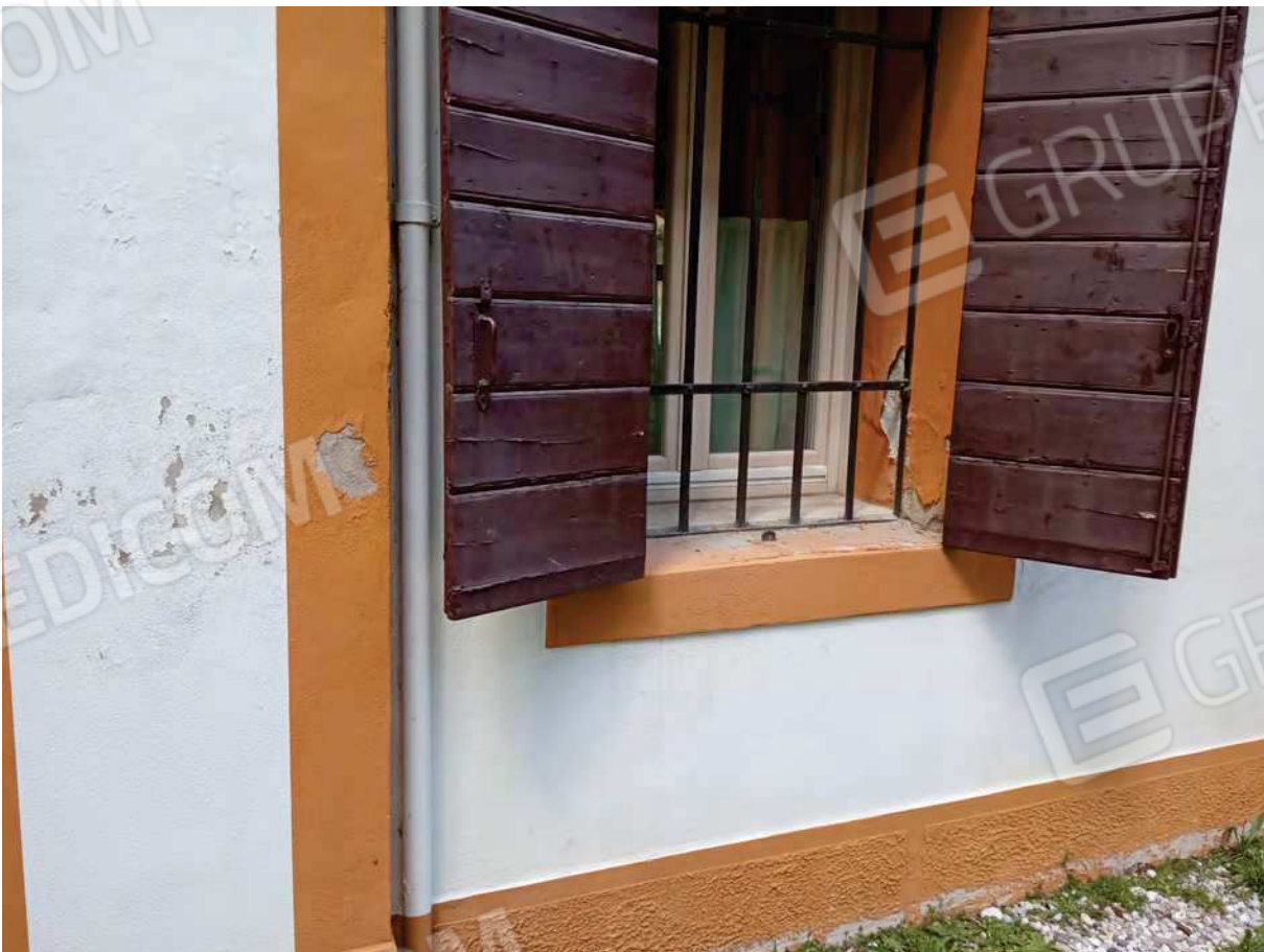
Foto 23 - vista esterna del fabbricato particolare finestra (Via Traversi)
