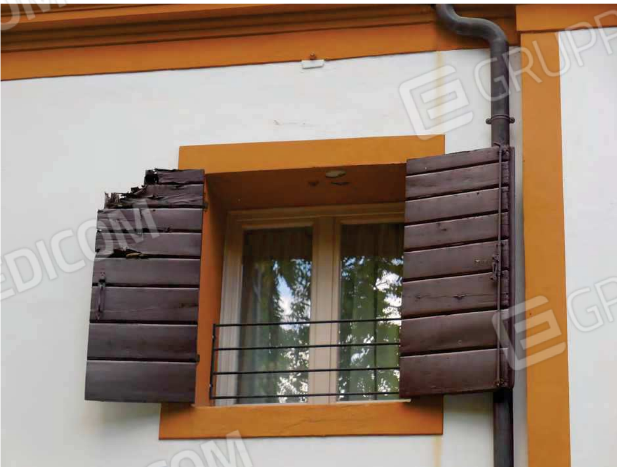
Foto 21 - vista esterna del fabbricato particolare finestra facciata sud (Via Traversi)
