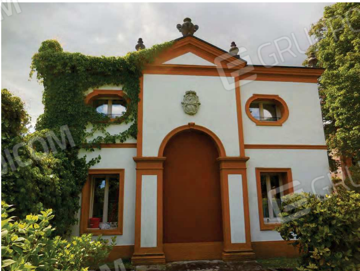
Foto 10 - vista esterna del fabbricato dal parco facciata est
