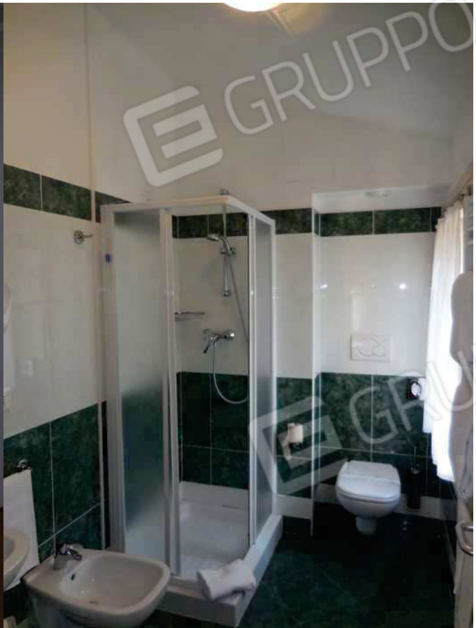
Foto 106 - piano primo – camera 112 -bagno
