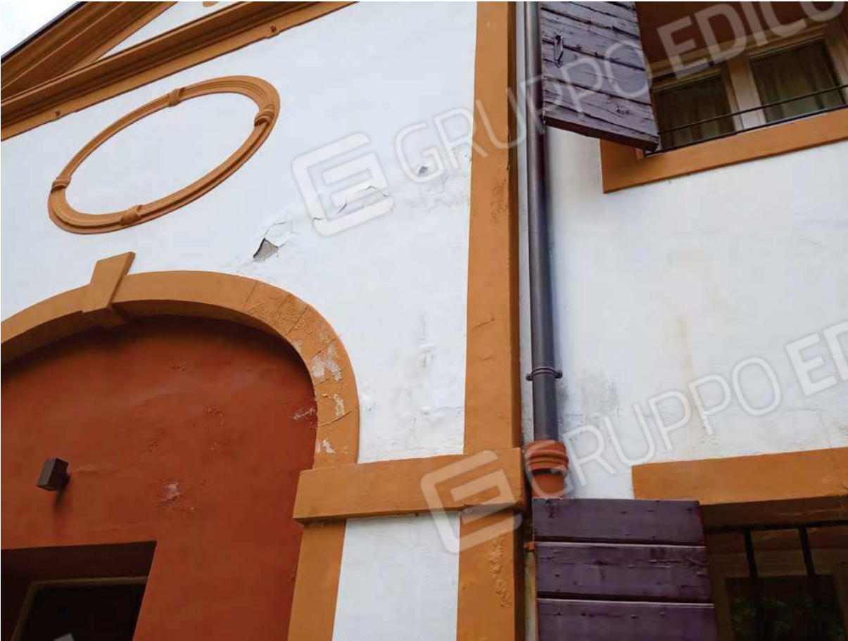
Foto 20 - vista esterna del fabbricato particolare facciata sud (Via Traversi)
