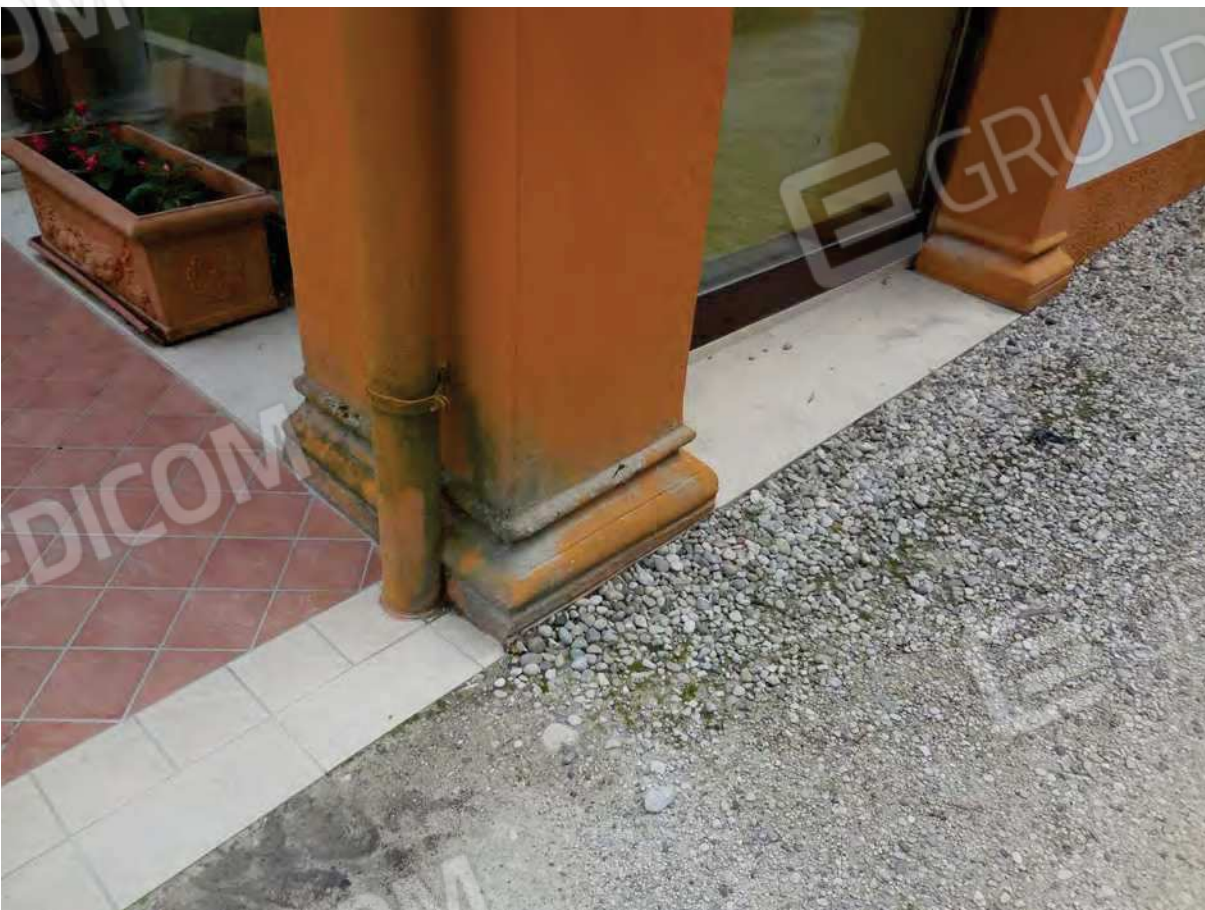
Foto 19 - vista esterna del fabbricato particolare angolo nord-ovest
