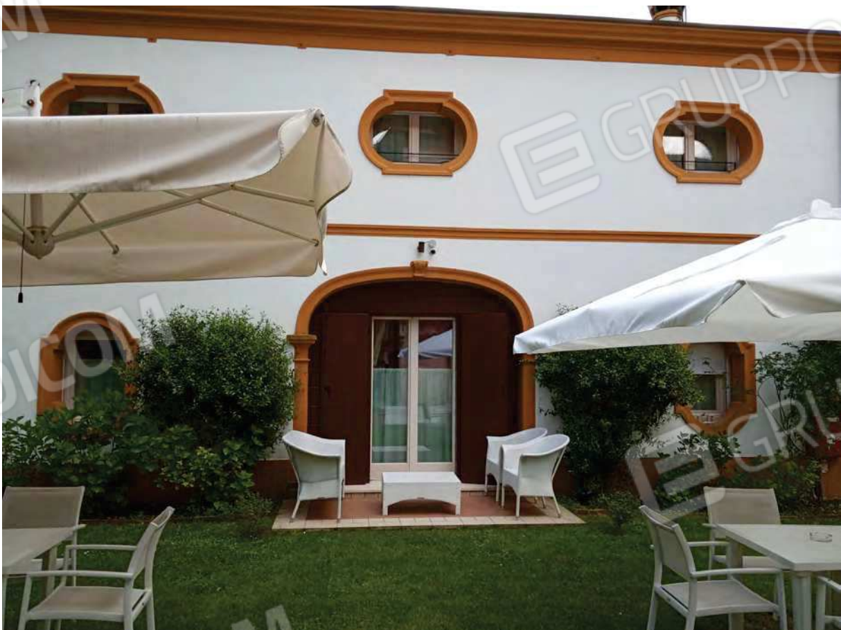
Foto 6 - vista esterna del fabbricato dal parco
