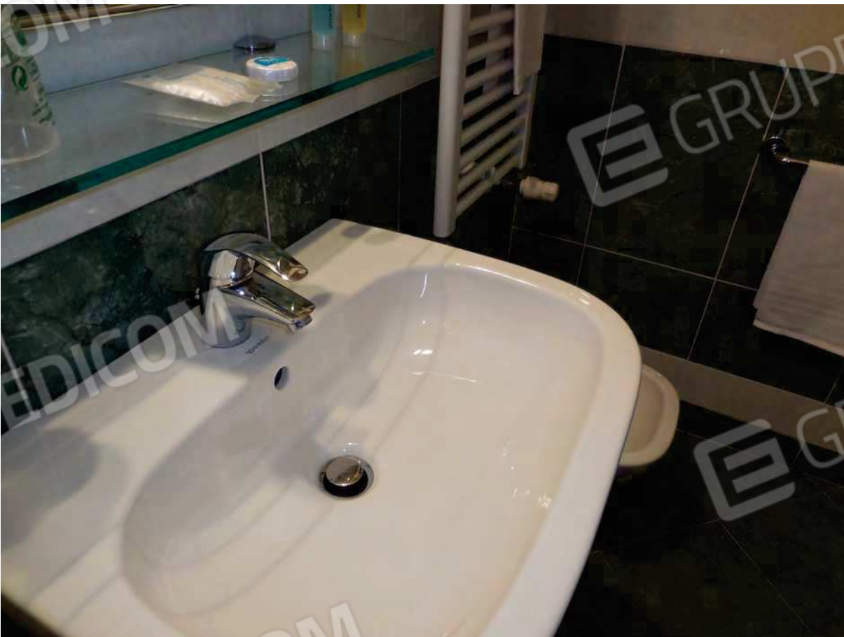
Foto 48 - piano terra – camera n. 03 - bagno
