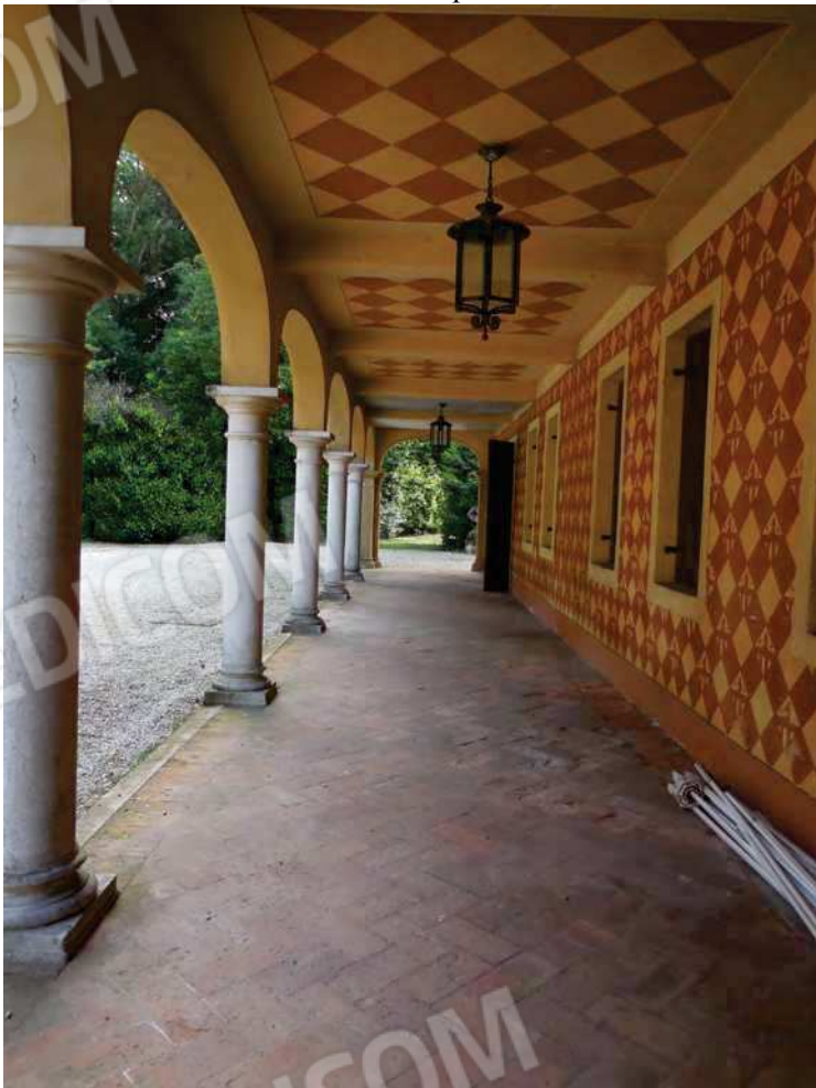
Foto 15- vista esterna del fabbricato portico - facciata nord
