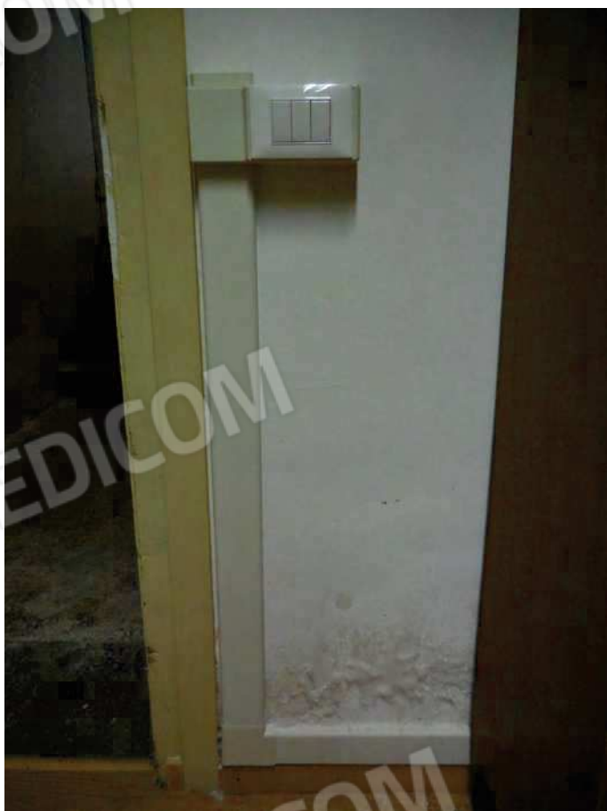
Foto 15 - interno sub 5 – locale n.1 – particolare
