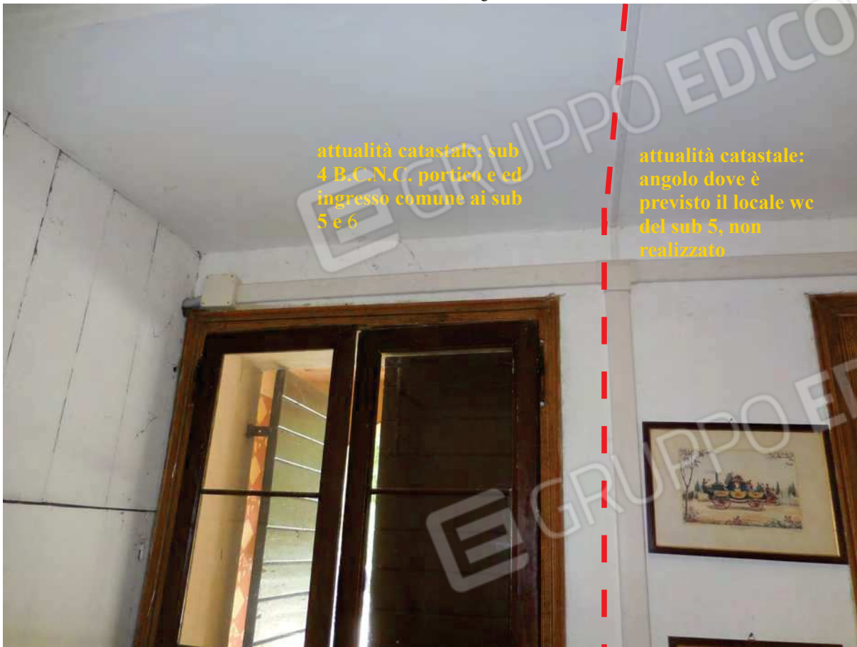
Foto 9 – interno - attualità catastale: sub 4 B.C.N.C. portico e ed ingresso comune ai sub 5 e 6 – porta d'ingresso comune
