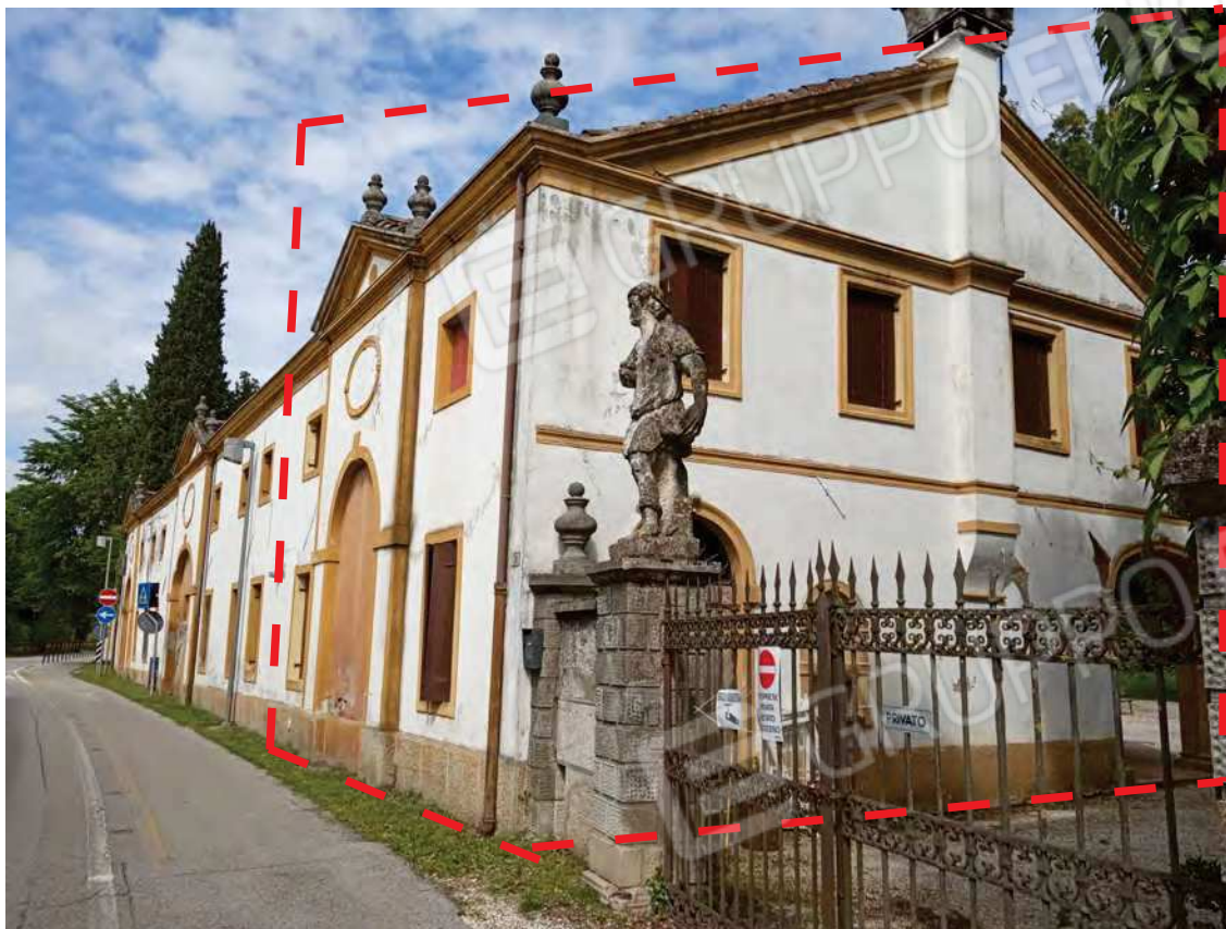
Foto 1 - vista esterna fabbricato con accesso carraio e pedonale da Via Madonnetta
