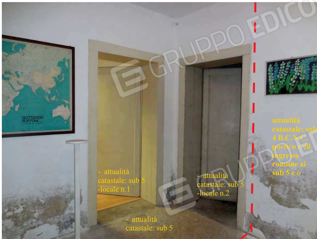
Foto7 – interno – sub 5 porte d'ingresso ai locali n.1 e n.2
