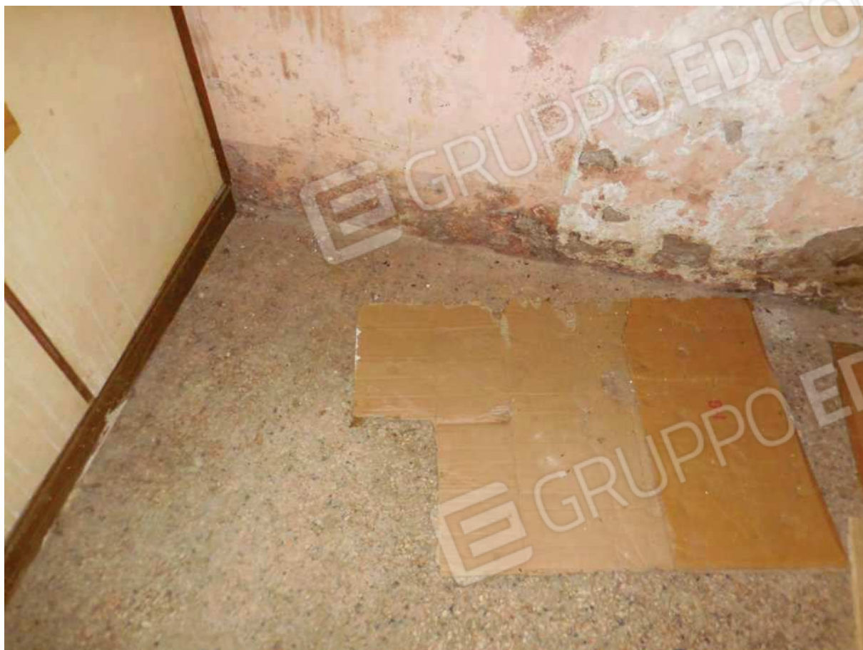
Foto 22 – interno – sub 5 locale n.2 – particolare pavimento
