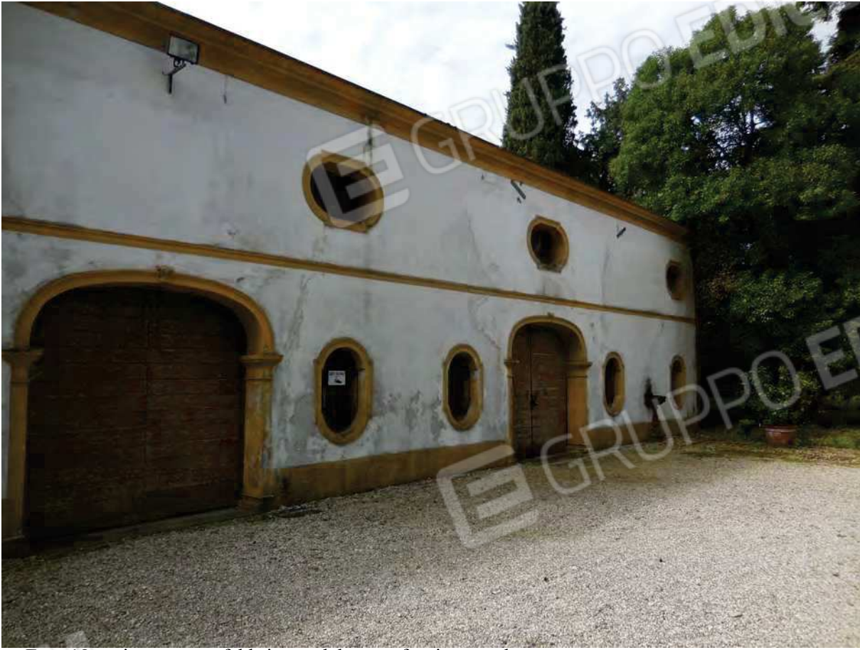
Foto 12 - vista esterna fabbricato dal parco facciata nord
