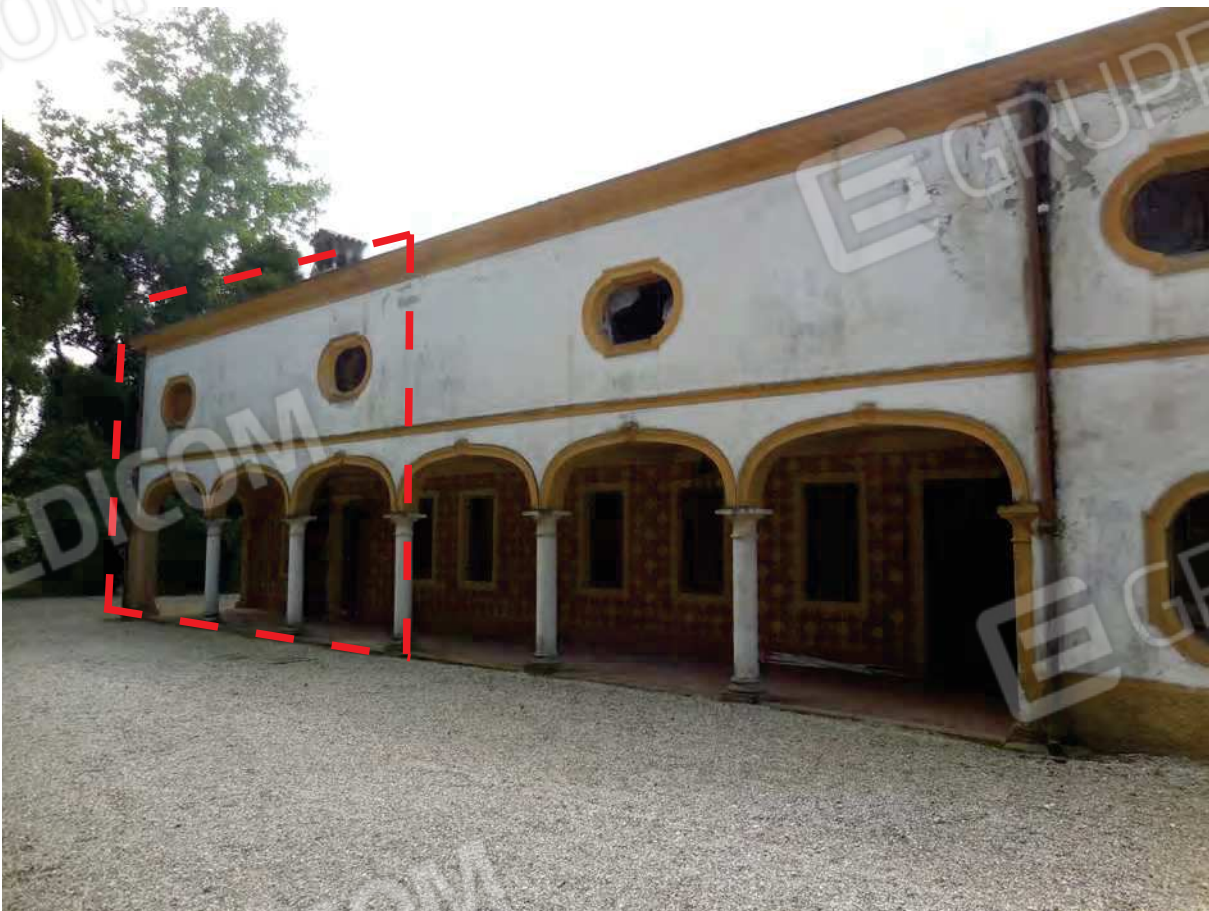
Foto 11 - vista esterna fabbricato dal parco facciata nord
