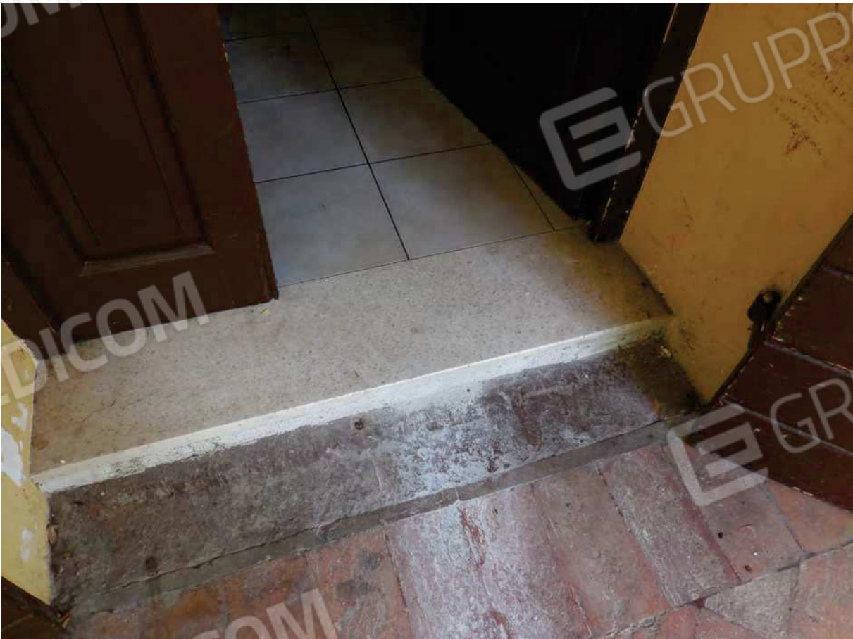
Foto 17- piano terra - soglia ingresso abitazione
