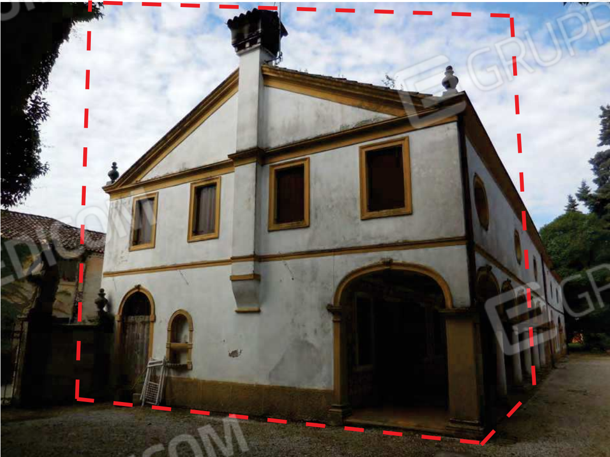
Foto 9- vista esterna del fabbricato dal parco facciata est
