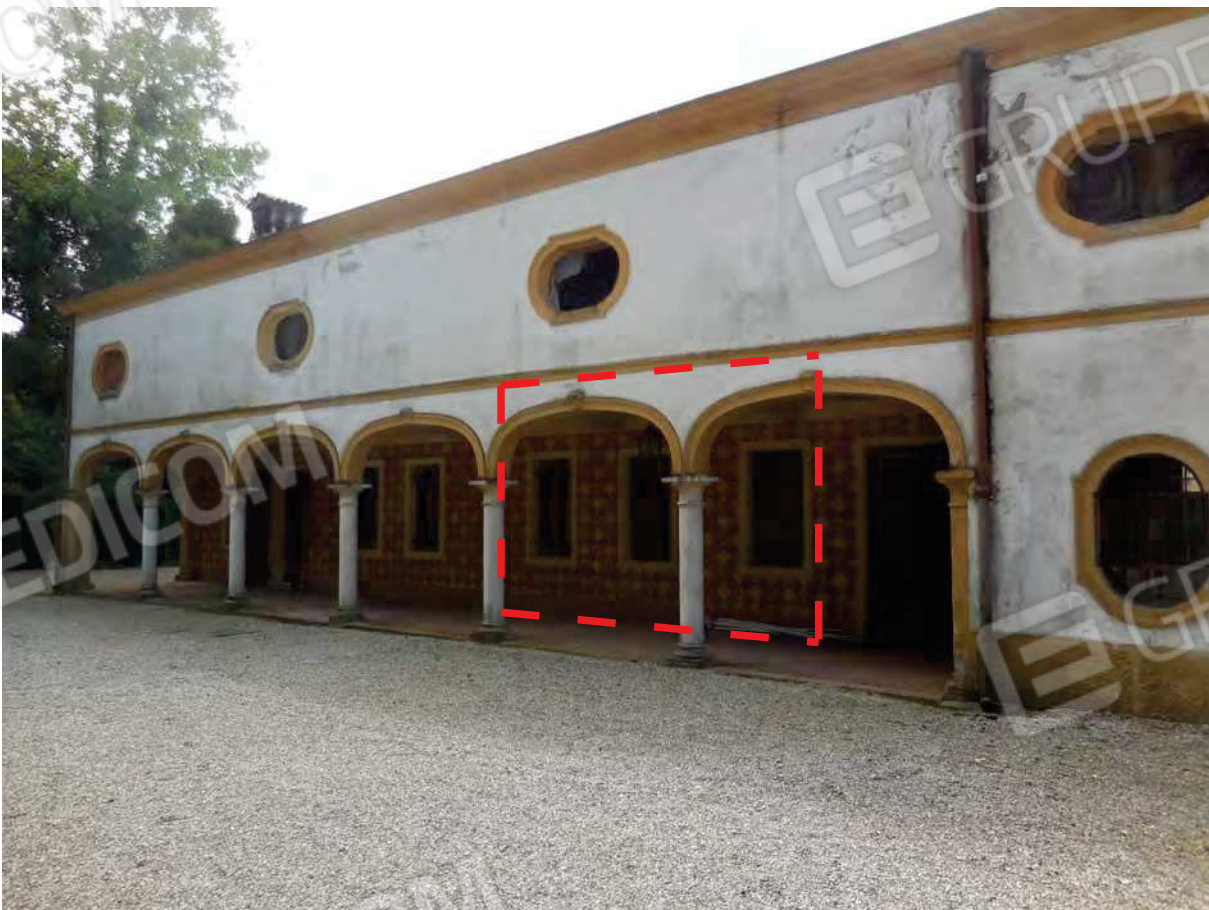
Foto 2 - vista esterna del fabbricato lato nord dal parco
