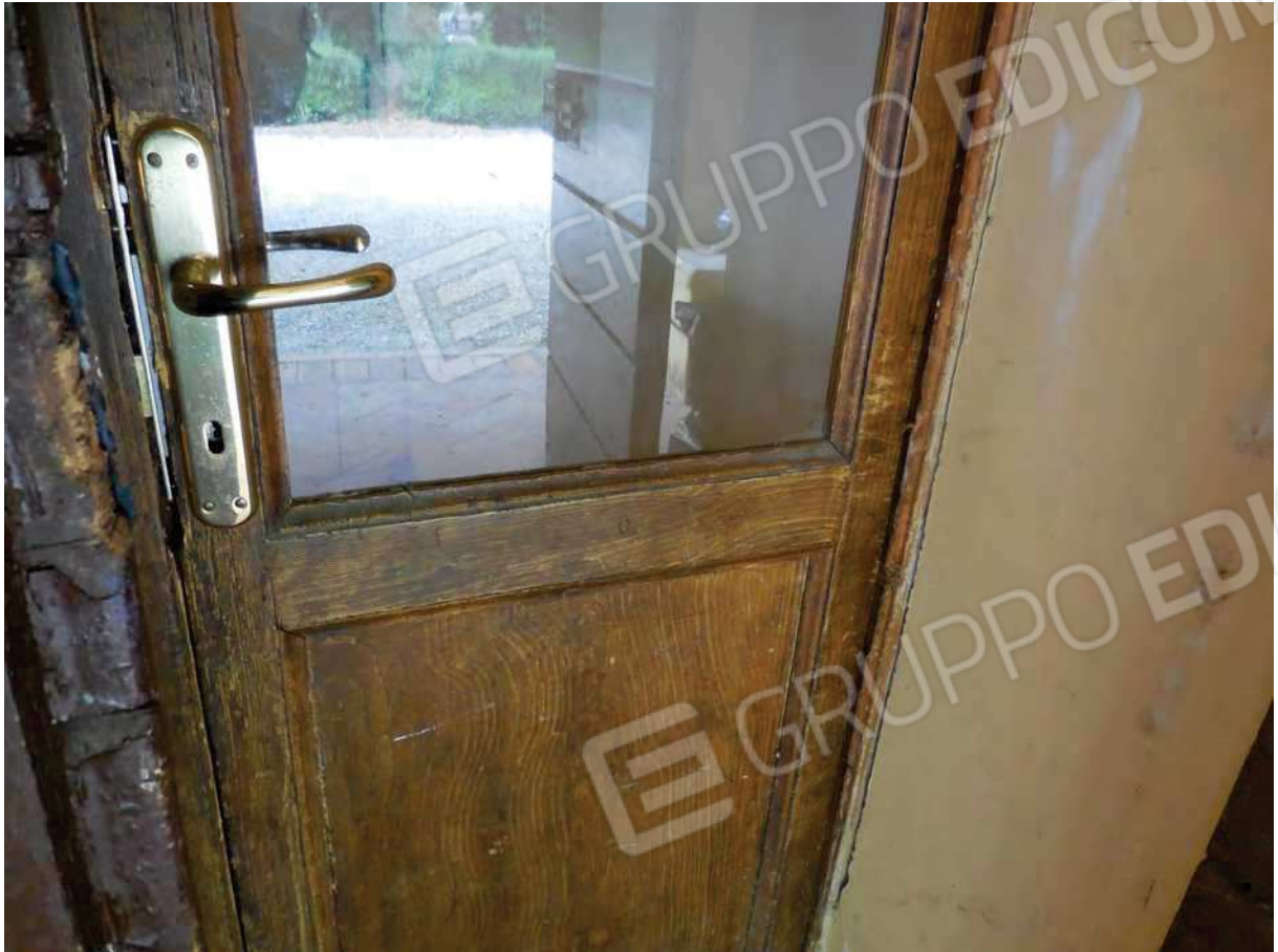
Foto 5 - vista esterna fabbricato porta d'ingresso al vano comune - attualità catastale: sub 4 B.C.N.C. portico e ed ingresso comune ai sub 5 e 6
