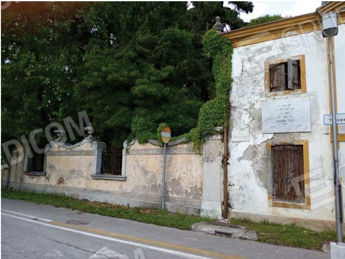
Foto 4 - vista esterna del fabbricato da Via Traversi/Via Madonnetta – muro di cinta del Complesso Monumentale
