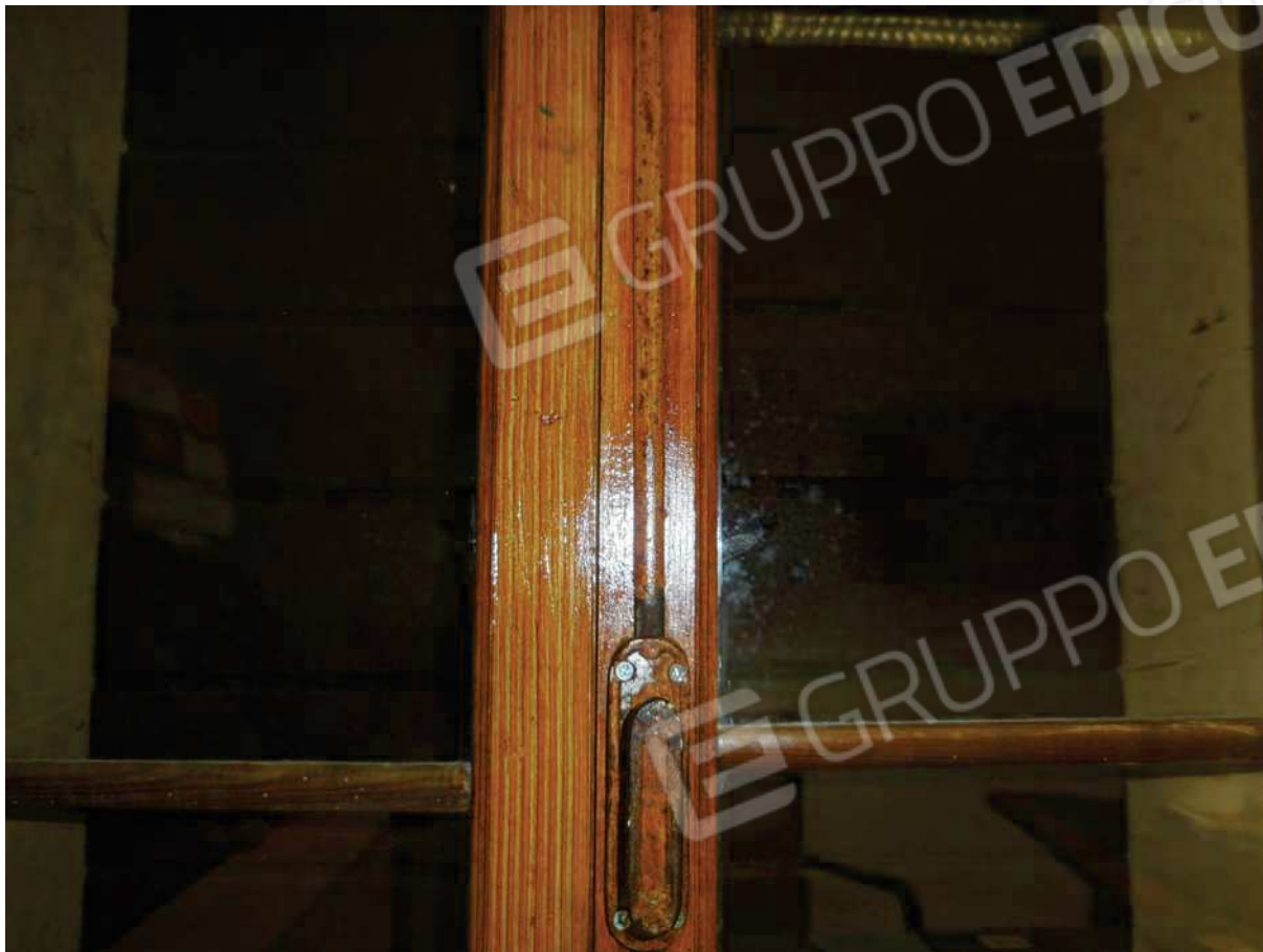
Foto 14 - interno sub 5 – locale n.1 – particolare finestra
