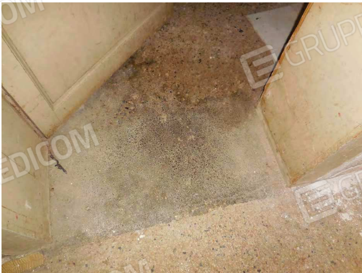
Foto 17 – interno – sub 5 soglia porta di accesso al locale n.2
