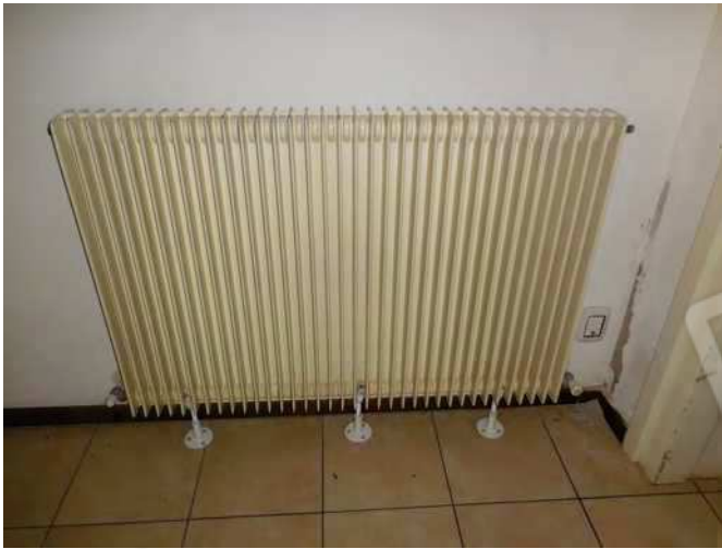
Foto 20 - piano terra - soggiorno – particolare
