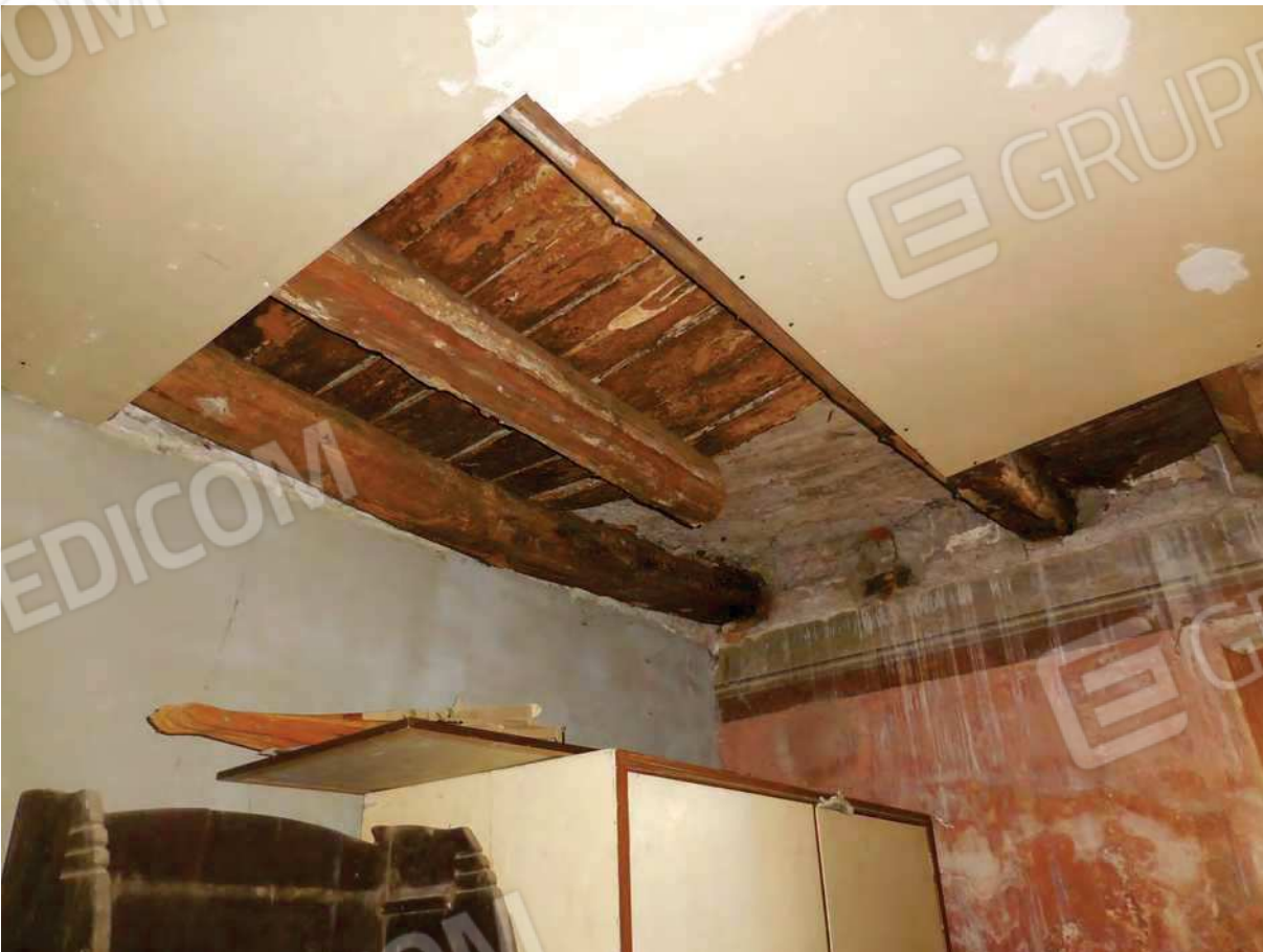
Foto 19 – interno – sub 5 locale n.2
