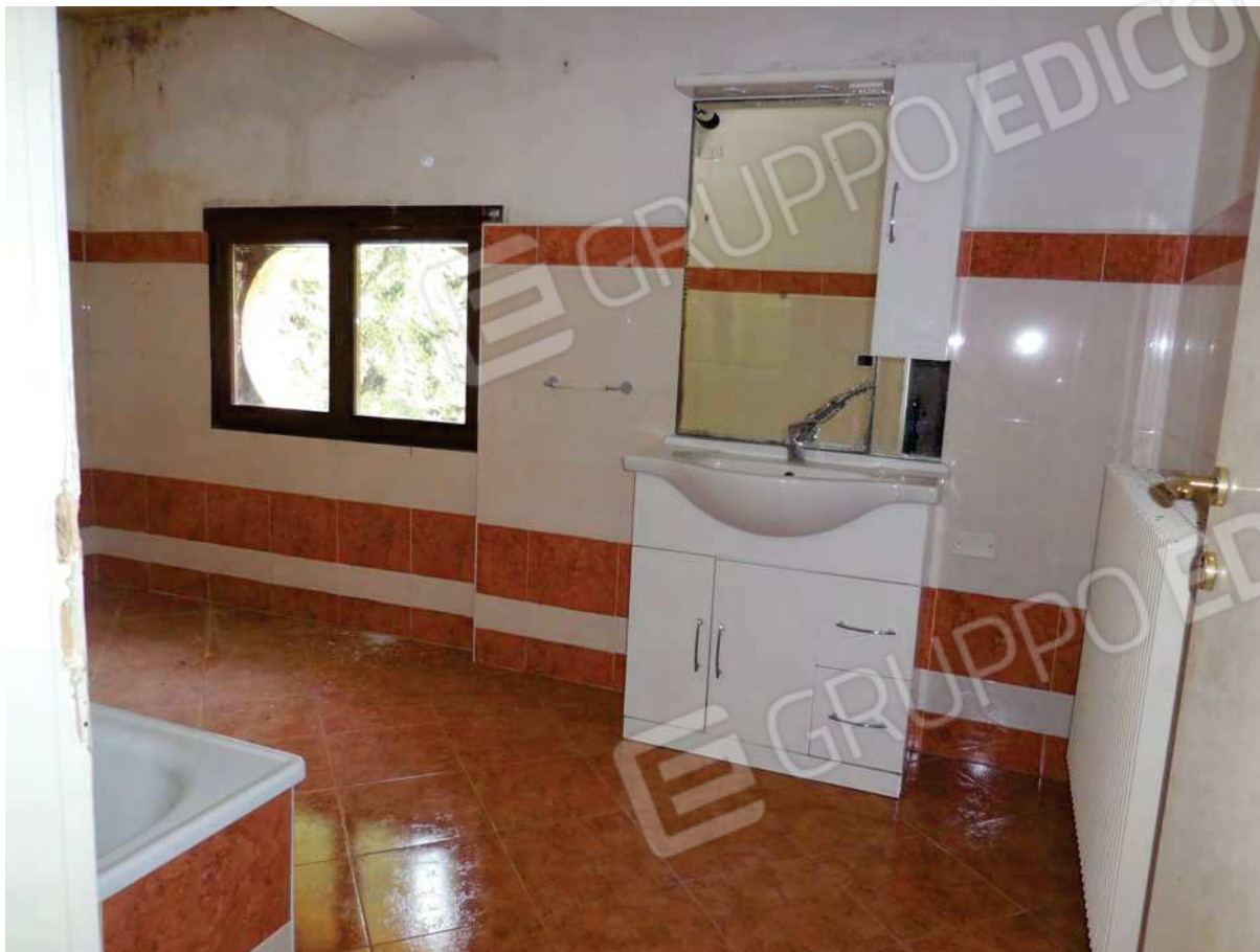
Foto 32 - piano primo, bagno
