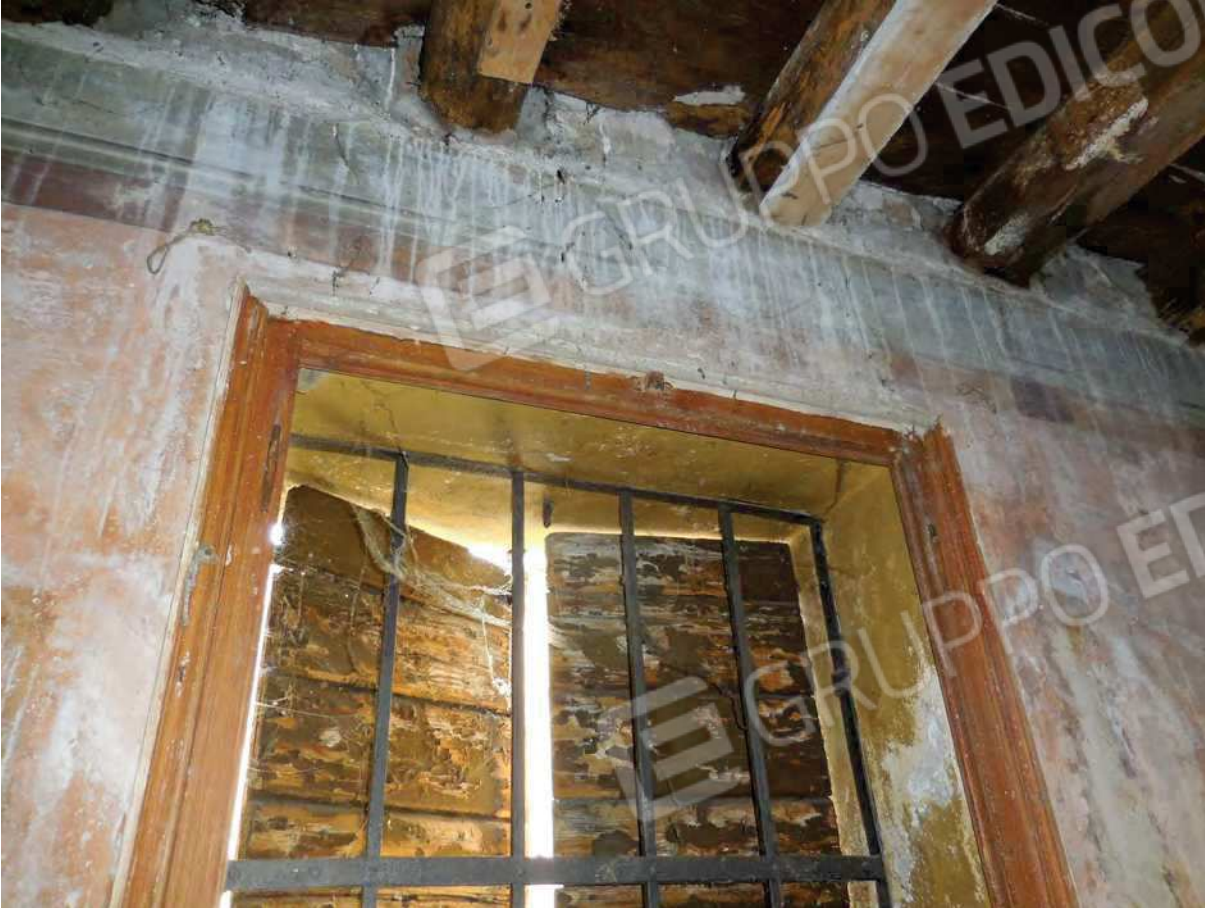
Foto 20 – interno – sub 5 locale n.2 – particolare finestra
