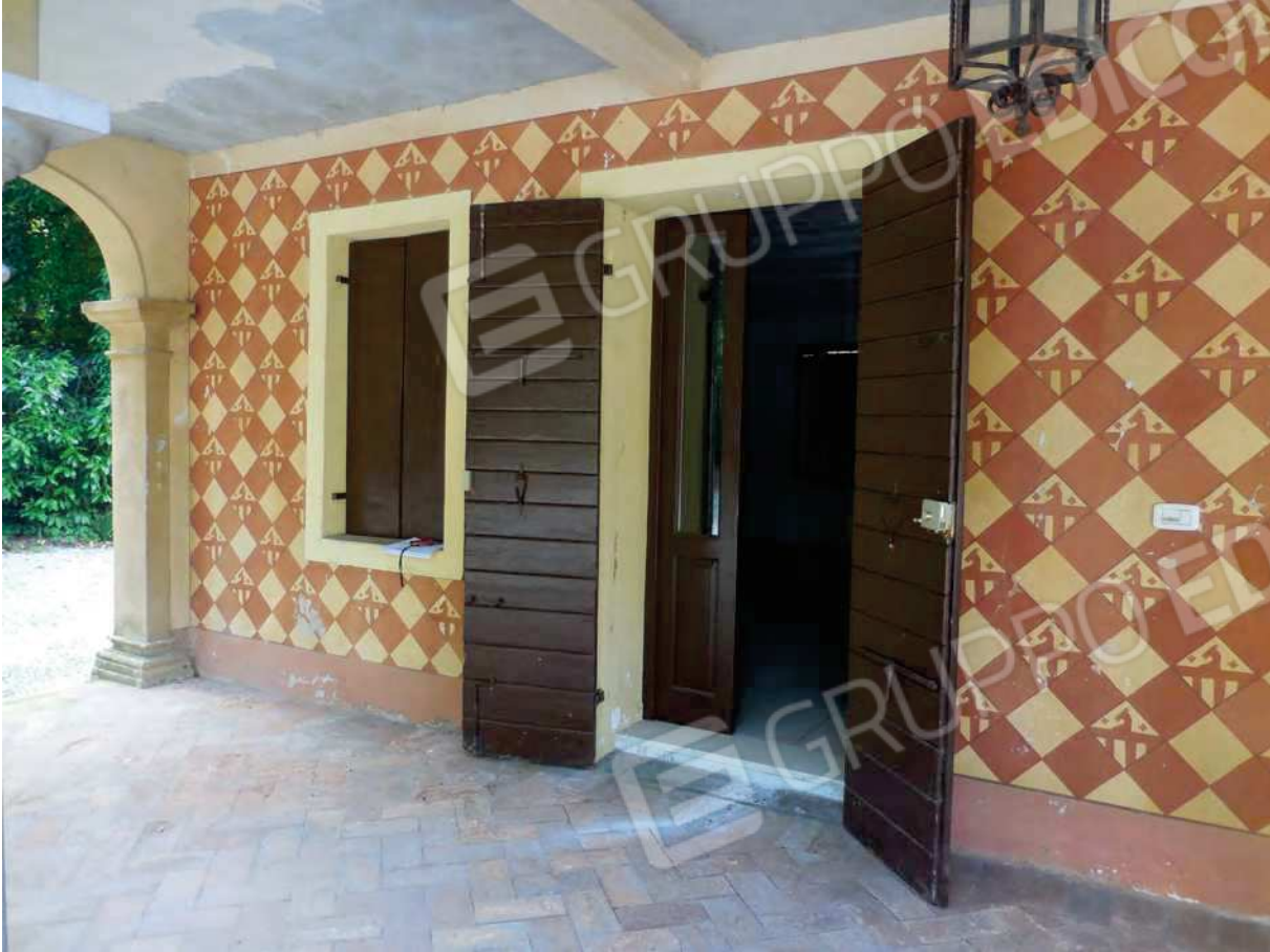
Foto 16 - vista esterna fabbricato- portico e porta d'ingresso abitazione
