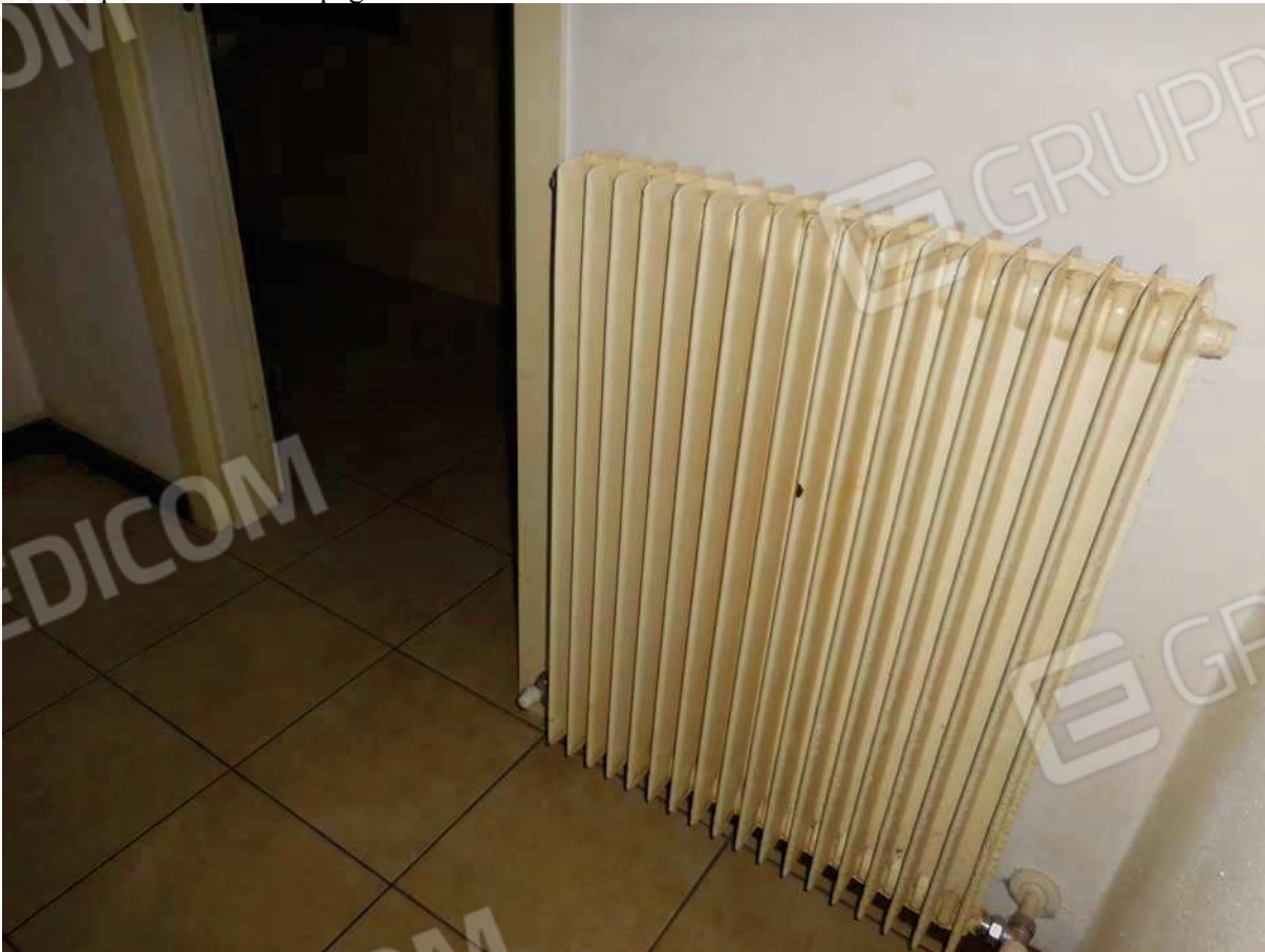
Foto 24- piano terra - disimpegno
