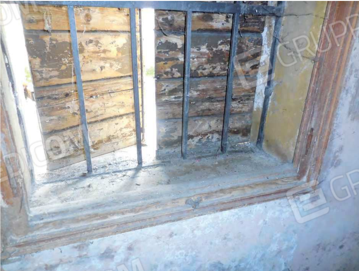
Foto 21 – interno – sub 5 locale n.2 – particolare finestra
