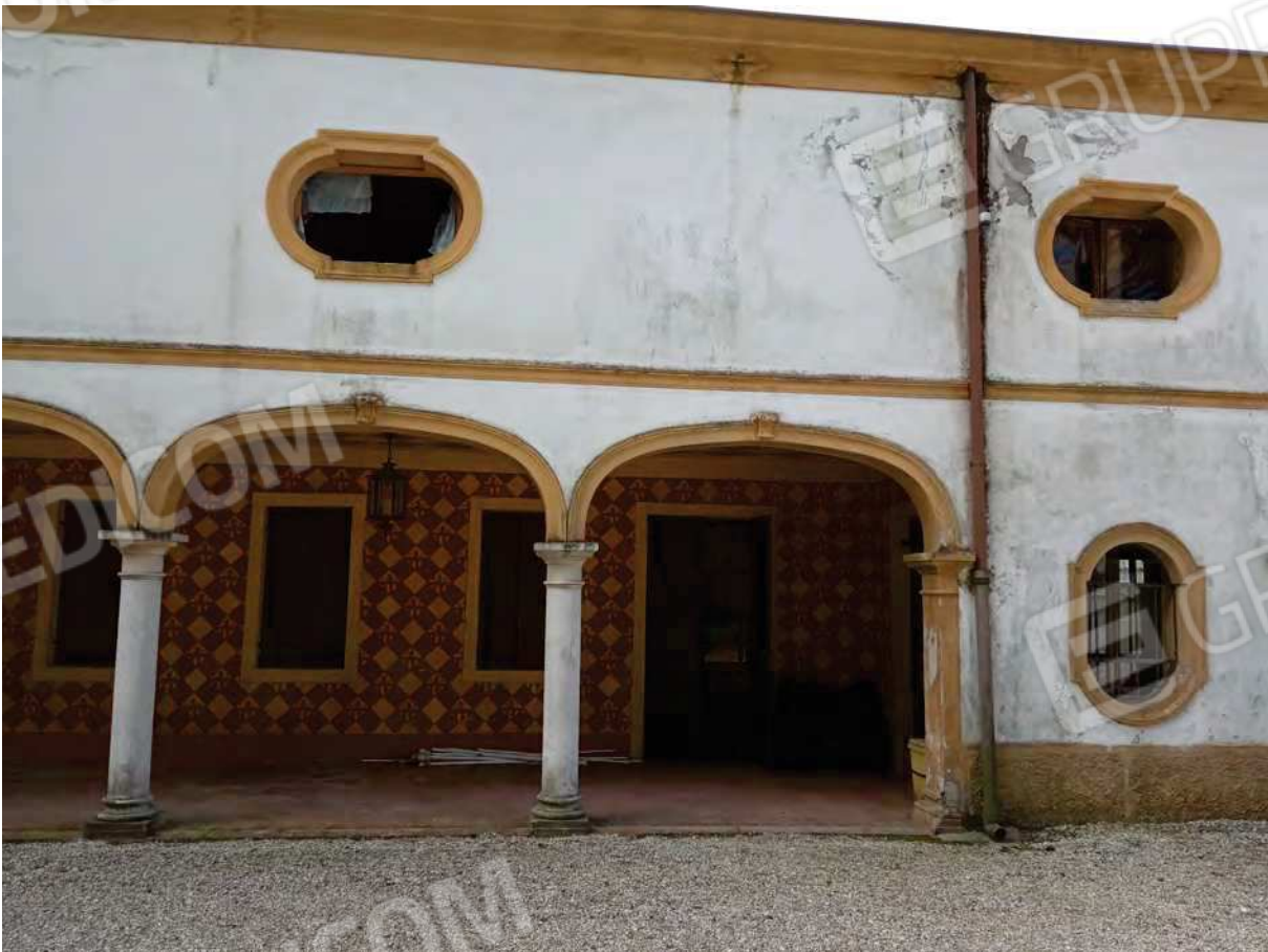
Foto 13 - vista esterna fabbricato dal parco facciata nord
