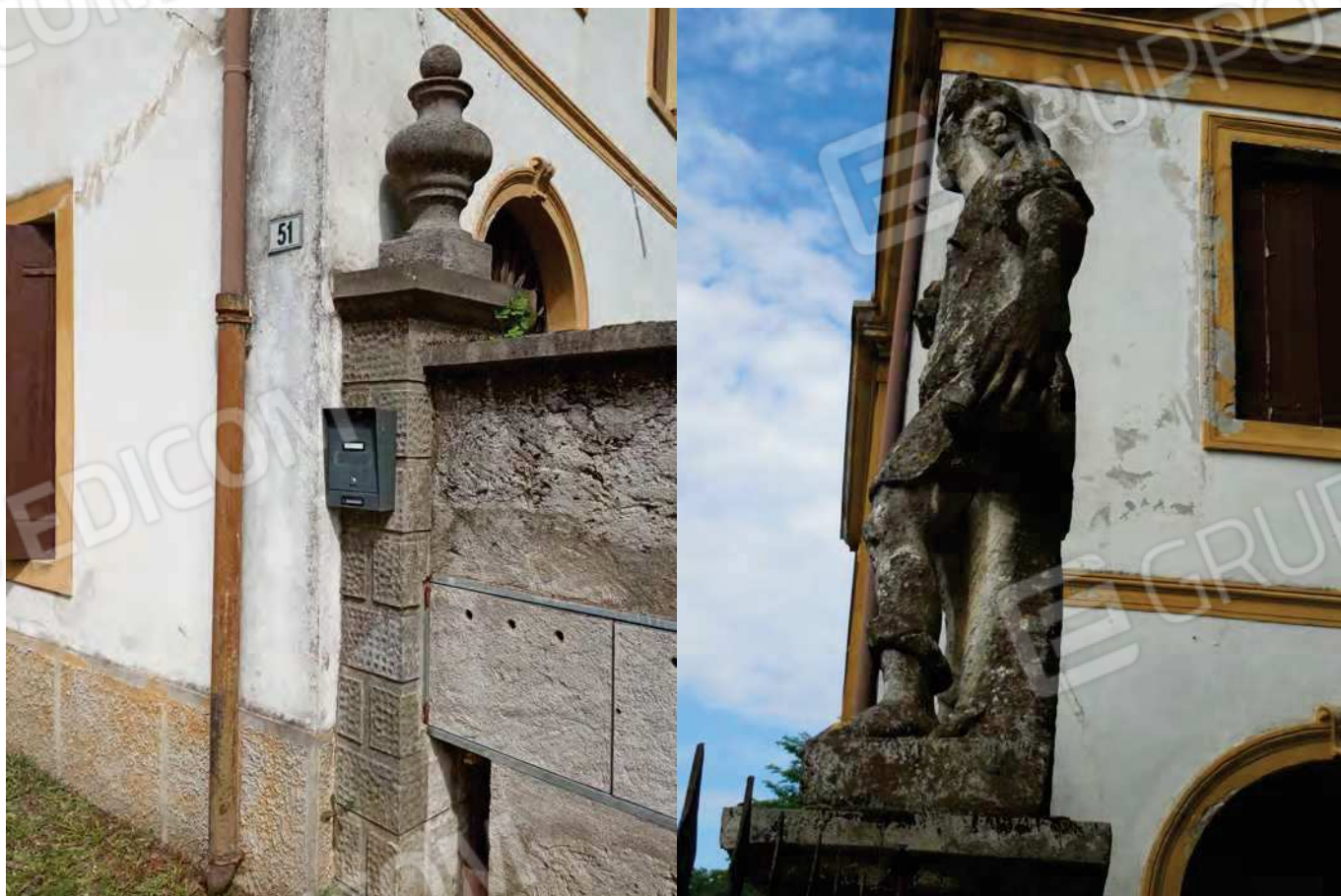
Foto 6 - 7- vista esterna del fabbricato da Via Madonnetta – particolari ingresso carrabile e pedonale
