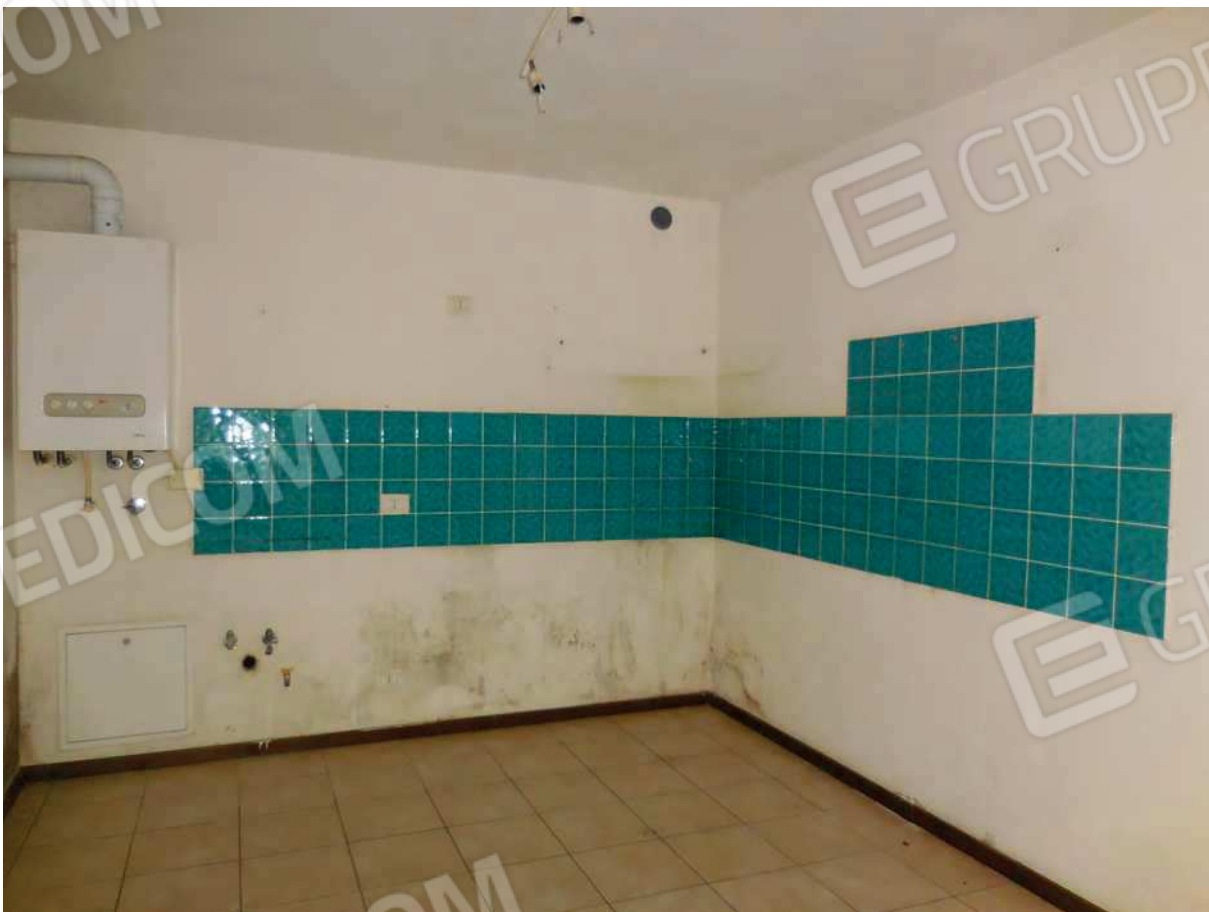
Foto 22- piano terra - cucina
