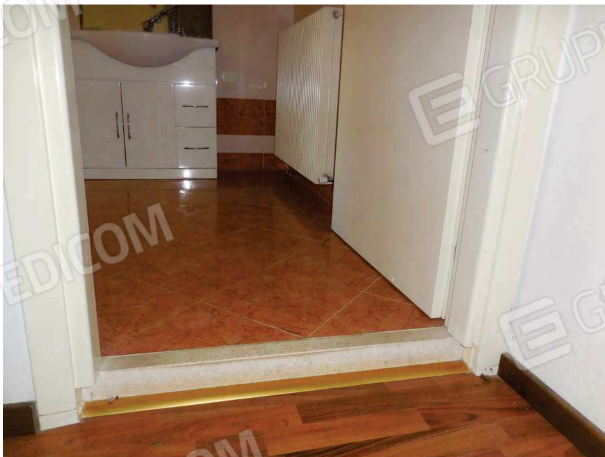
Foto 31- piano primo particolare soglia bagno
