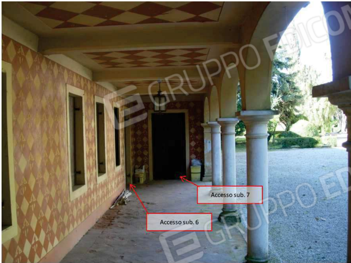
FOTO 7 – PORZIONE DI PORTICO COMUNE
