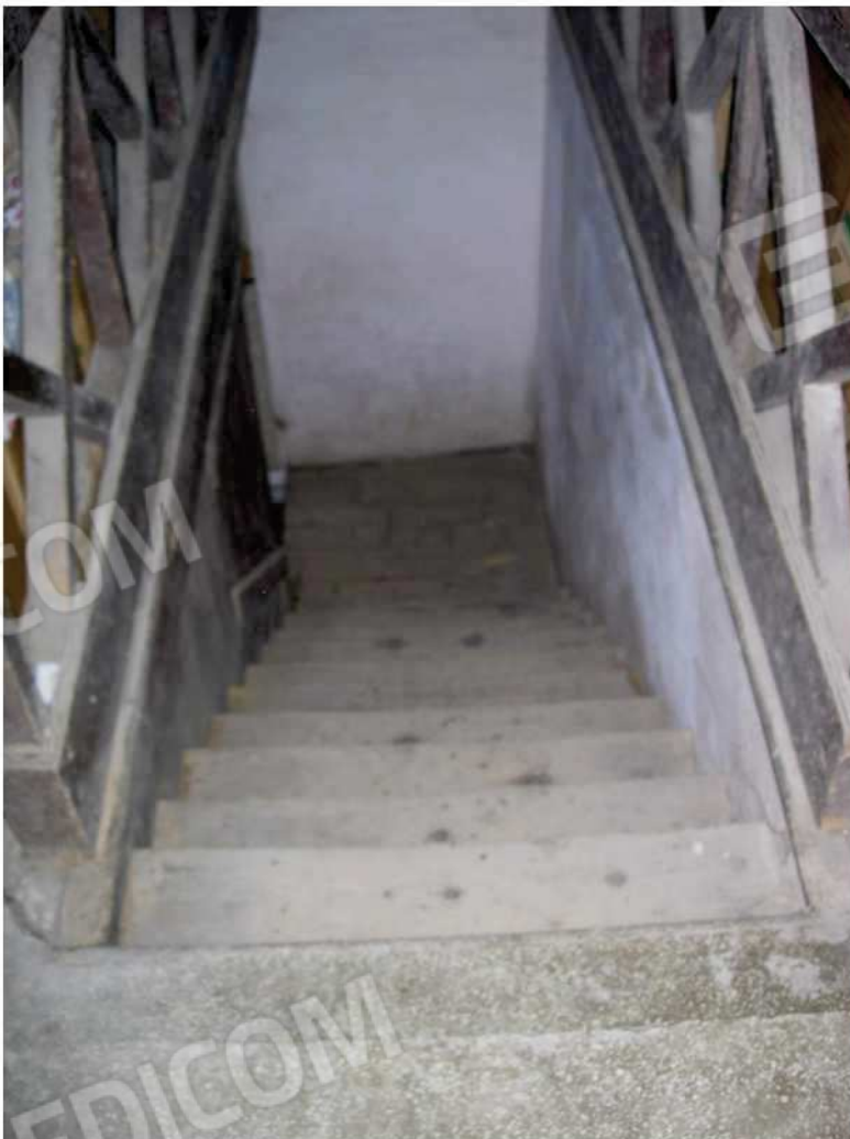
FOTO 16 SCALA DI ACCESSO AL SUB. 6
