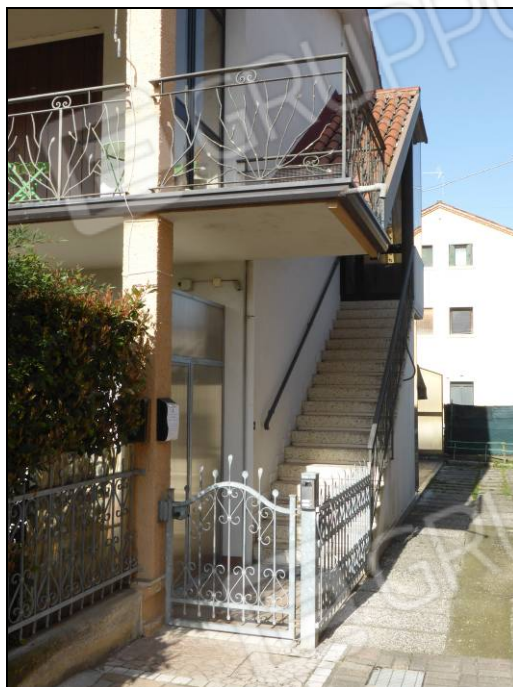
Foto n. 7 – Cancelli pedonale comune e scala esterna di accesso al piano primo
