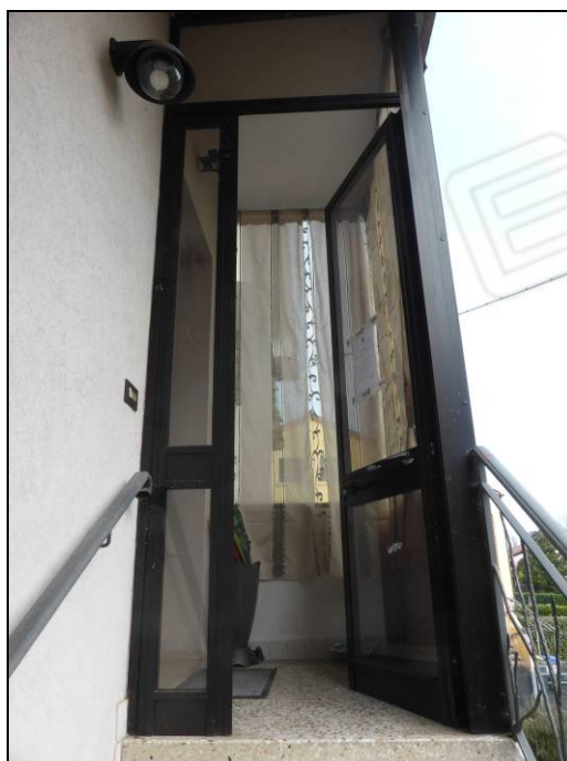
Foto n. 8 – Loggia di ingresso realizzata sul pianerottolo della scala esterna
