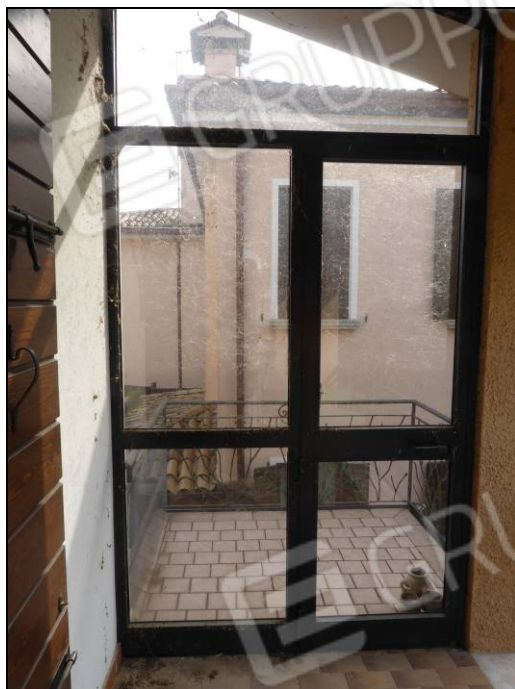
Foto n. 13 – Terrazza sud (porzione sopra la scala esterna)
