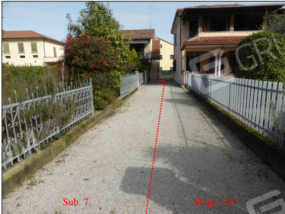
Foto n. 2 – Dettaglio dell'accesso carraio e pedonale (promiscuo)
