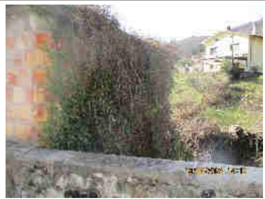
Foto n. 19: garage lato esterno Nord
