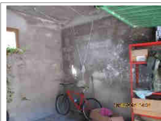
Foto n. 19: garage dall'interno verso Nord-Ovest
