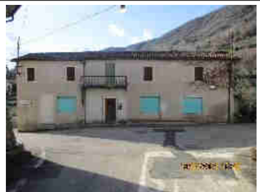
Foto n. 4: prospetto Est del fabbricato
