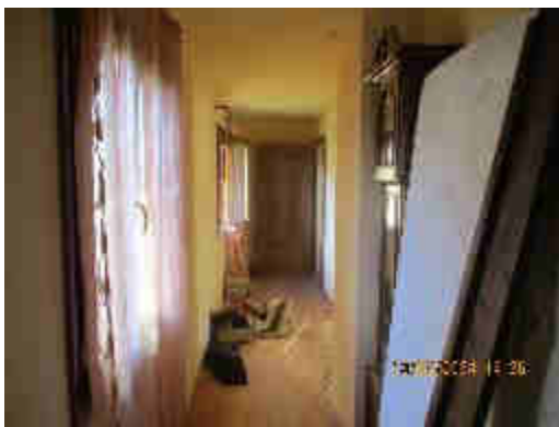
Foto n. 15: P1 corridoio verso il vano scala
