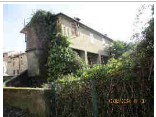
Foto n. 2: prospetto Nord-Ovest del fabbricato
