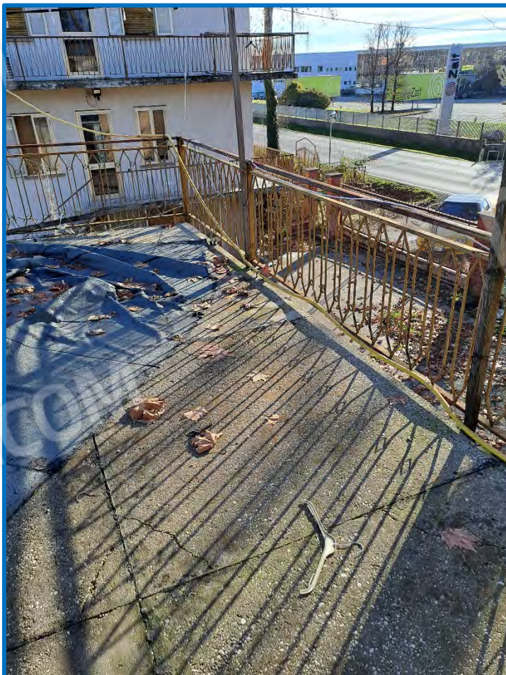
n° 52 – Esterno laboratorio – terrazza est
