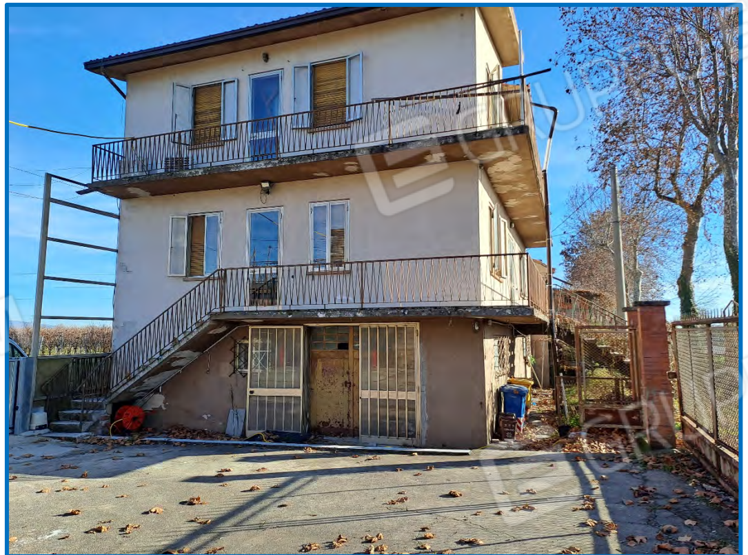
n° 4 - Abitazione – esterno ovest
