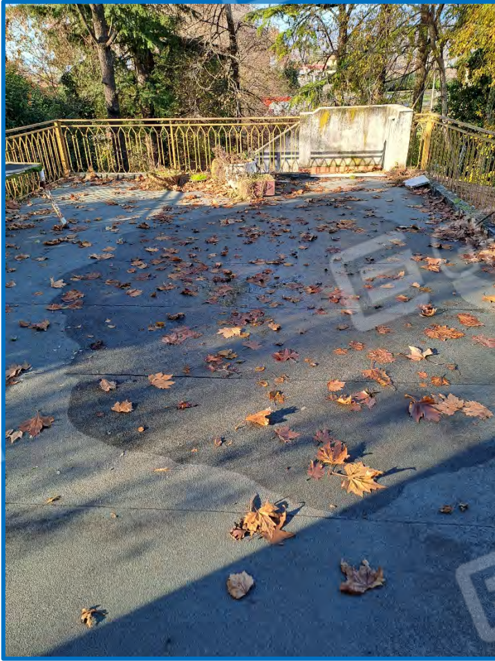
n° 49 – Esterno laboratorio – terrazza ovest
