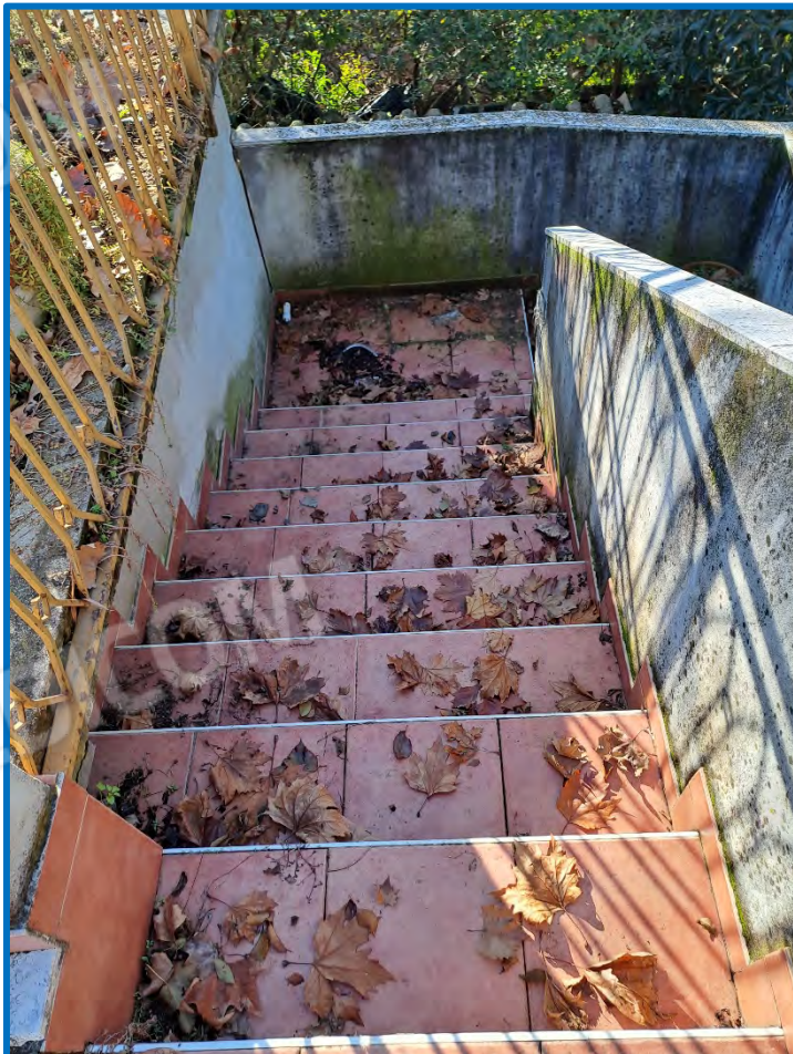
n° 50 – Esterno laboratorio – scala esterna ovest
