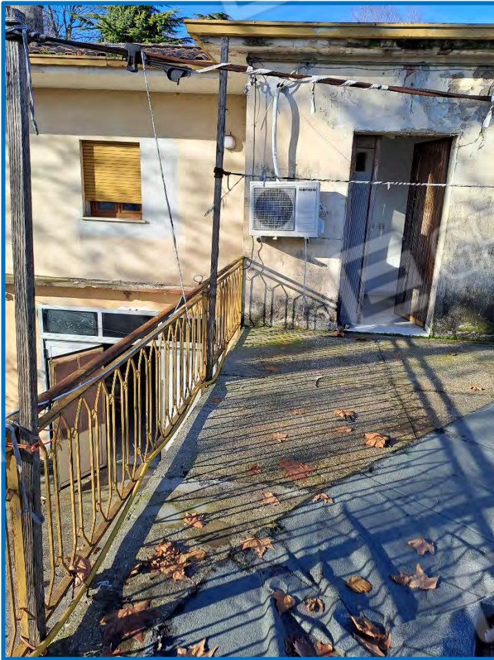
n° 51 – Esterno laboratorio – terrazza est
