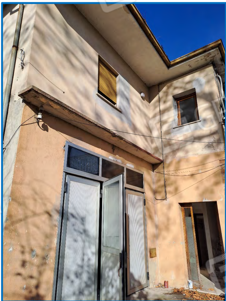
n° 9 Laboratorio – esterno est
