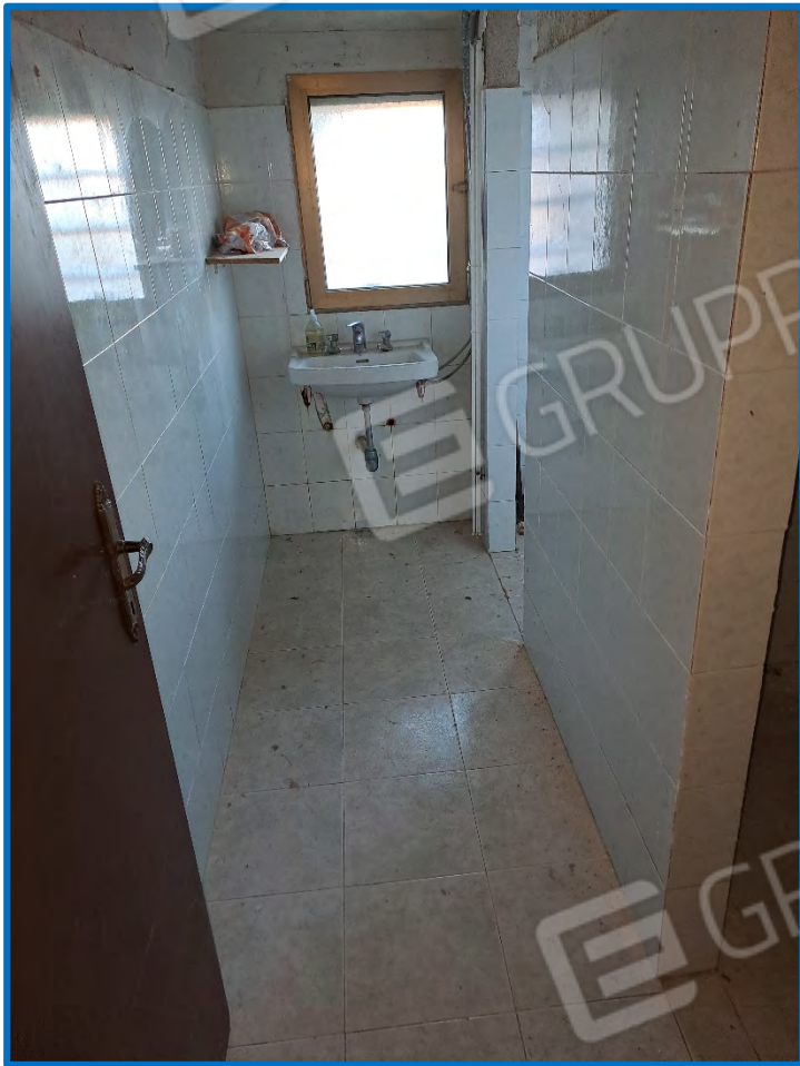
n° 31 – Interno laboratorio – piano terra
