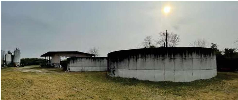
Le due vasche di raccolta dei liquami presentano la medesima forma circolare, sono realizzate in cemento armato e presentano le seguenti dimensioni: un diametro di circa 14,50 per uno sviluppo planimetrico di circa 165 mq, murature perimetrali in elevazione di circa 6 ml di altezza, di cui la metà si eleva fuori terra.
