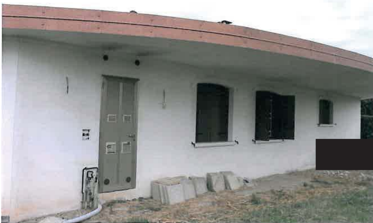
Fotografia 4: il fronte nord est
