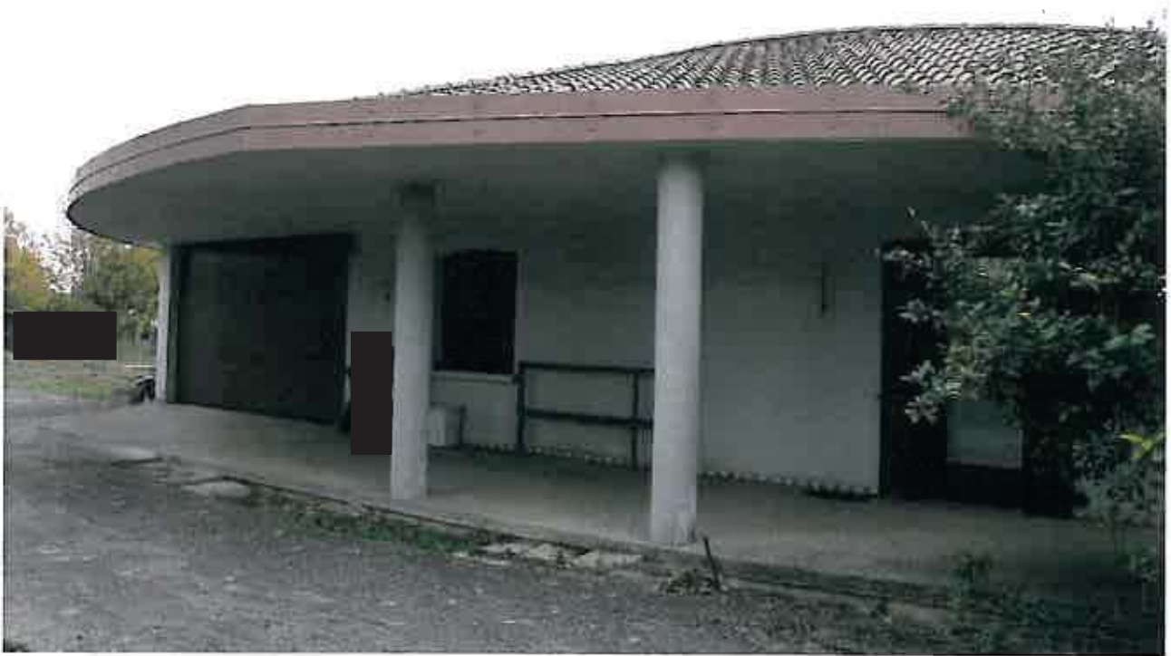
Fotografia 5: il fronte nord-ovest
