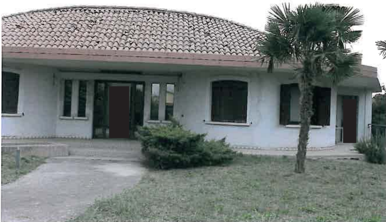
Fotografia 2: l'ingresso principale all'abitazione
