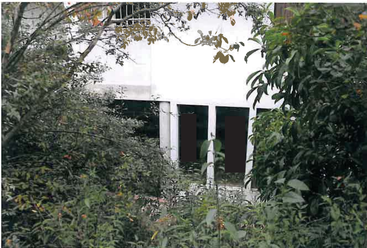
Fotografia 3: l'ingresso al piano interrato dal lato sud est
