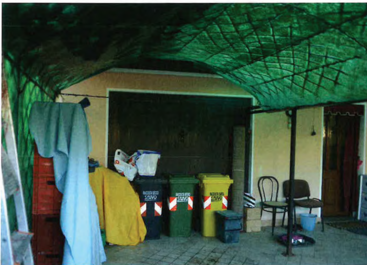
Foto n. 24 – portone garage sub e ed ingresso alloggio Piano terra
