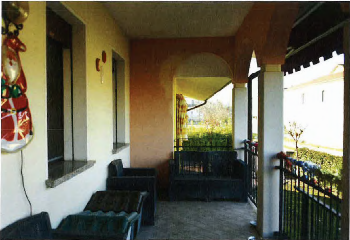
Foto n. 22 - terrazza abitazione sub 5
