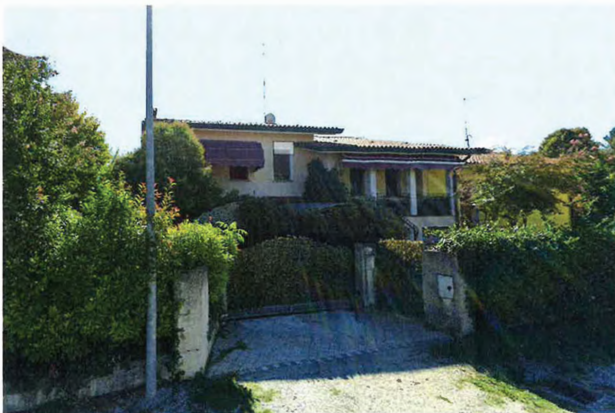
Foto n. 2 Ingresso carraio e pedonale da Via Cella
