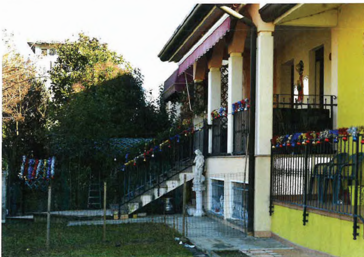
Foto n. 15 – scala accesso abitazione sub 5 e terrazza
