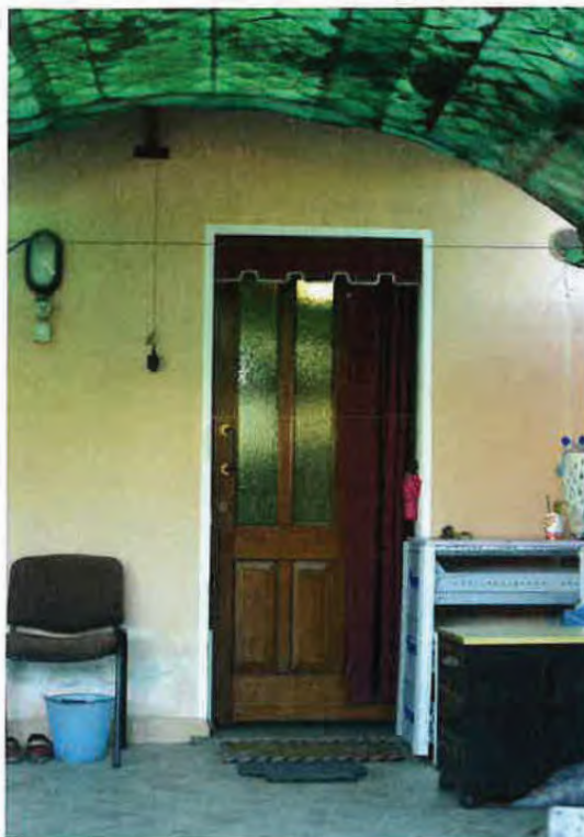
Foto n. 27 ingresso alloggio PT
