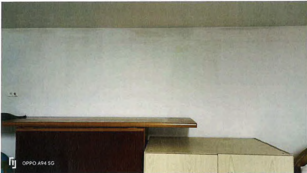
Foto n. 57 particolare parete con cartongesso su ingresso Garage sub 3
