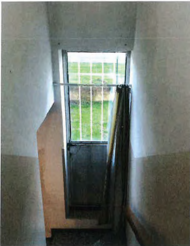
Foto n. 62 accesso est su corte di Pertinenza sub 5
