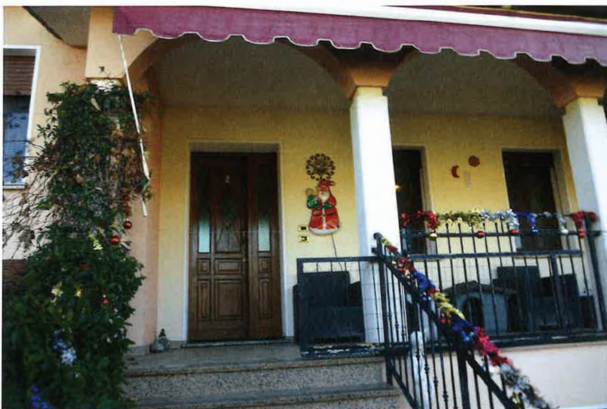
Foto n. 19 – terrazza abitazione sub 5
