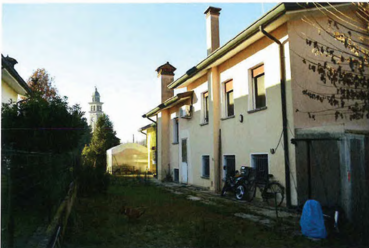
Foto n. 12 Prospetto Nord- Est e scoperto sub 4
