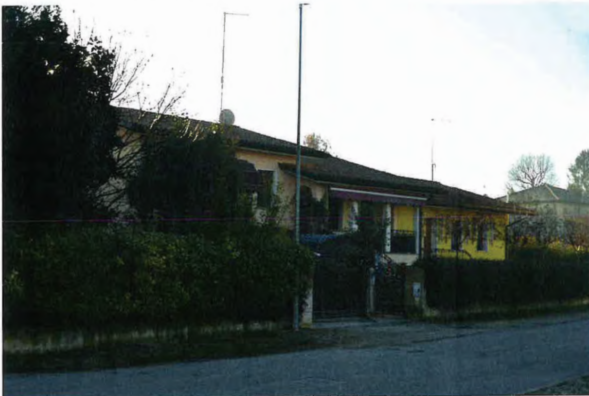
Foto n. 1 Prospetto Ovest su Via Cella
