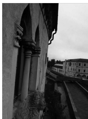
Particolare dalla balaustra lato ovest piano secondo
