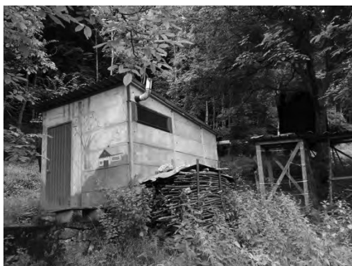
Fabbricato part. 338 lato sud
