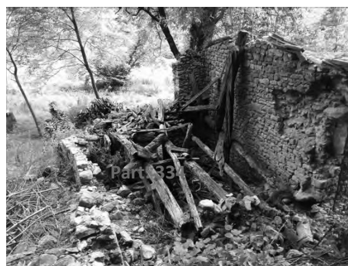
Foto da nord del fabbricato anno 2018 con i resti del piano primo
