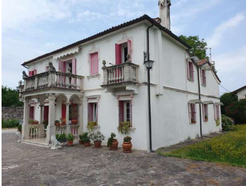
FOTO 11 : immobile lato sud-est
