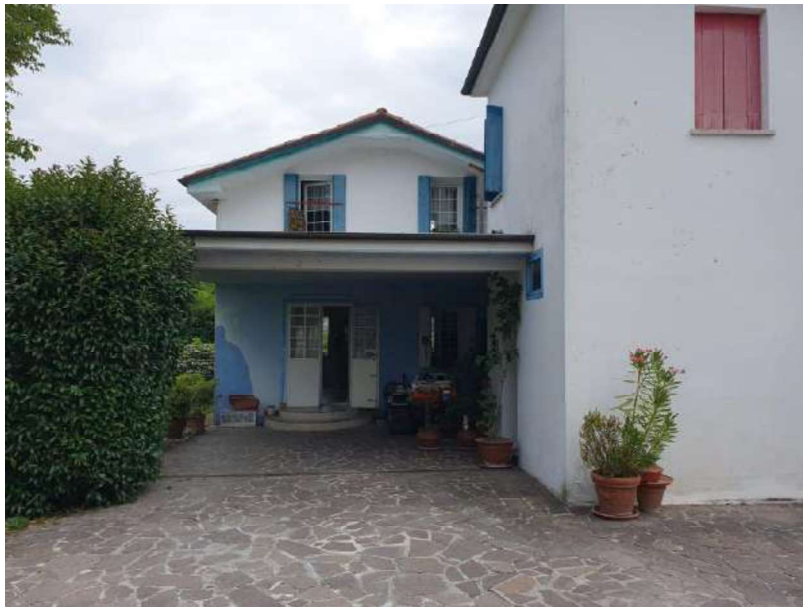
FOTO 12 : immobile lato nord-ovest
