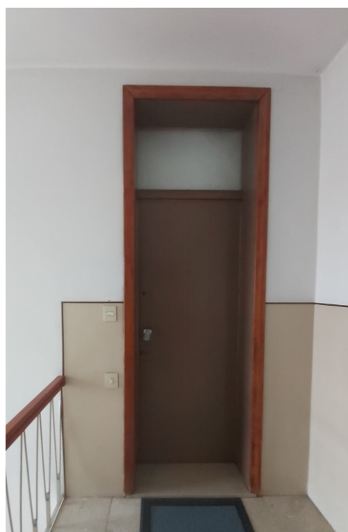
Portoncino d'ingresso all'abitazione
